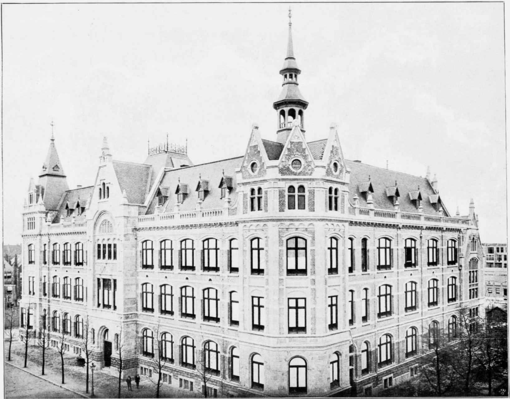
DIRECTIEGEBOUW VAN DE RIJKSPPOSTSPAARBANK TE AMSTERDAM.
