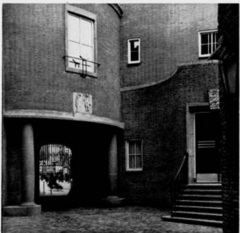
PANDPOORT GEZIEN VAN UIT DE BINNENPLAATS UITBREIDING VAN HET RAADHUIS TE HAARLEM, ARCHITECT IR. A. J. VAN DER STEUR. B.N.A.
