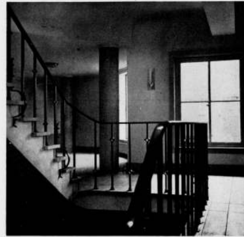
TRAPPORTEL OP 1ste VERDIEPING UITBREIDING VAN HET RAADHUIS TE HAARLEM, ARCHITECT IR. A. J. VAN DER STEUR. B.N.A.
