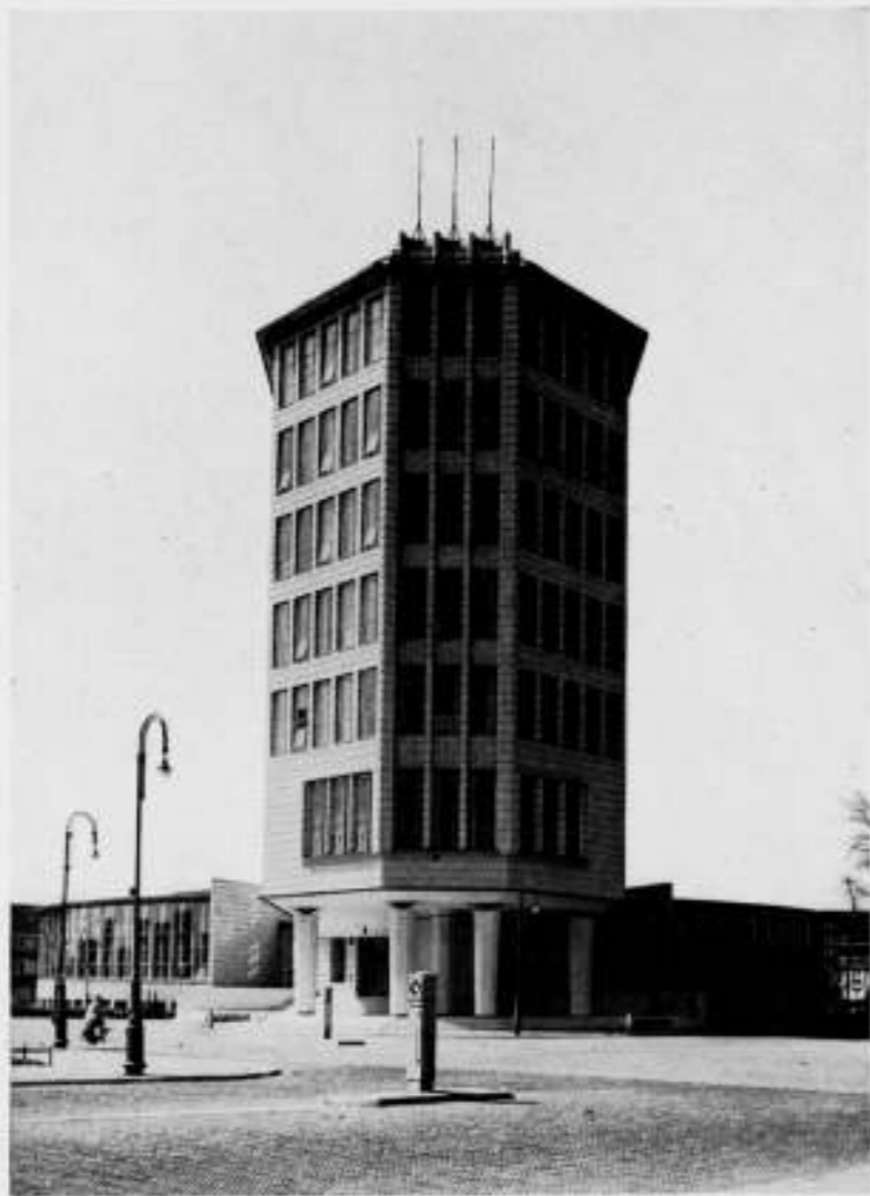
HET NIEUWE GEBOUW DER RIJKSVERZEKERINGSBANK TE AMSTERDAM, OOSTZIJDE MET PORTIEK IR. D. ROOSENBURG, ARCHITECT B.N.A.
