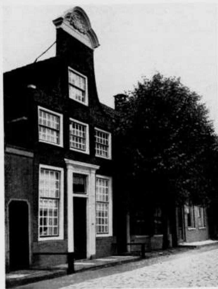
GEVEL TE ENKHUIZEN
