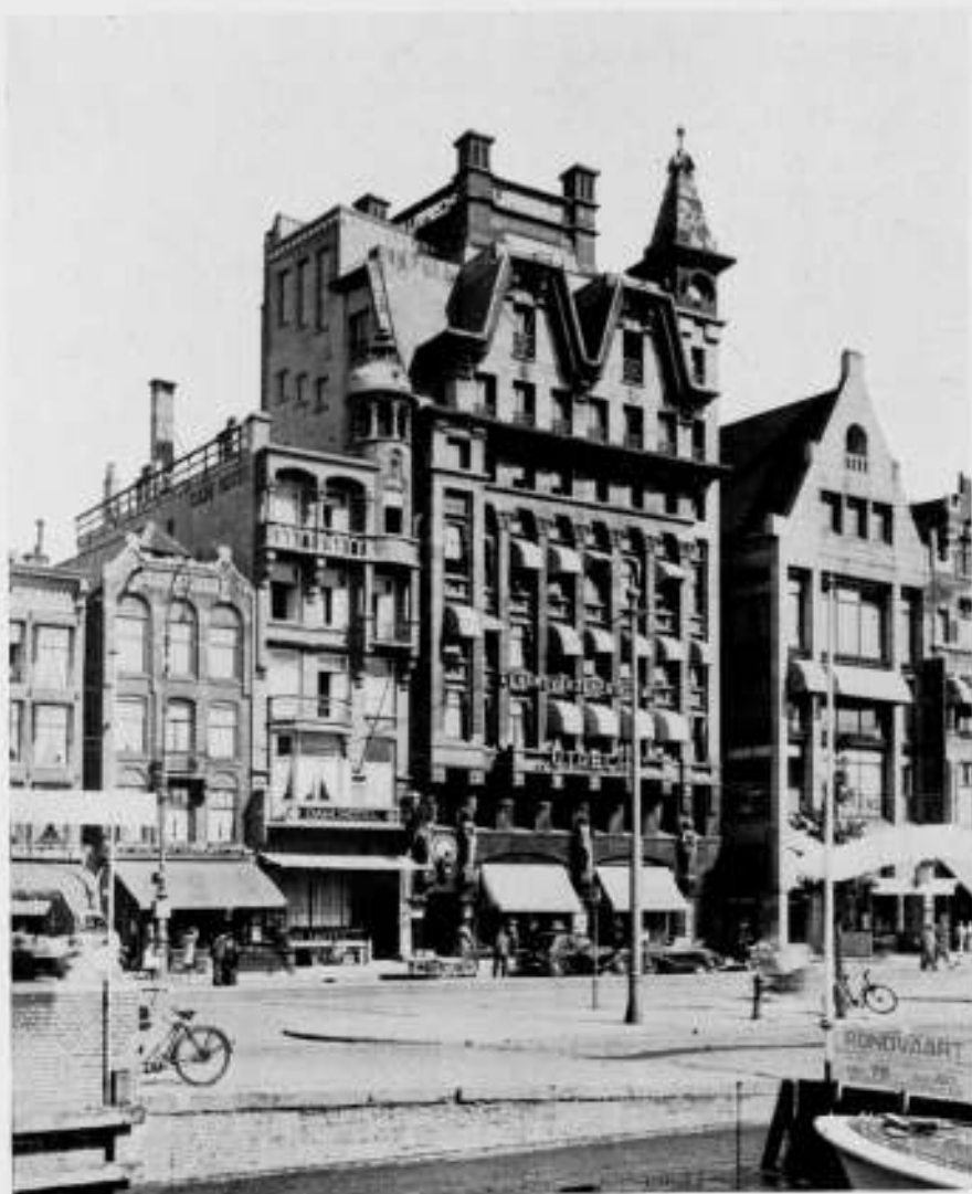
GEBOUW „DE UTRECHT“ AAN HET DAMRAK TE AMSTERDAM.
