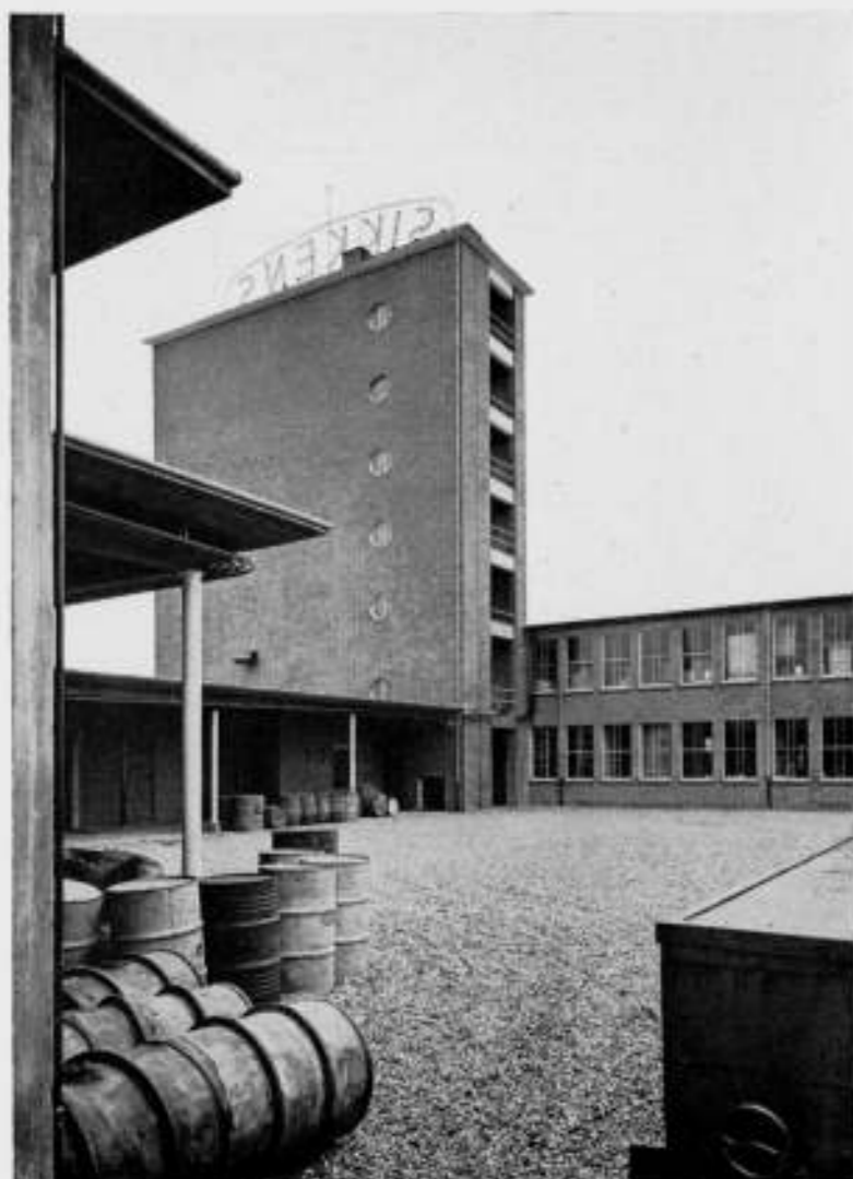
FABRIEKSCOMPLEX GEZIEN VAN AF HET N.W. GEZICHT OP LAK- VOORRAADTOREN MET OVERDEKTE TRANSPORTGANG.
