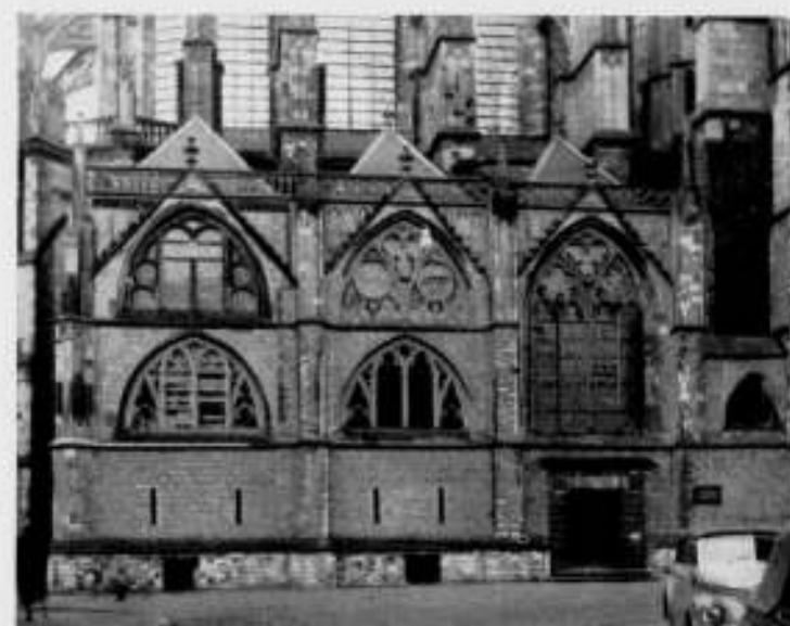
NOORDGEVEL VAN DE VOORMALIGE SACRISTIE NA DE RESTAURATIE
