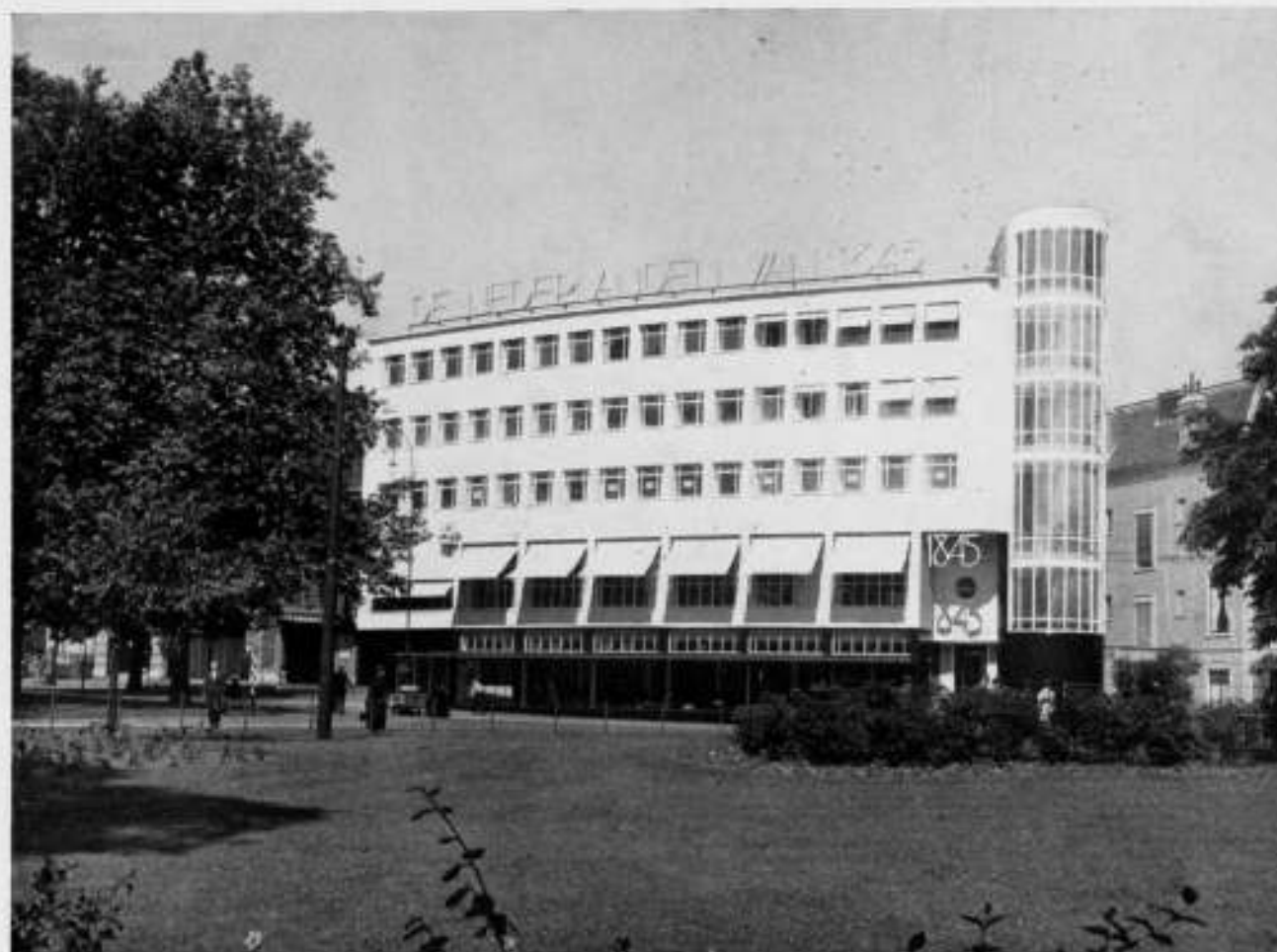
HET GEBOUW VAN „DE NEDERLANDEN VAN 1845“ TE ARNHEM.
