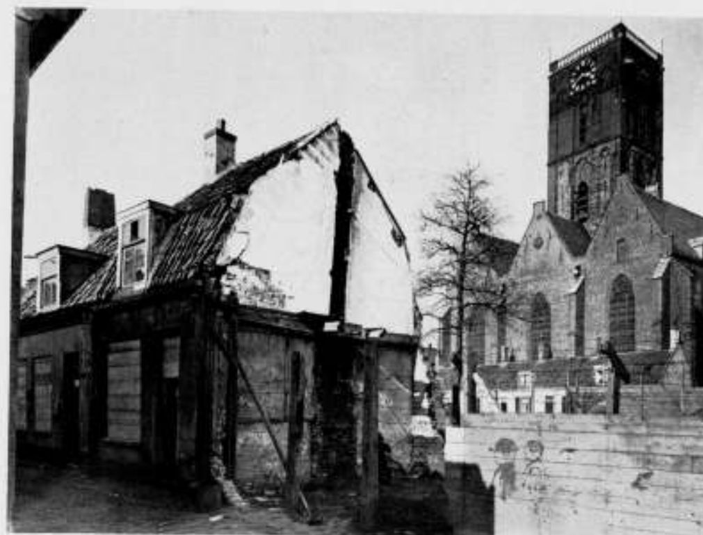
FIG. 3. DE JACOBITOREN TE UTRECHT TUSSEN DE HUIZEN IN AFBRAAK VAN WIJK C.
