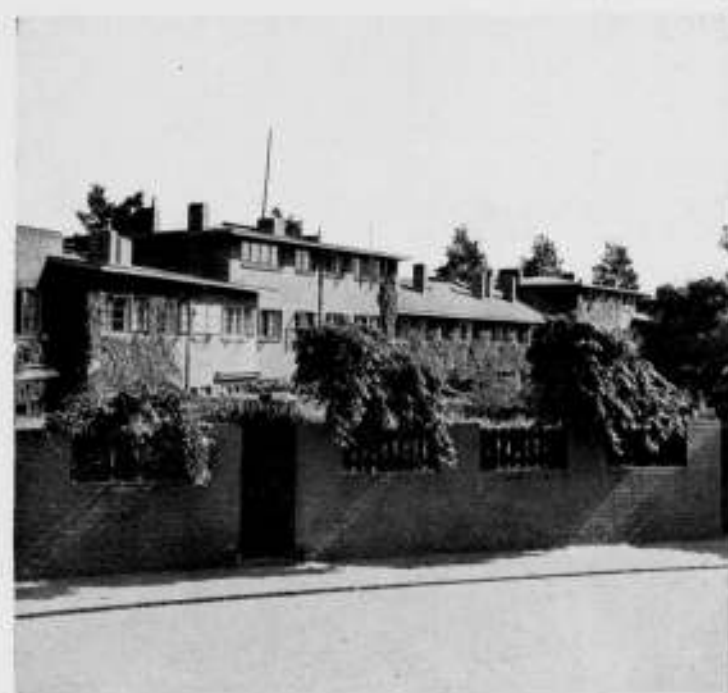
TUINWIJK-NOORD TE HAARLEM ACHTERGEVELS AAN DE KLEVERPARKSTRAAT
