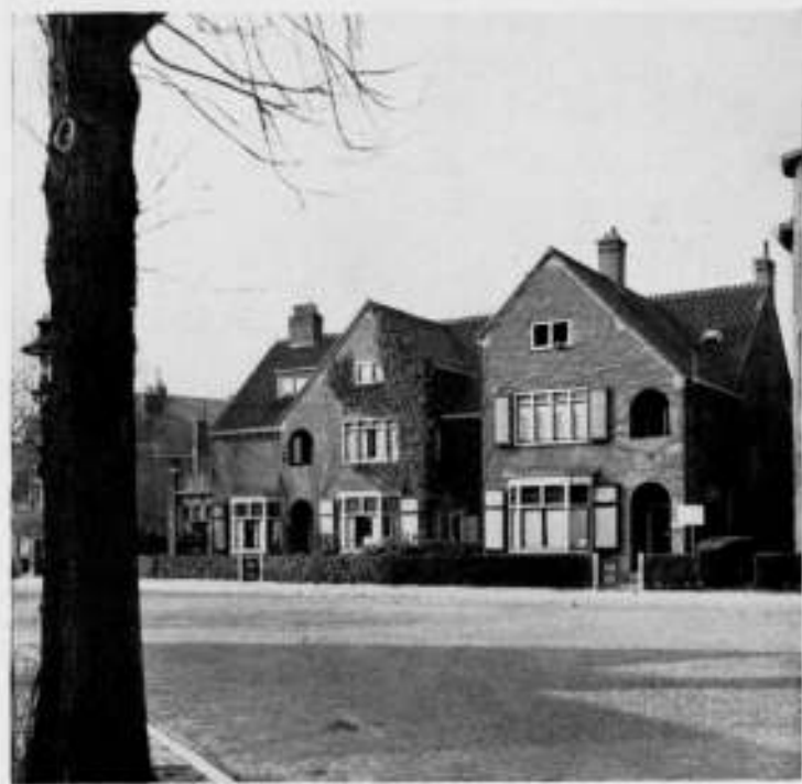
WOONHUIZEN AAN DE JULIANA V. STOLBERGSTR. TE HAARLEM
