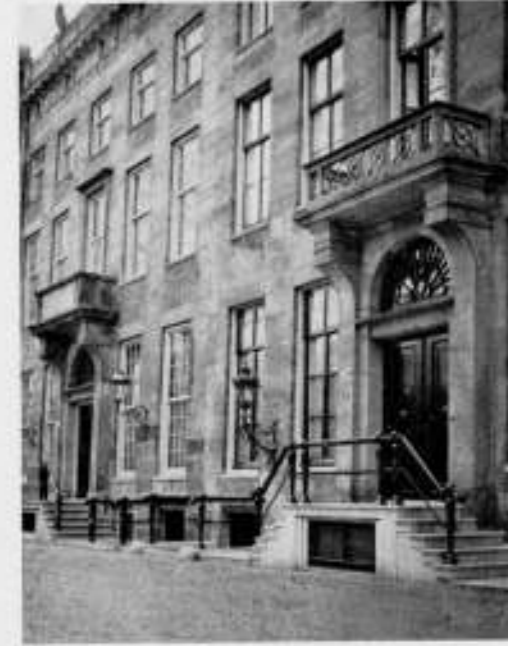
Beide huizen hebben ramen uit later tijd. Het rechtsche heeft tot ontreeds 1800 de natuurlijke ontwikkeling meegemaakt, het linksche heeft bij een recente restauratie een raamtype gebreng dat niet het originele van den bouw is.
