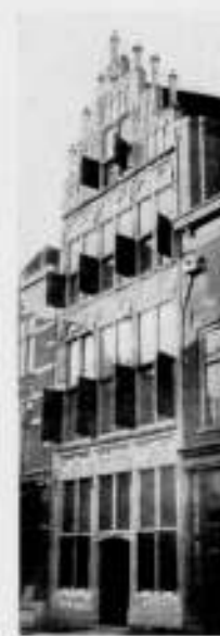
GOTHISCH HUIS TE KAMPEN NA RESTAURATIE
