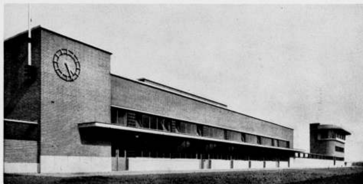
NIEUW STATIONSGEBOUW TE BRUGGE. ACHTERGEVEL. ARCHITECTEN JOSSE EN VAN KRIEKINGE.
