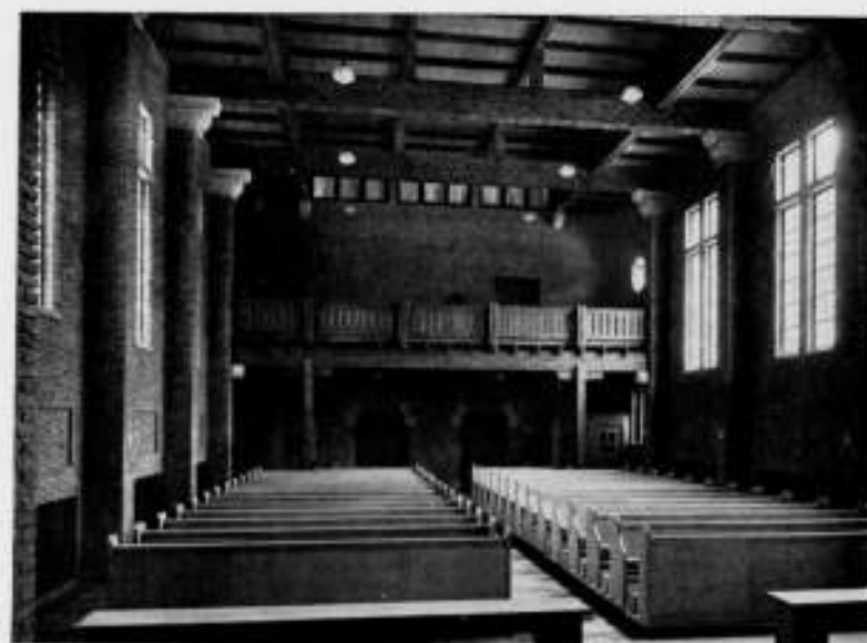
KAPEL GEZIEN NAAR DE GALERIJ ARCHITECTEN G. M. J. SIMONS, IR. H. THUNNISSSEN EN J. H. HENDRICKS
