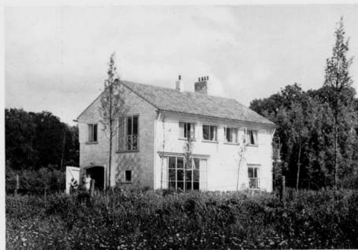
WOONHUIS TE WAALWIJK (N.-BR.). ARCHITECT G. H. HOLT.
