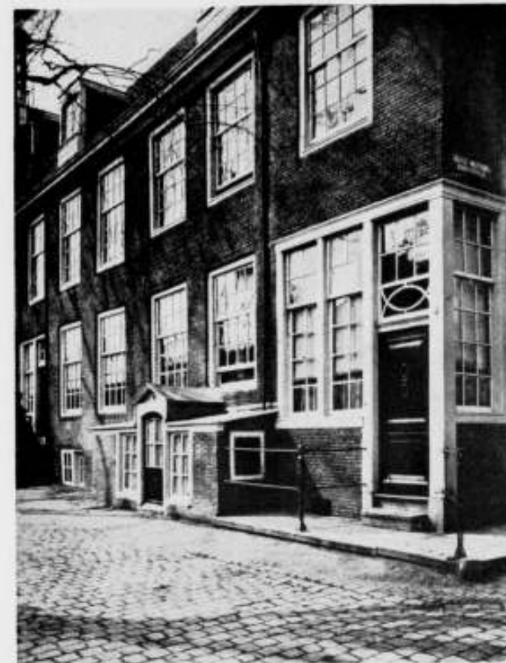
GEVEL TE AMSTERDAM
