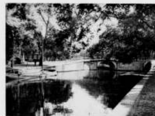
FIG. 2. BRUG VOOR DE HEERENGRACHT BIJ HET THORBECKEPLEIN
