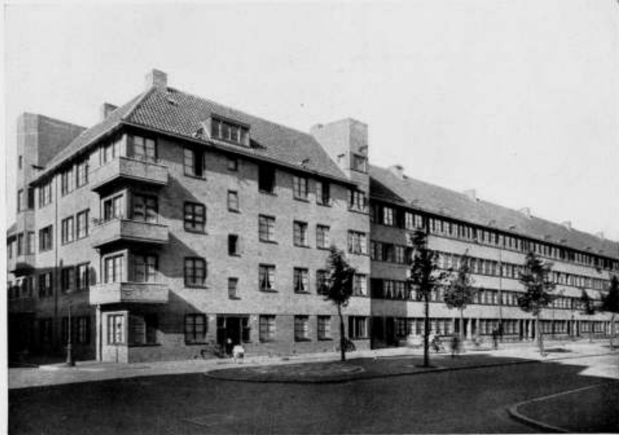
ARBEIDERSWONINGEN AAN DE SAFFIERSTRAAT TE AMSTERDAM. ARCHITECT J. C. VAN EPEN B.N.A.
