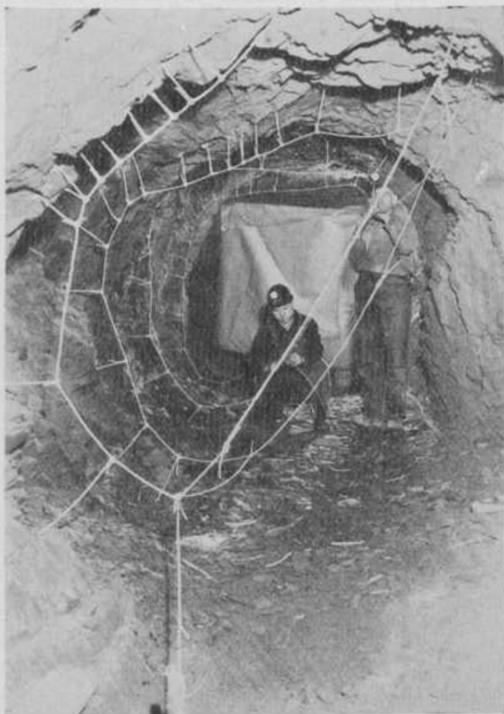
Schakeling der schietleidingen.
