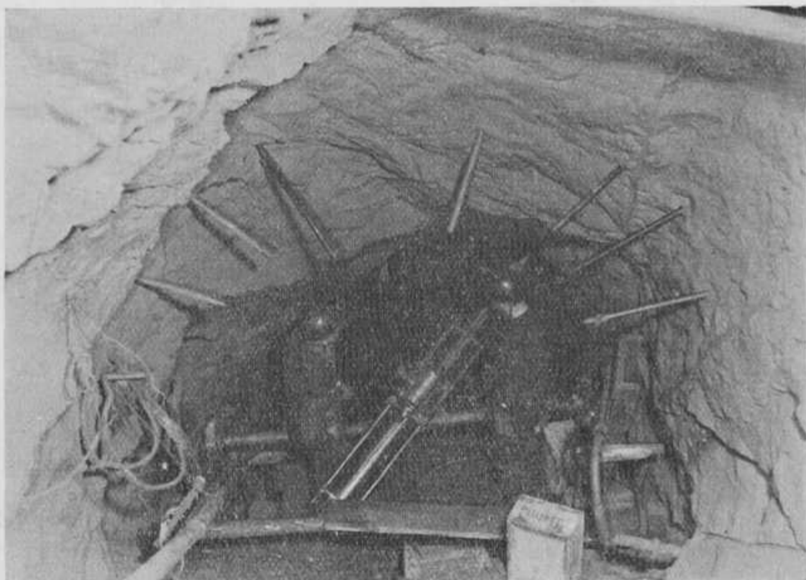
Het boren van schietgaten in de gangpaden
