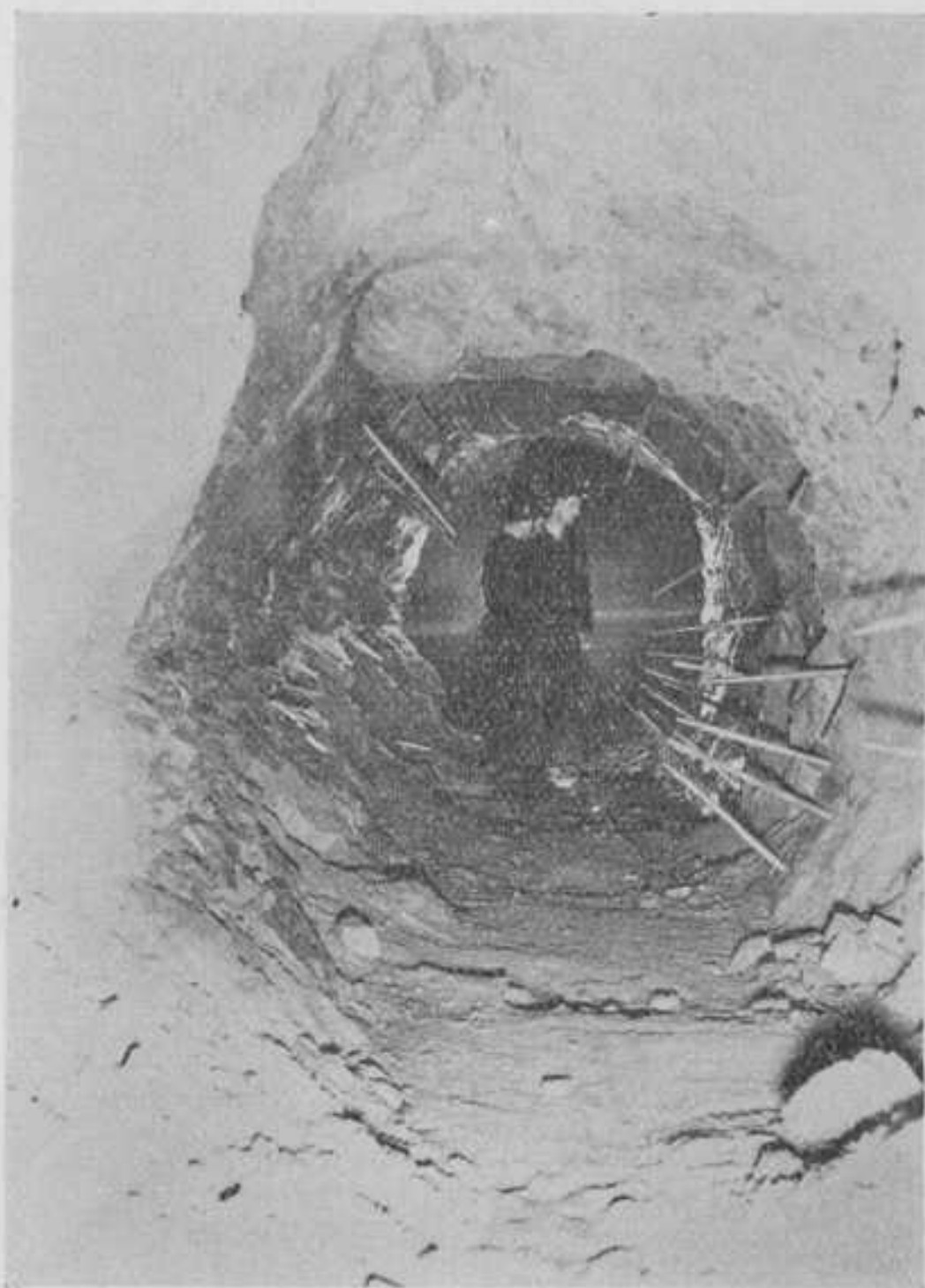
Doorkijk door gangpad. Let op de met hout dicht gemaakte boorgaten.
