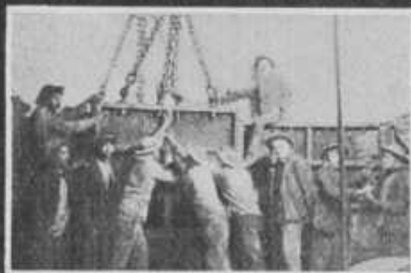
PLAATSING VAN CUVELAGE ELEMENTEN IN EEN SCHACHT
