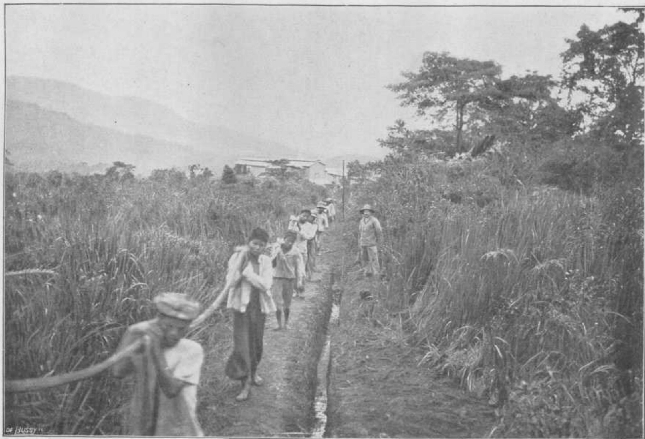
PLAAT 8. Het leggen van den ondergrondschen kabel tusschen generator en fabriek.
