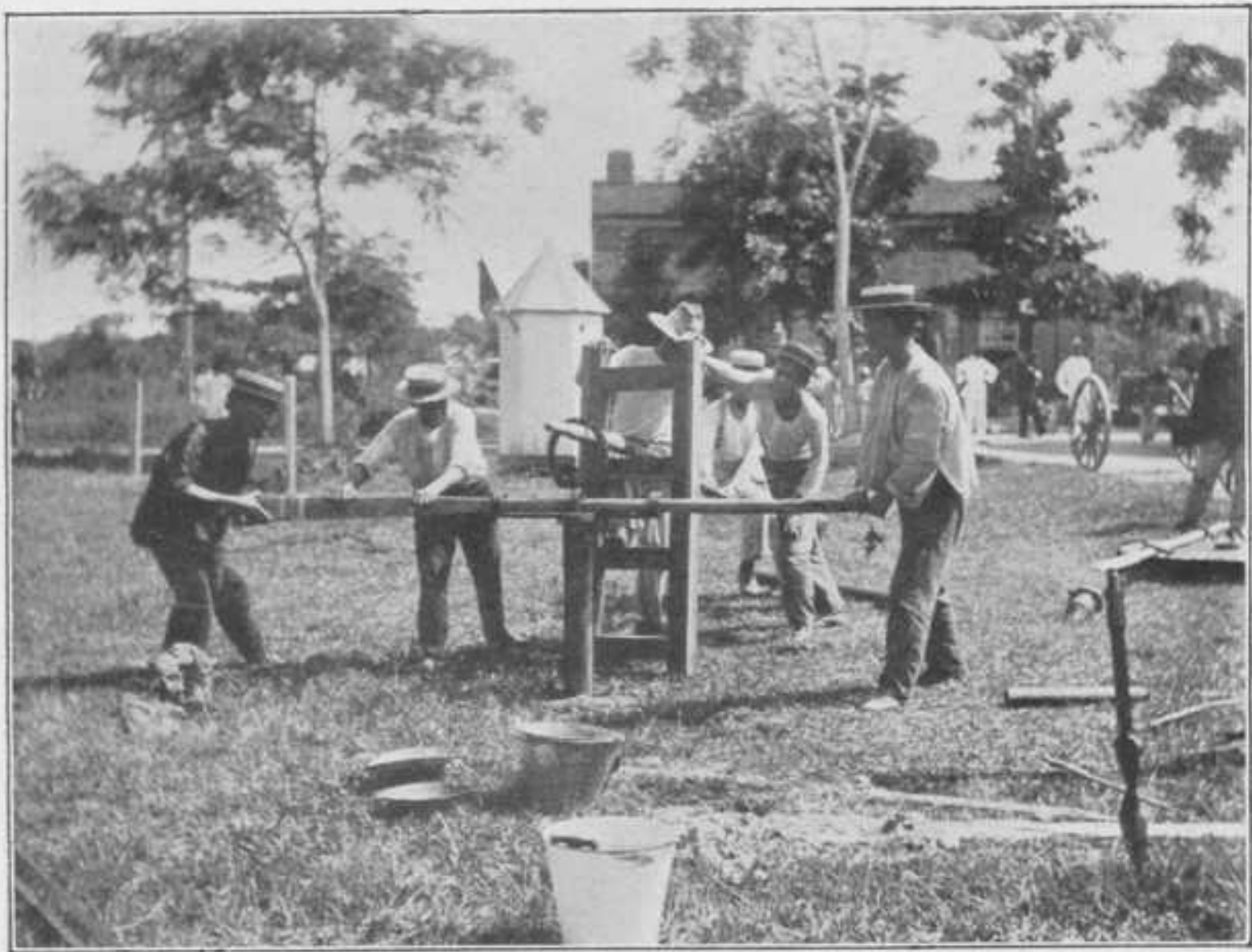
Het uithalen van de buizen.
