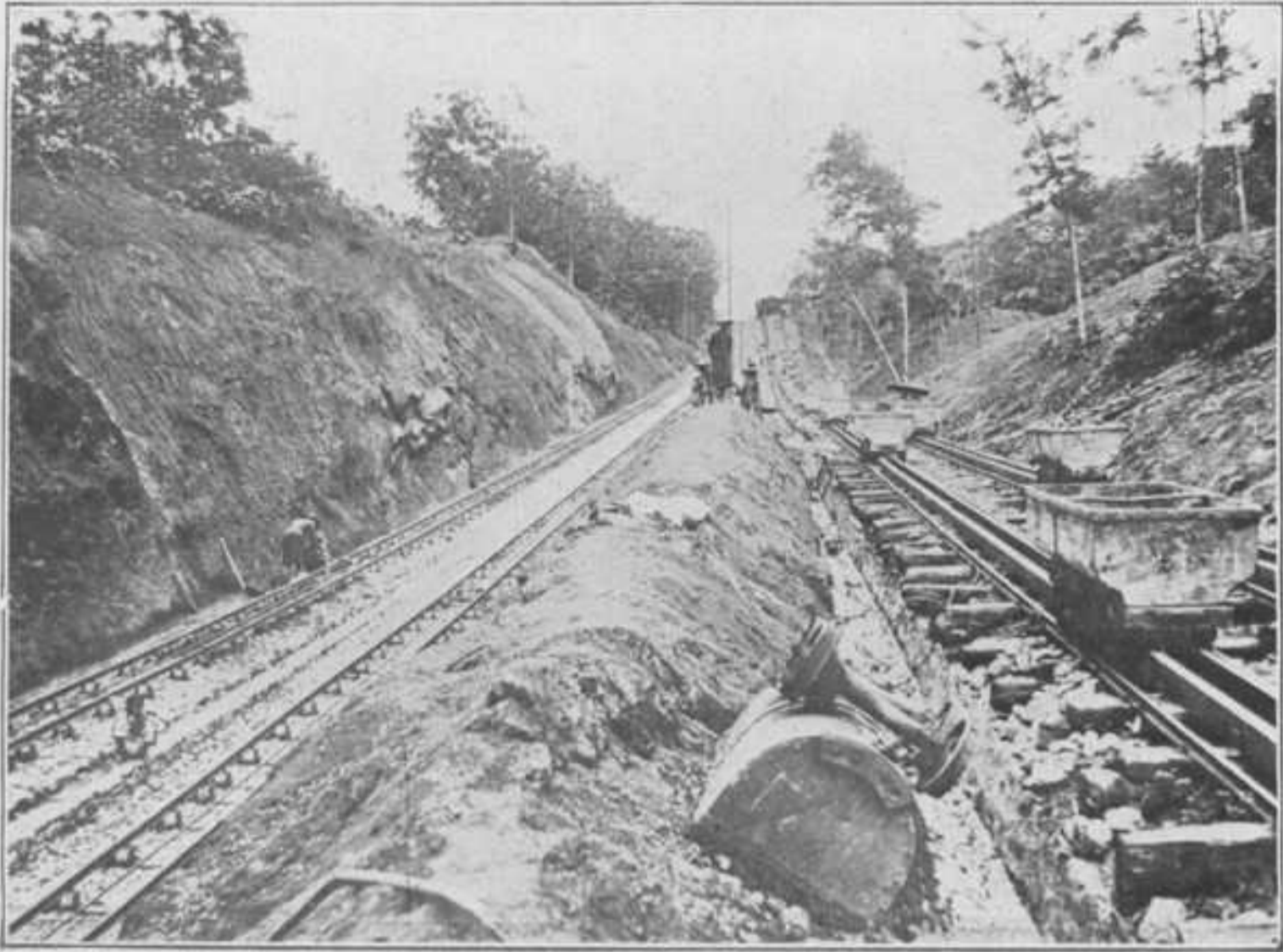
Fig. 5. De nieuwe kabelbaan in aanbouw.
