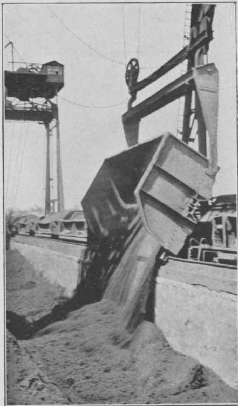
Ontladen eener ertswagen te Felton (noduleerinrichting).
