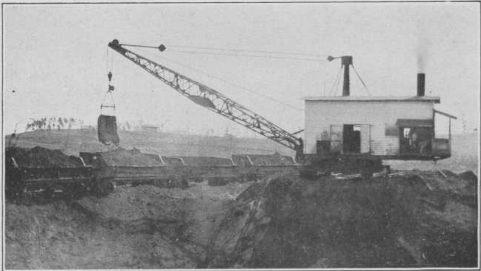
Het ledigen der graafbak in de ertswagens.
