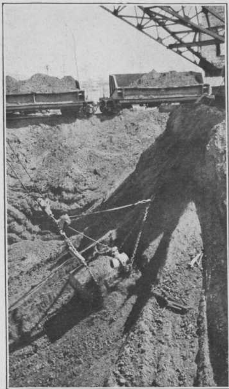
Graven met de „Dragline” (page bucket).
