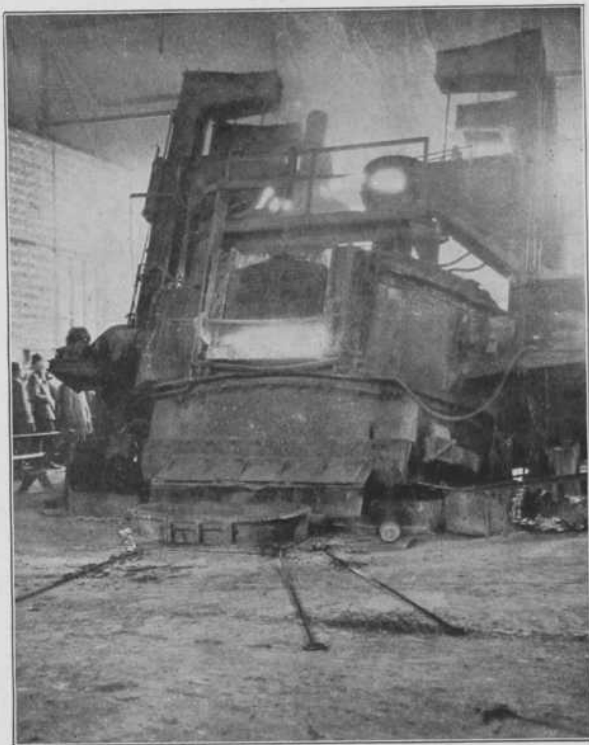
Fig. 23. Kipbare elektrische staaloven.
