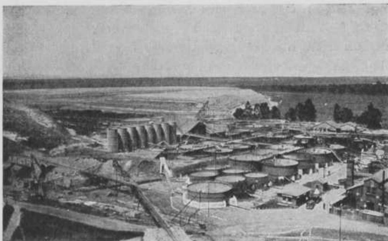
Overzichtsfoto van de slime plant van Springs Mines. Van links naar rechts: Pachuca's, Butters' Plant. Daarachter 7 70' × 12' collecting tanks. Op den voorgrond 6 mine water tanks, 4 clarifiers, oude sand treatment tanks. Rechts op den voorgrond smelthuis. Links op den achtergrond de slimes dam; de horizontale gelaagdheid is duidelijk te zien.
