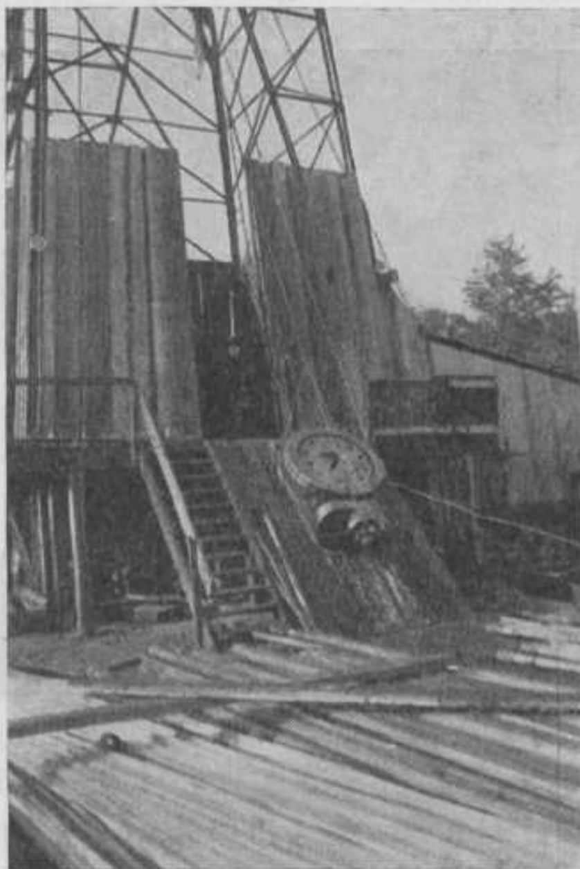
Demontatie der Rotary-tafel.
