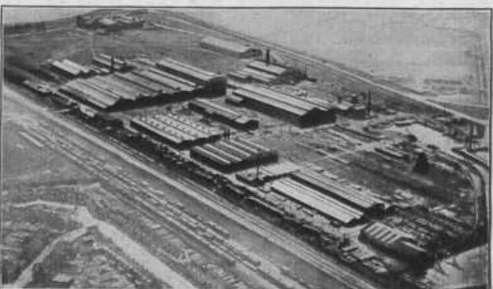
WAGON- EN BRUGGENFABRIEK BIJ UTRECHT (LUCHTFOTO K.L.M.)
