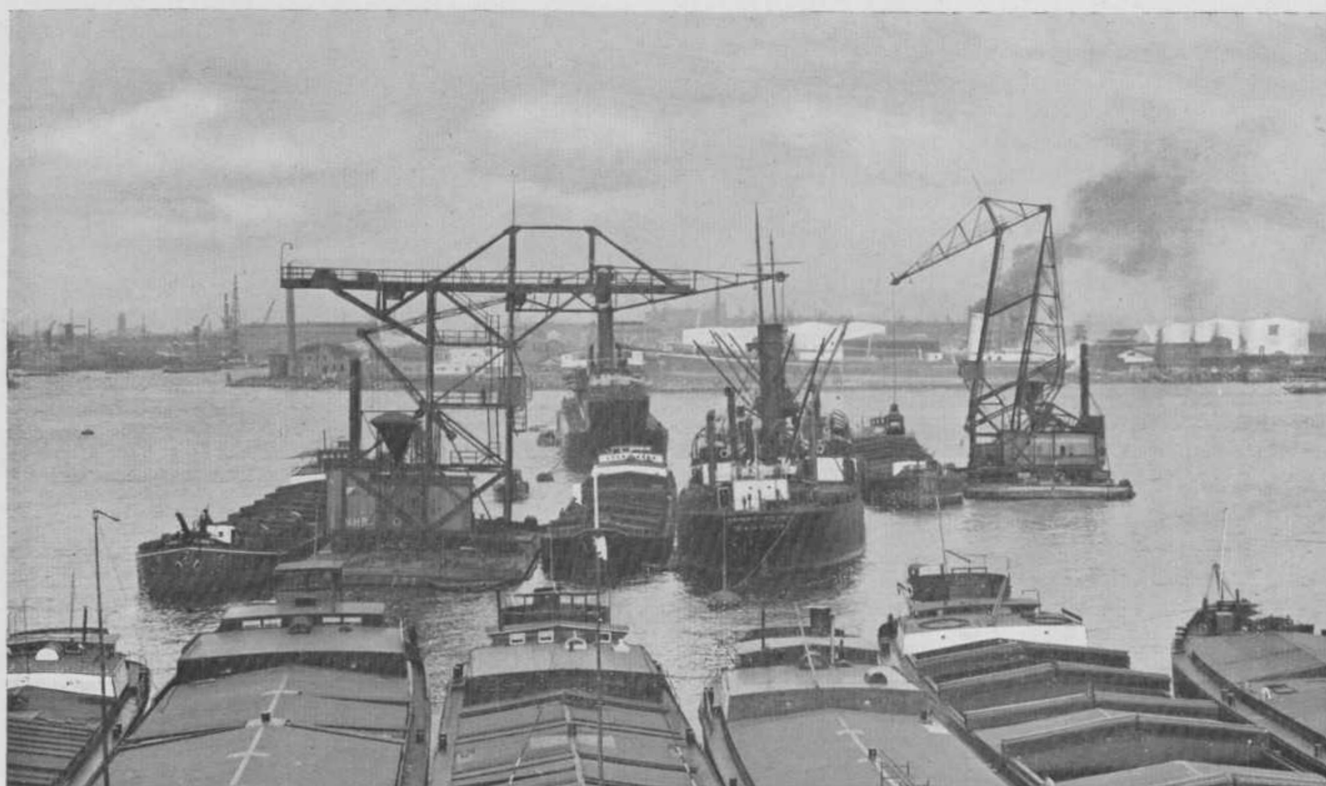
HET LOSSEN VAN EEN ZEESCHIP IN DE ROTTERDAMSCHER HAVEN MET 10 TONS DRIJVENDE KRANEN VAN HET LAATSTE TYPE
