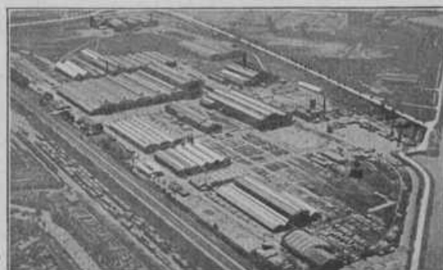
WAGON- EN BRUGGENFABRIEK BIJ UTRECHT (LUCHTFOTO K.L.M.)
