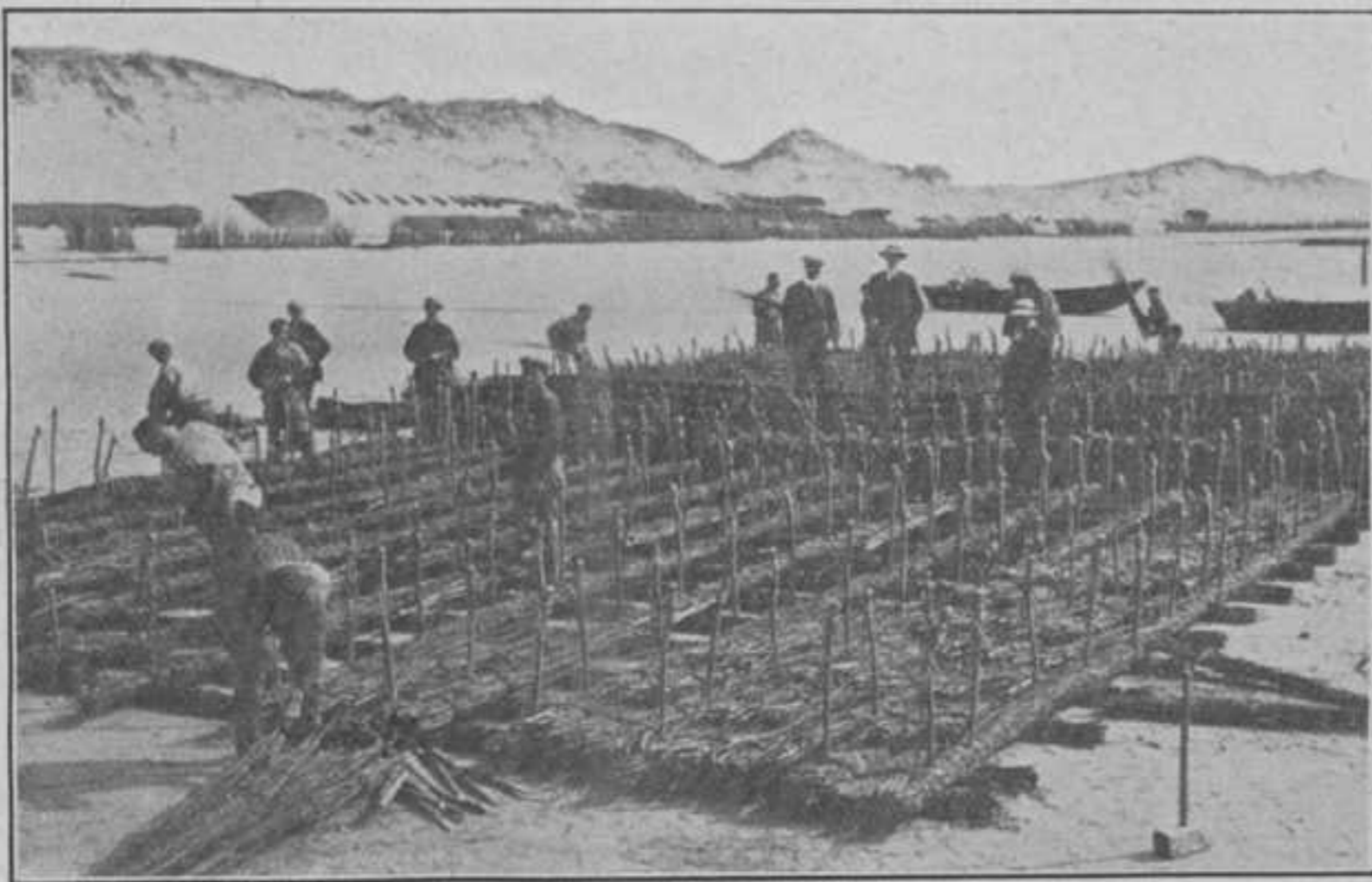
Voorgrond: Een opzinkstuk; ziet het roosterwerk der wiepen en een gedeelte der eerste rijslaag. Achtergrond: Een onderzinkstuk (roosterwerk met drie rijslagen + rietlaag) 14 × 14. Beiden in aanbouw.
