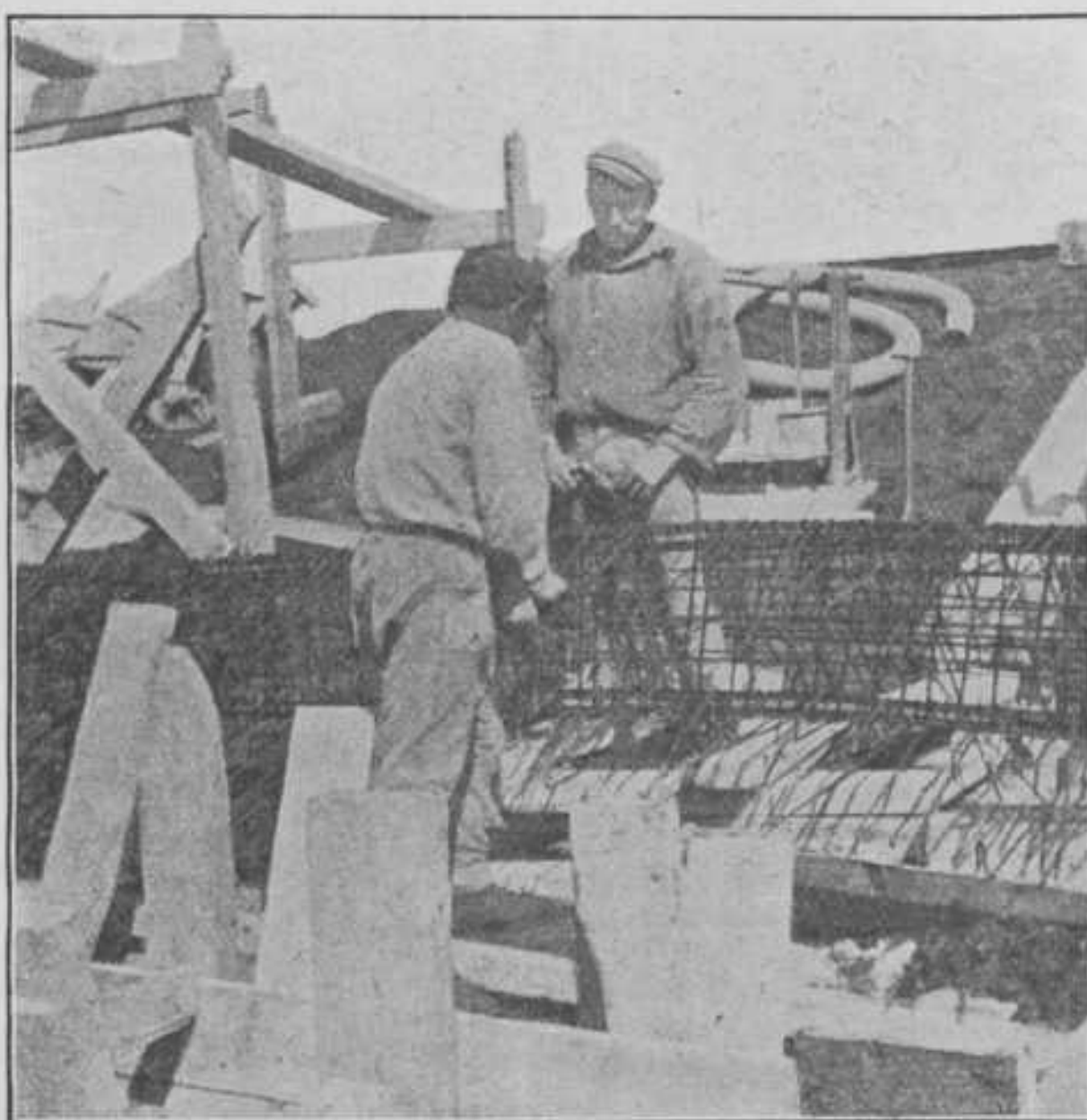
Bovenwapening van de westelijke buis aan de Vlaardinger vaart.
