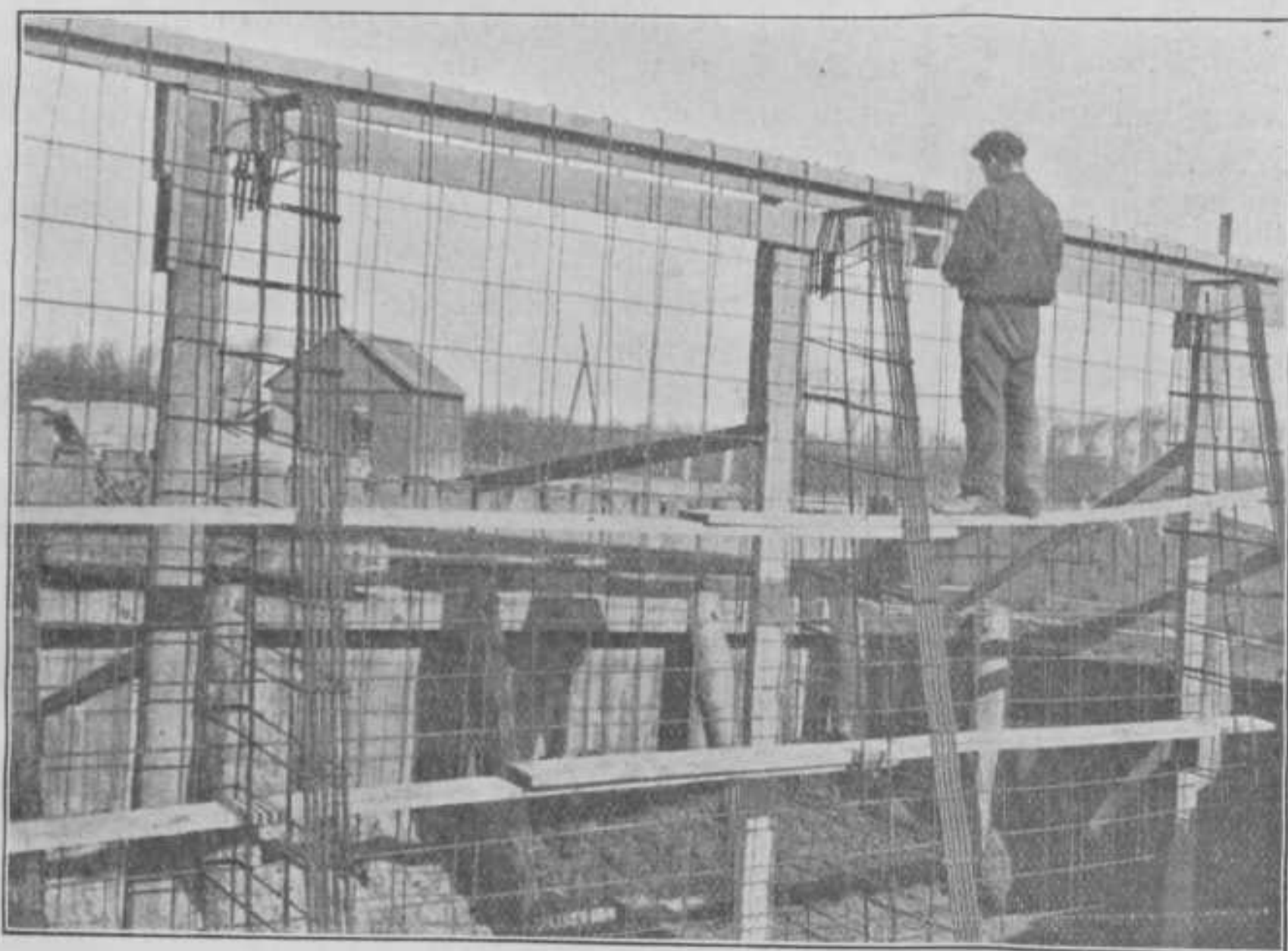
Het vlechten van het wandijzer van de N. W. vleugel van de brug over de Zuidgaag.
