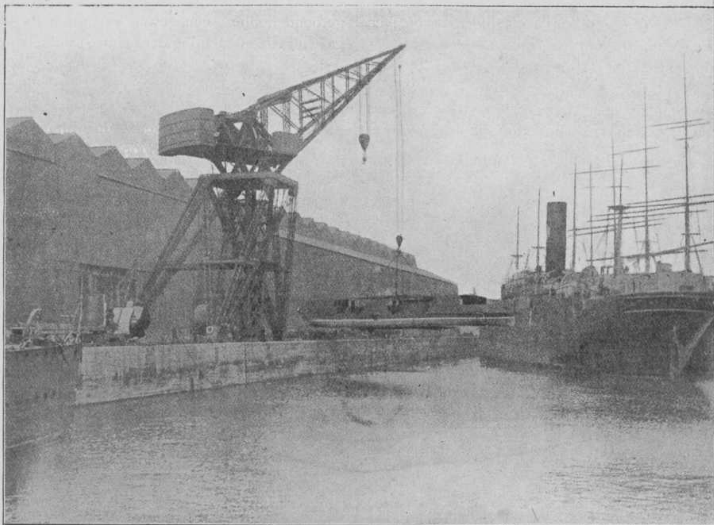
Fig. 3. 150-tons vaststaande kraan met draaiarm, een raderboot te water latende.
