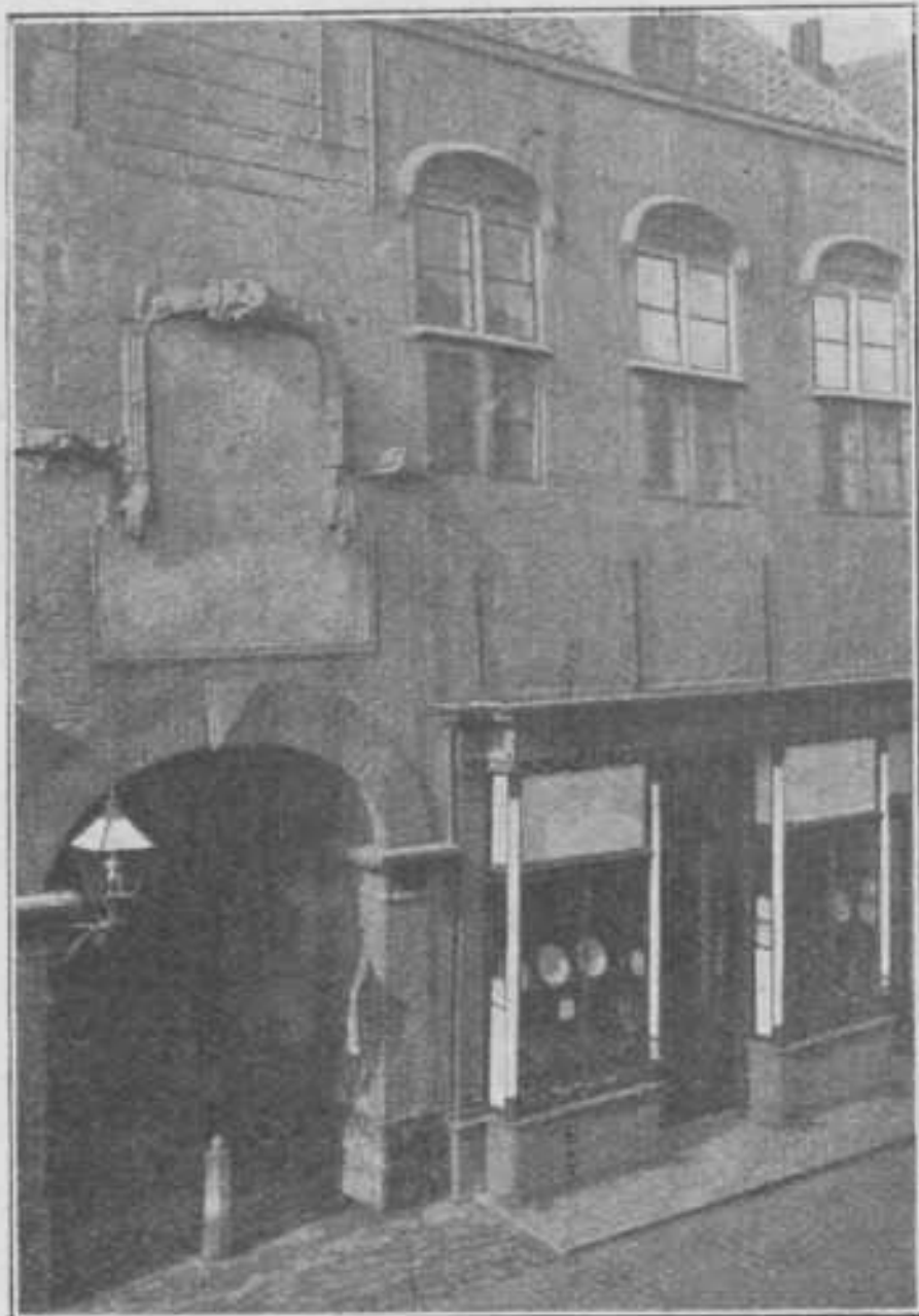
GISTPOORT TE MIDDELBURG (voor de restauratie).
