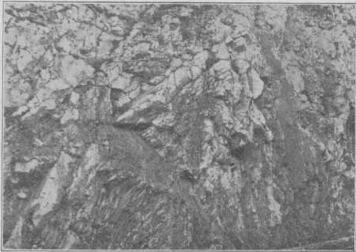
Fig. 3. Antiklinaal in het profiel van het Dinantien in de spoorweginsnijding bij de Carrière „Basse Normandie” bij Elinghen.
