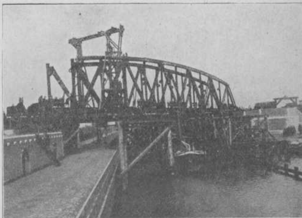
Fig. 3. Montage van de Brug over de Zuid-Willemsvaart.
