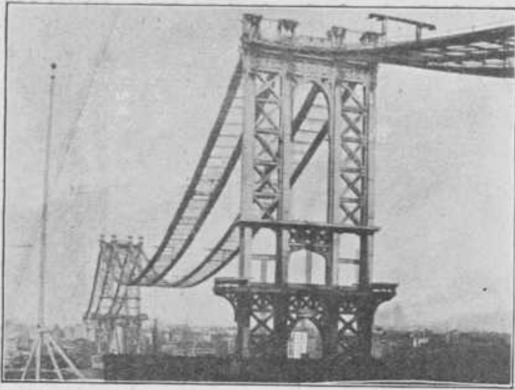
Manhattan-brug; de hulpkabels met werkvloer voor het „Luftspinnverfahren“.
