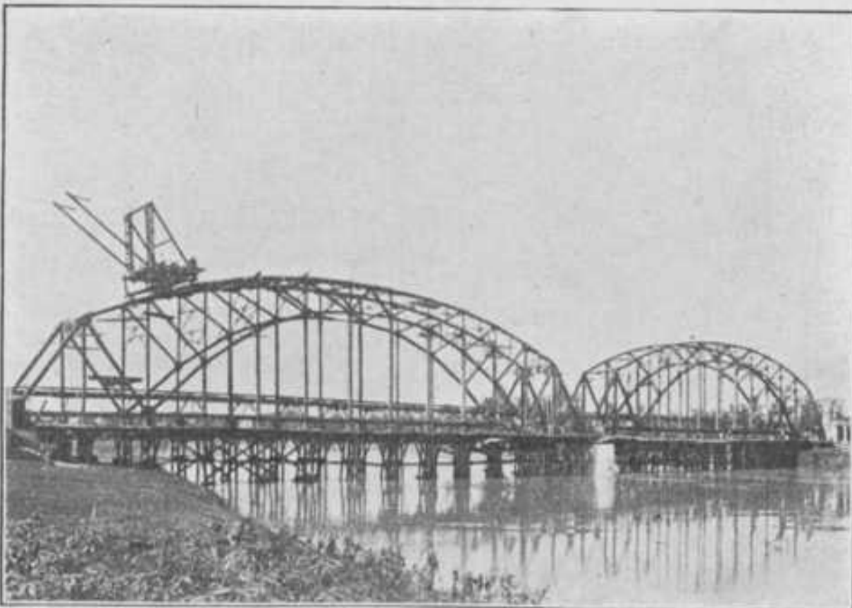
Brug van 60 M. overspanning over de Tji-Losari.
