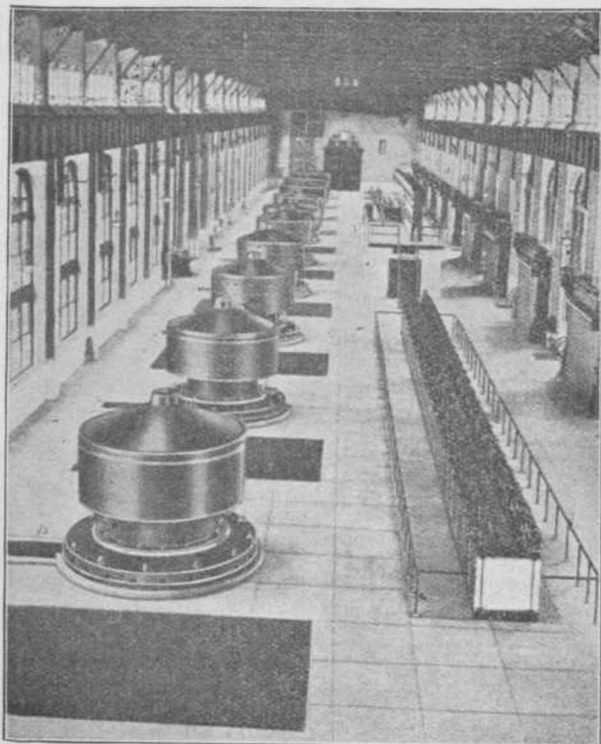
Vulopeningen van de turfgasgeneratoren.
