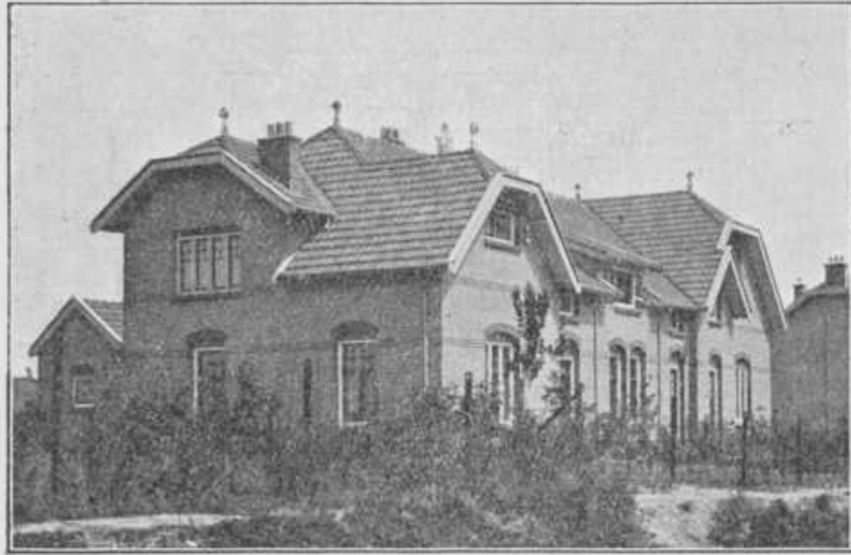
Blok van 4 arbeiderswoningen.
