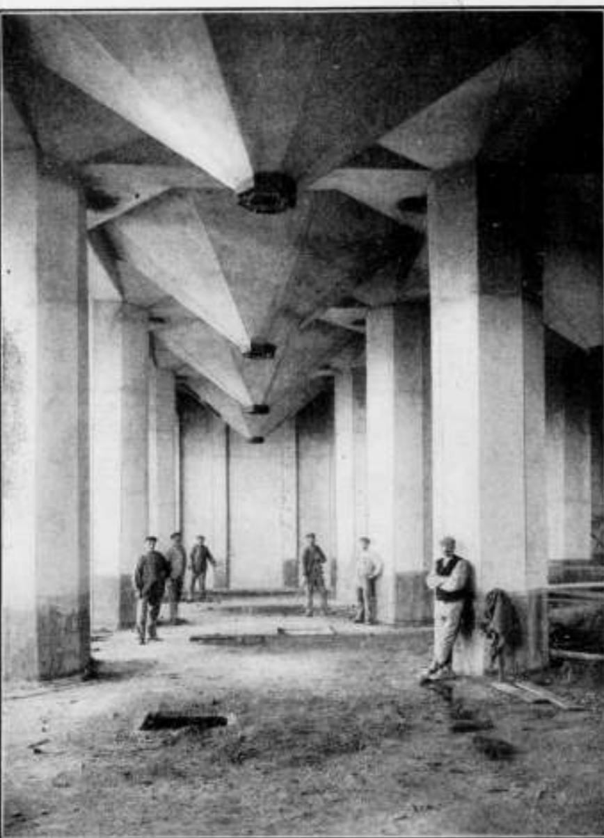
Graansilo te Rotterdam. Maashaven Z.Z. Zullen op den beganeen grond met onderaanzicht der silo-trichters van de 300 tons-silo's een te lere zul in berekend op een last van 600.000 K.G.
