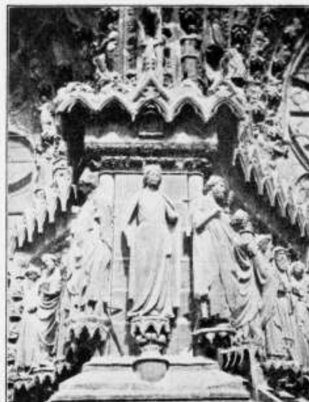
Linkervleugel van het hoofdportaal der kathedraal te Reims.
