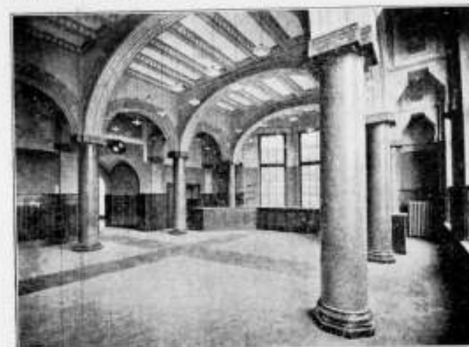
Restauratiezaal op de hoofdverdieping aan den boek van Beursplein en Papenbruggsteeg.
