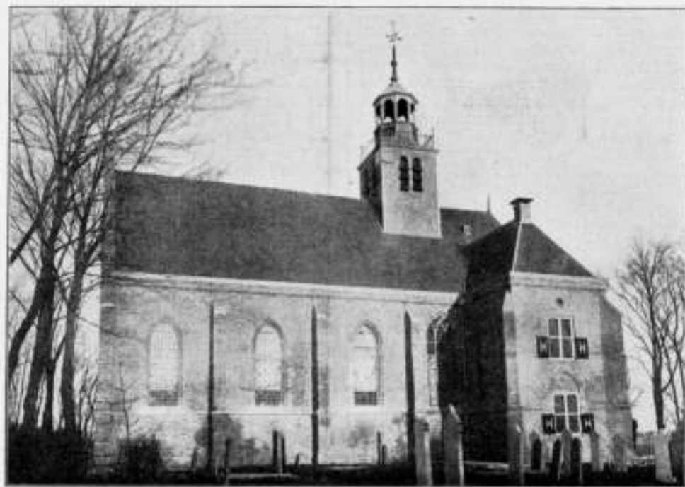
Uitwendige van de herstelde Kerk te Egmond aan den Hoef.
