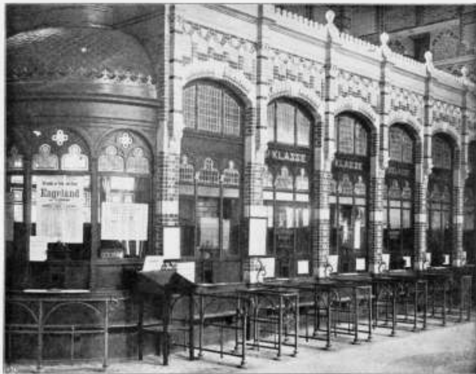
LOKETTEN IN DE VESTIBULE.
