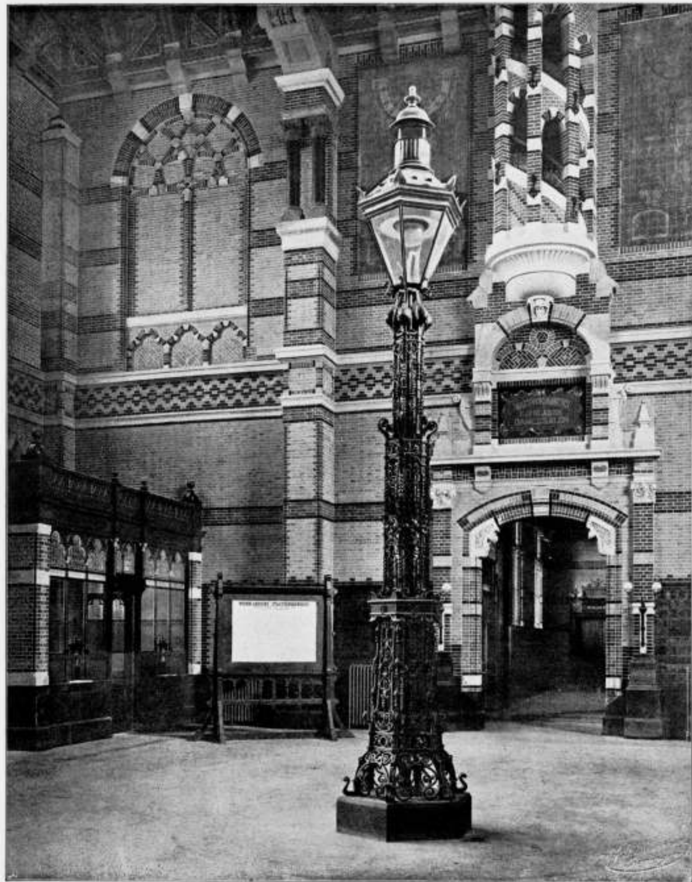
STATION VAN DEN STAATSSPOORWEG TE GRONINGEN.
