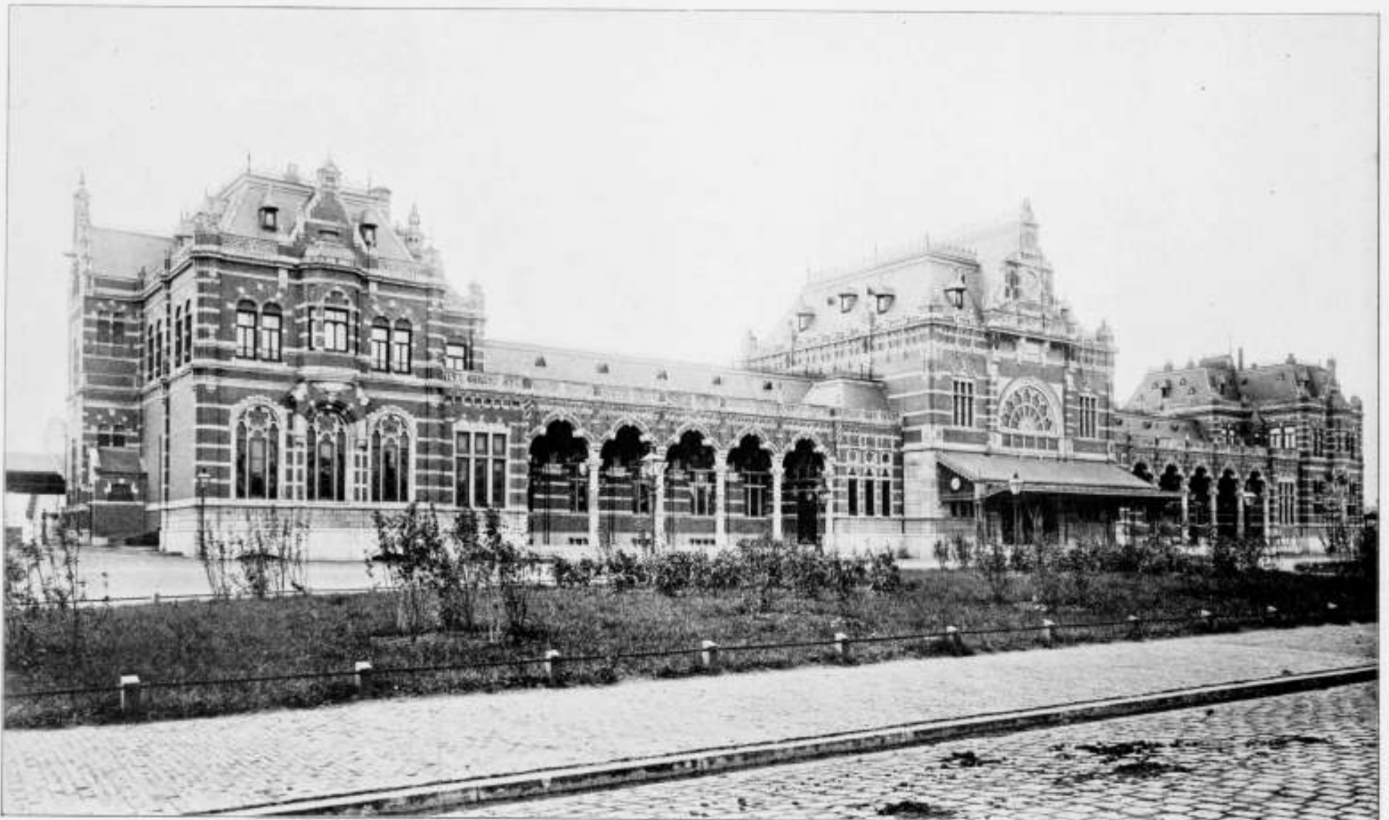
STATION VAN DEN STAATSSPOORWEG TE GRONINGEN.
