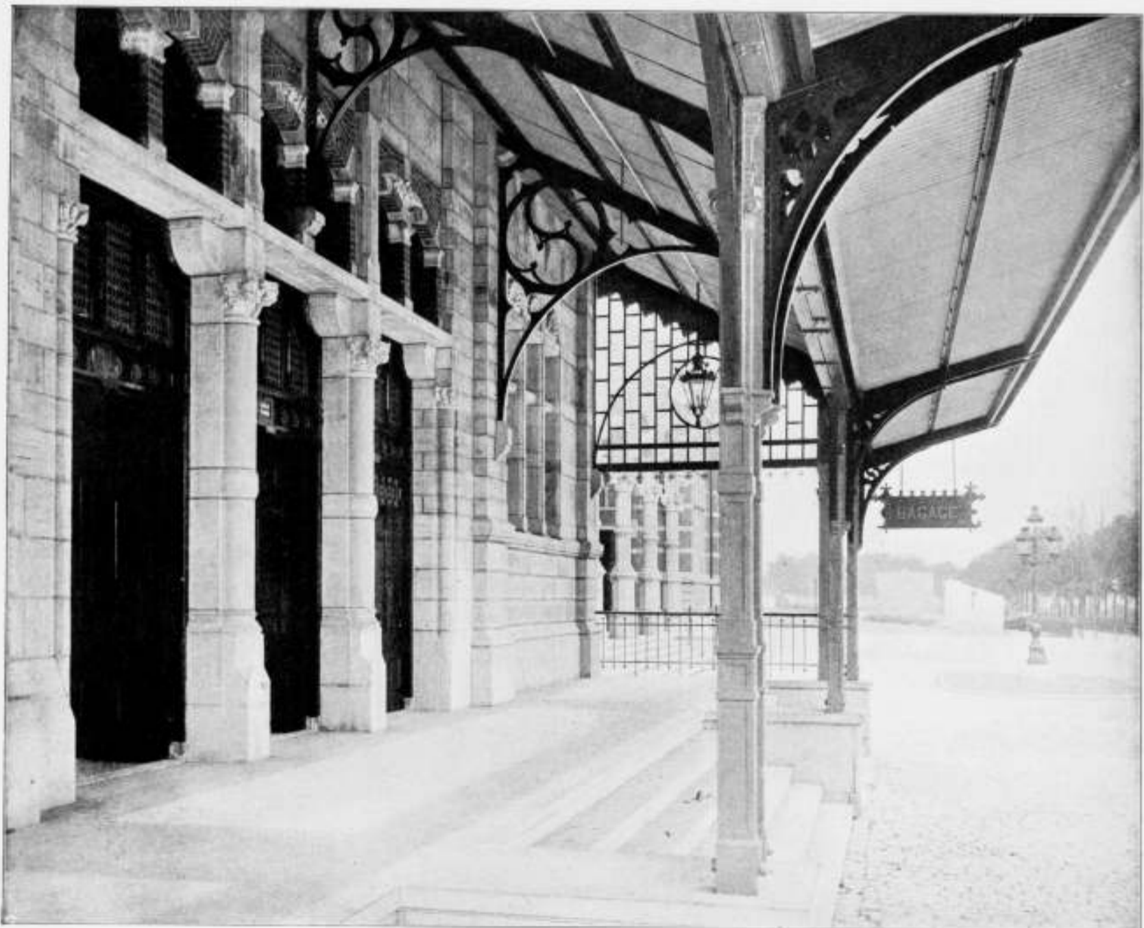
STATION VAN DEN STAATSSPOORWEG TE GRONINGEN.
