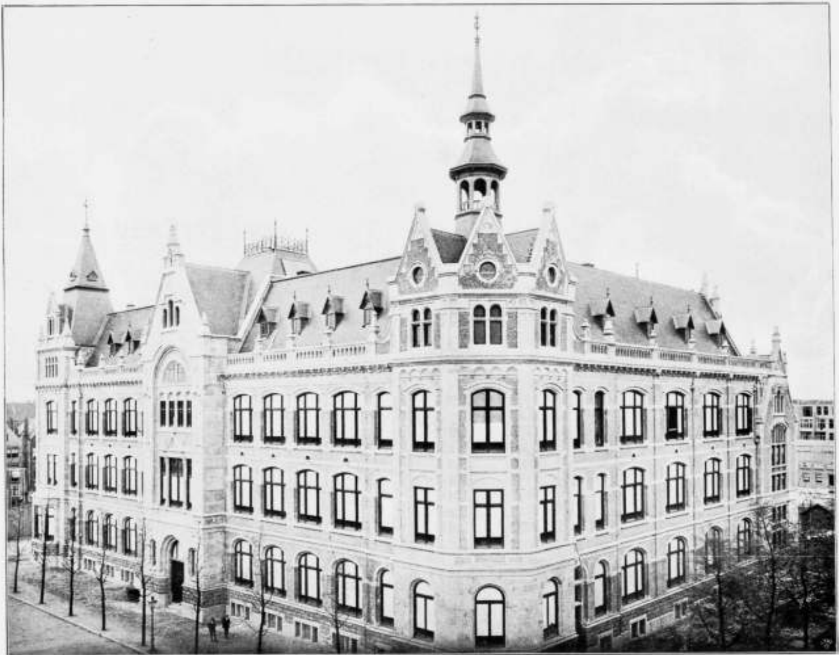
DIRECTIEGEBOUW VAN DE RIJKSPPOSTSPAARBANK TE AMSTERDAM. Architect D. E. C. KUTTIL. Rijksbouwmeester.
