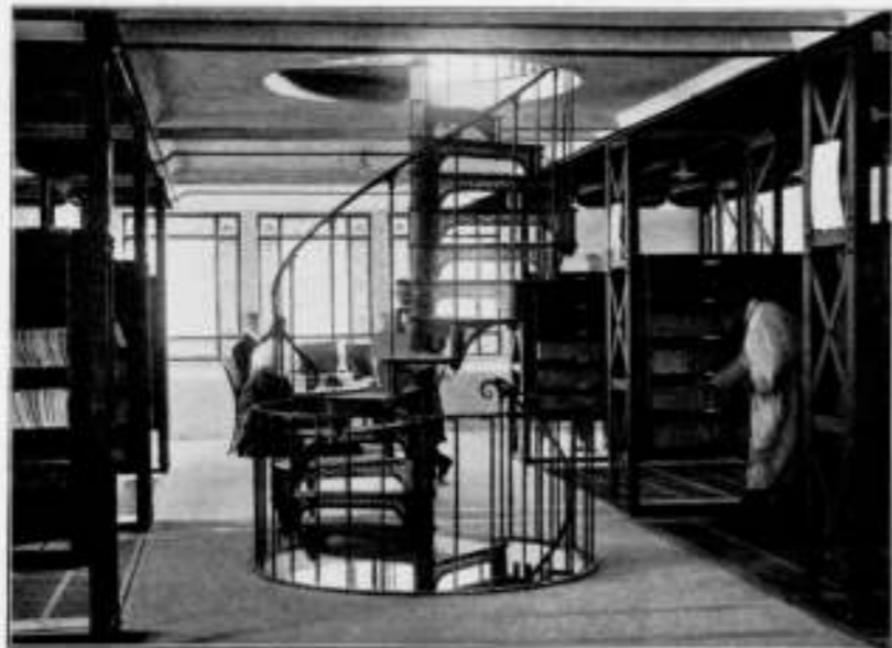
DIRECTIEGEBOUW VAN DE RIJKSPONSPAARBANK. Lokaal tot berging der rekening-courant, eerste verdieping.
