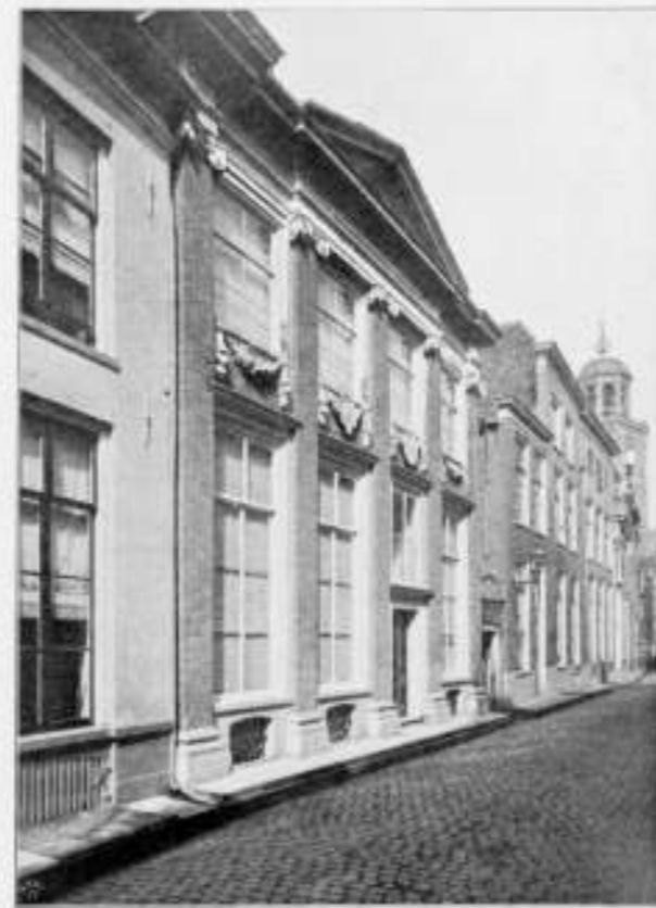
Fig. 43. GEVEL AAN DE POLSTRAAT. Naar een opening van J. C. Remick.
