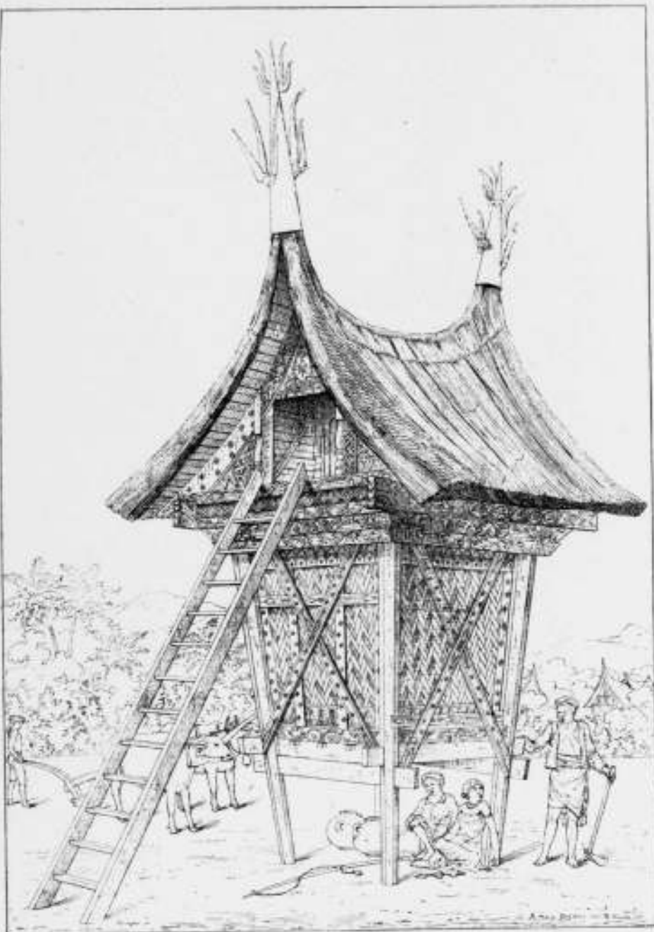
RUSTSCHUUR, PADANGSCHE BOVENLANDEN (SUMATRA) Grenier pour le riz. Pays supérieurs de Padang (Sumatra)
