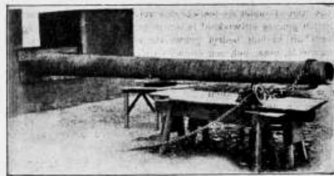
Fig. 5. Bevestigde mast vóór de beproeving.
