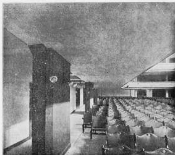
Balkon in gewapend Beton 1h, Geb. v. Kunst en Wetensch. te 's Gravenhage.
