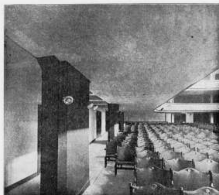
Baloon in gewapend Beton (h. Gels v. Kansten en Wetensch. te 's-Gravenhage).
