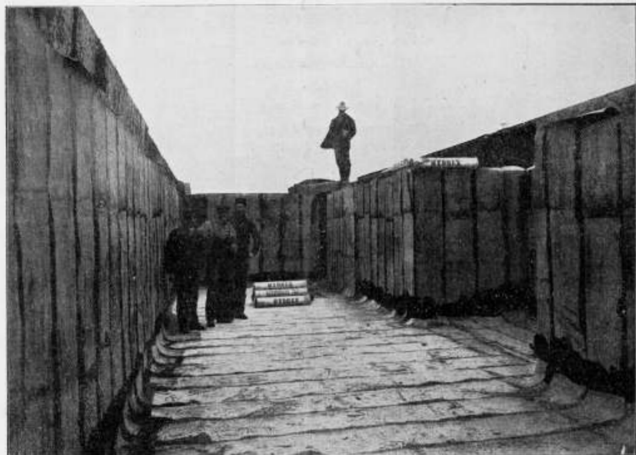
Betonwaterreservoir der Pennsylvania Spoorweg Mij. afgedekt met HYDREX VILT.
