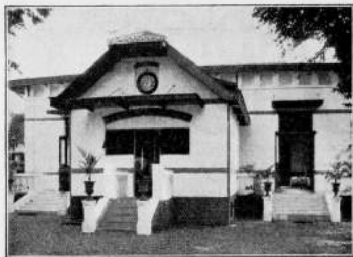
Hotel der Nederlanden te Batavia. Achtergevel der eetzaal.
