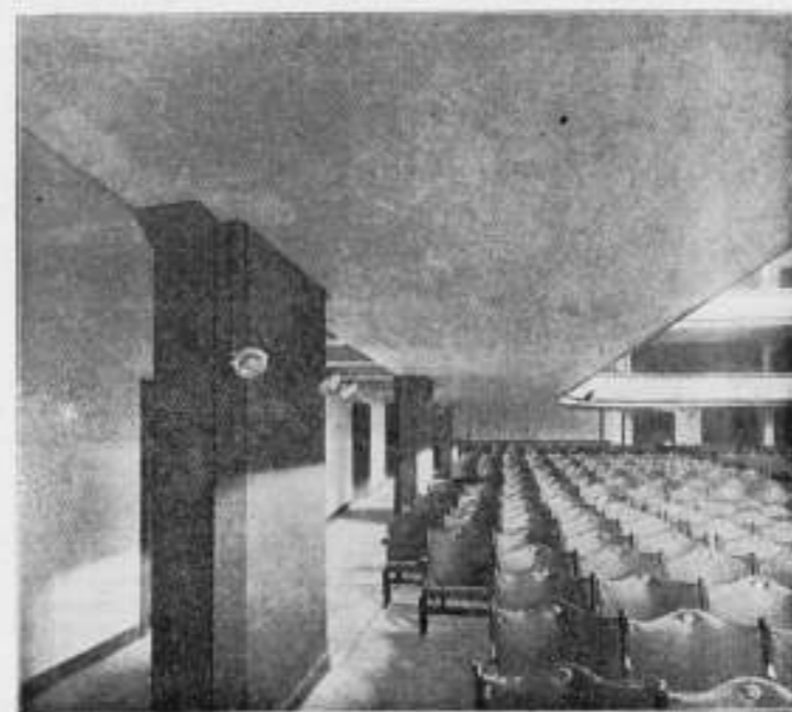
Dalton in gewapend Beton bij. Geb. v. Kunsten en Wetensch. te 's-Gravenhage.
