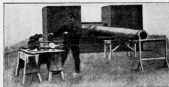
Fig. 6. Beproeving van den mast.
