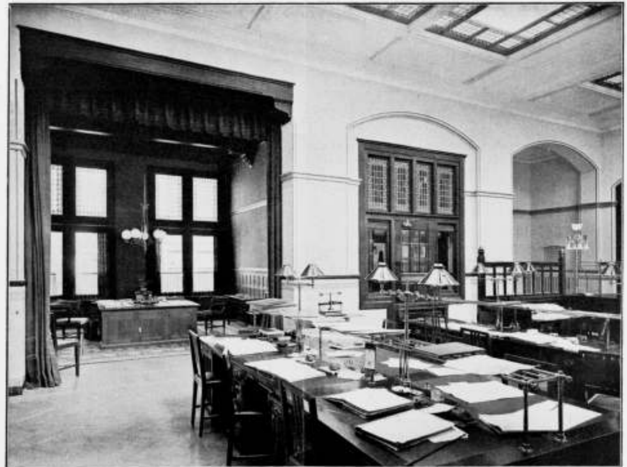
KANTOORLOKALEN IN HET BANKGEBOUW TE DORDRECHT.
