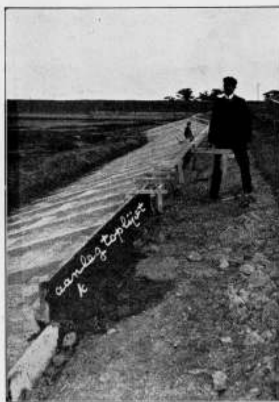
Fig. 16. Aanleg van de toplijst van het balkenstelsel.
