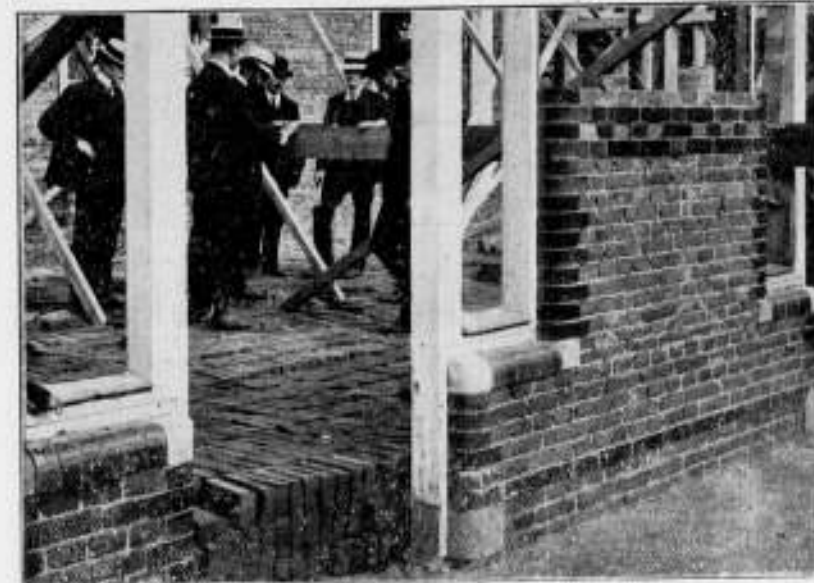
Beproeving vloeren van Herson Ziekenhuis Gouda.
