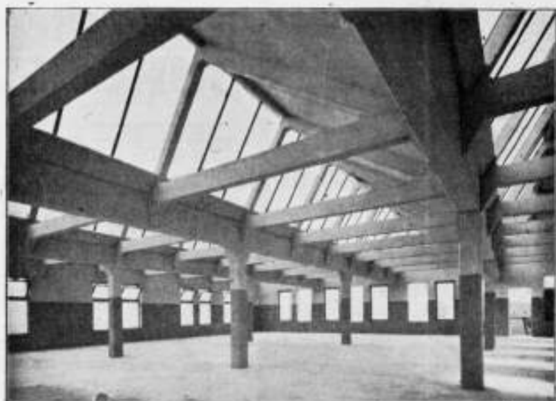
Gezicht op vloeren en kappen van GEBR. PALTHE te Almelo, uitgevoerd in gewapend beton.
