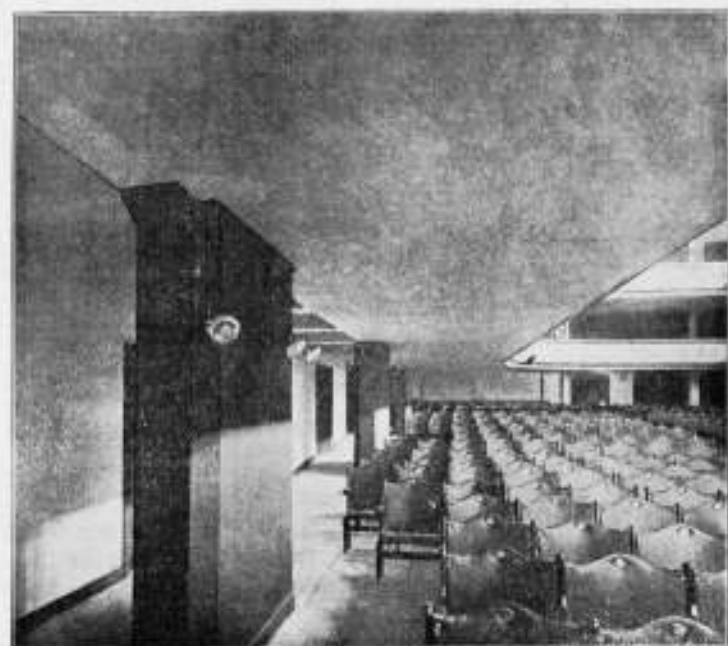
Balein in gewapend Beton (k. Gels. v. Kunst en Wetensch. te 's Gravenhage).
