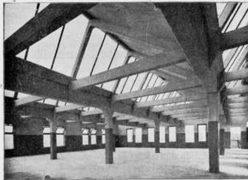
Gezicht op vloeren en kappen van GEBR. PALTHE te Almelo, uitgevoerd in gewapend beton.
