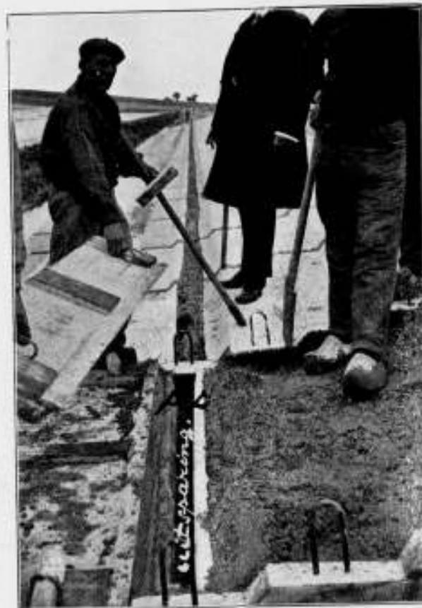
Fig. 12. Uitsparing voor lateren aanleg van een horizontale lijst van het balkenstelsel.
