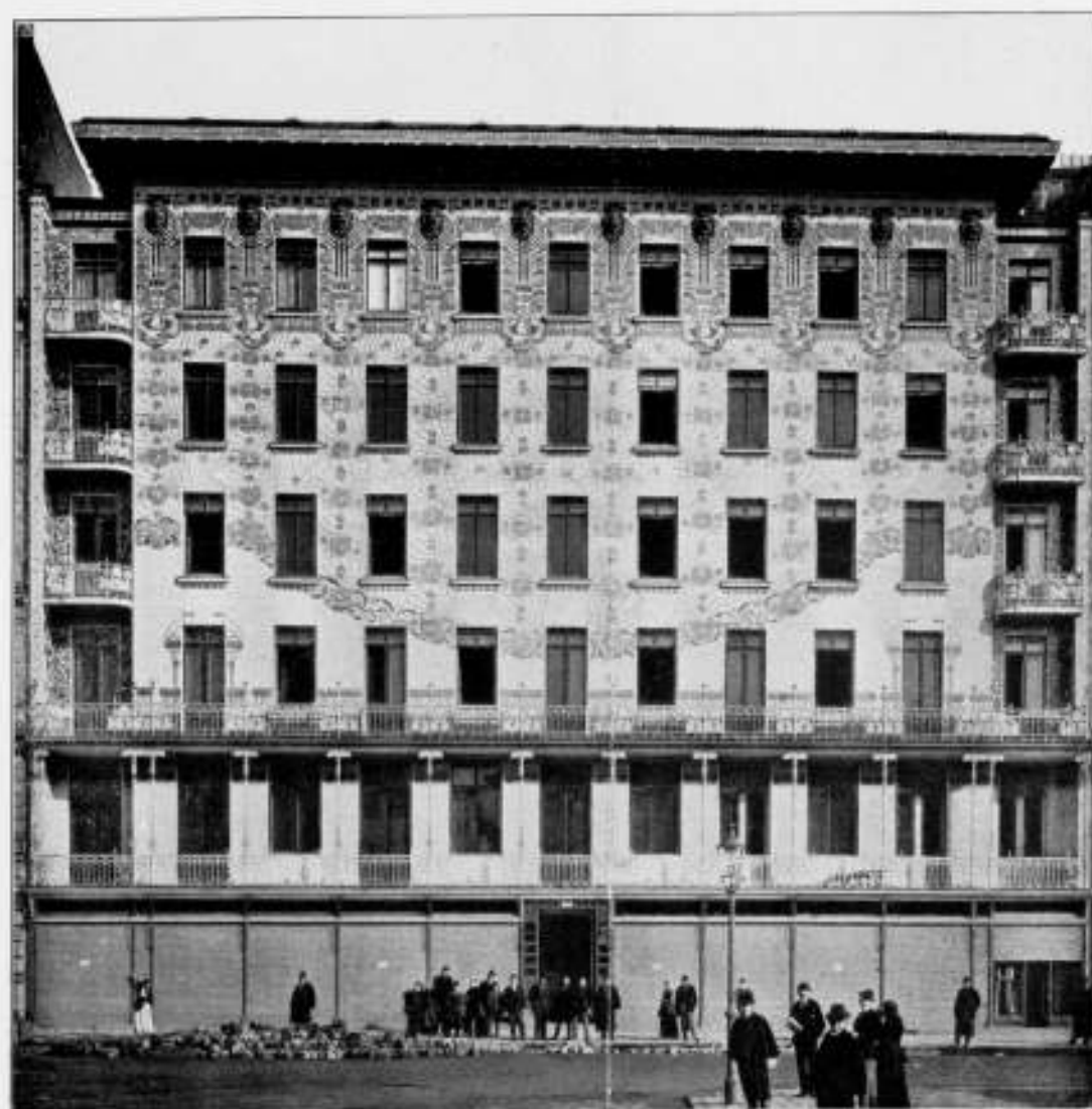
FIG. 4. WOONHUIS MAGDALENIENSTRASSE 40A. ARCHITECT OTTO WAGNER.
