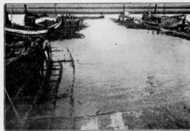
Fig. 2. Het rijzinkstuk voor het grootste deel geballast.
