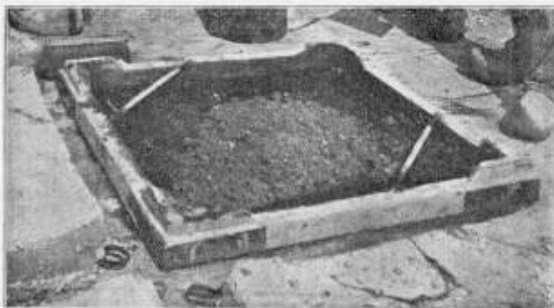
Fig. 5. De wapening ingelegd
