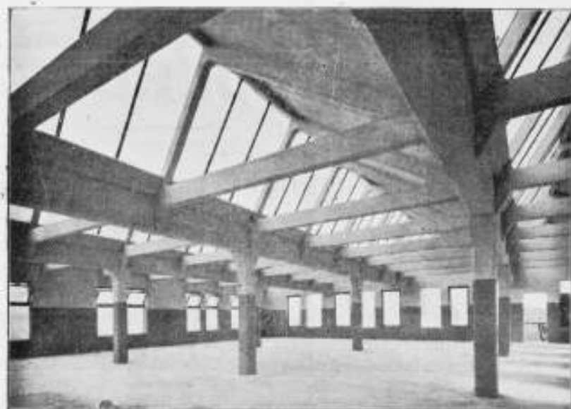
Gezicht op vloeren en kappen van GEBR. PALTHE te Almelo, uitgevoerd in gewapend beton.
