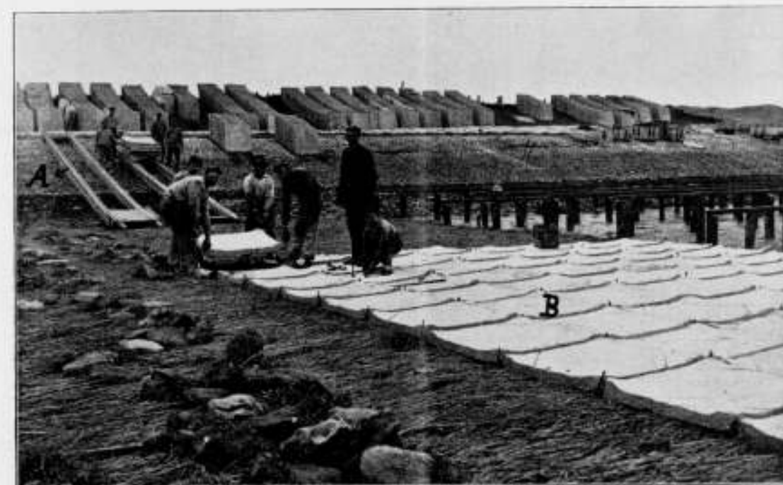
Fig. 9. Het monteren van een betonzinkstuk.
