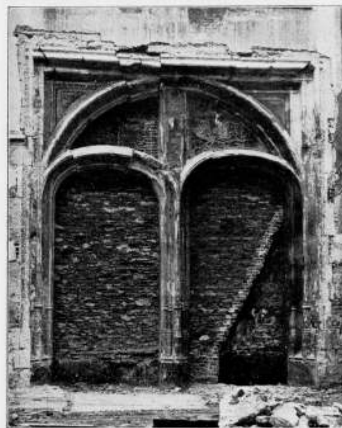
Gothische poort in den Zuider-transeptgevel van de N. Z. Kapel in de dichte van den muur gevonden.
