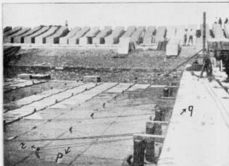
Fig. 26. Afbeelding van den rand van den drijver en gewicht op de verbindingsdraden. (De staaldraden P zijn 6 m.M. dik en kunnen 5000 KG. dragen.)
