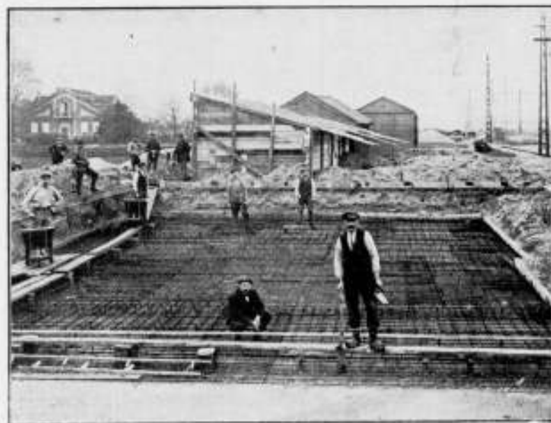
Funderingsplaat Station Nootdorp—Veerweg Z. H. E. Spm.
