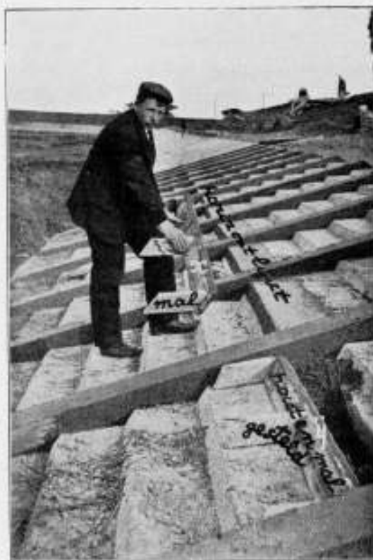
Fig. 15. Aanleg van een horizontale lijst van het balkenstelsel.
