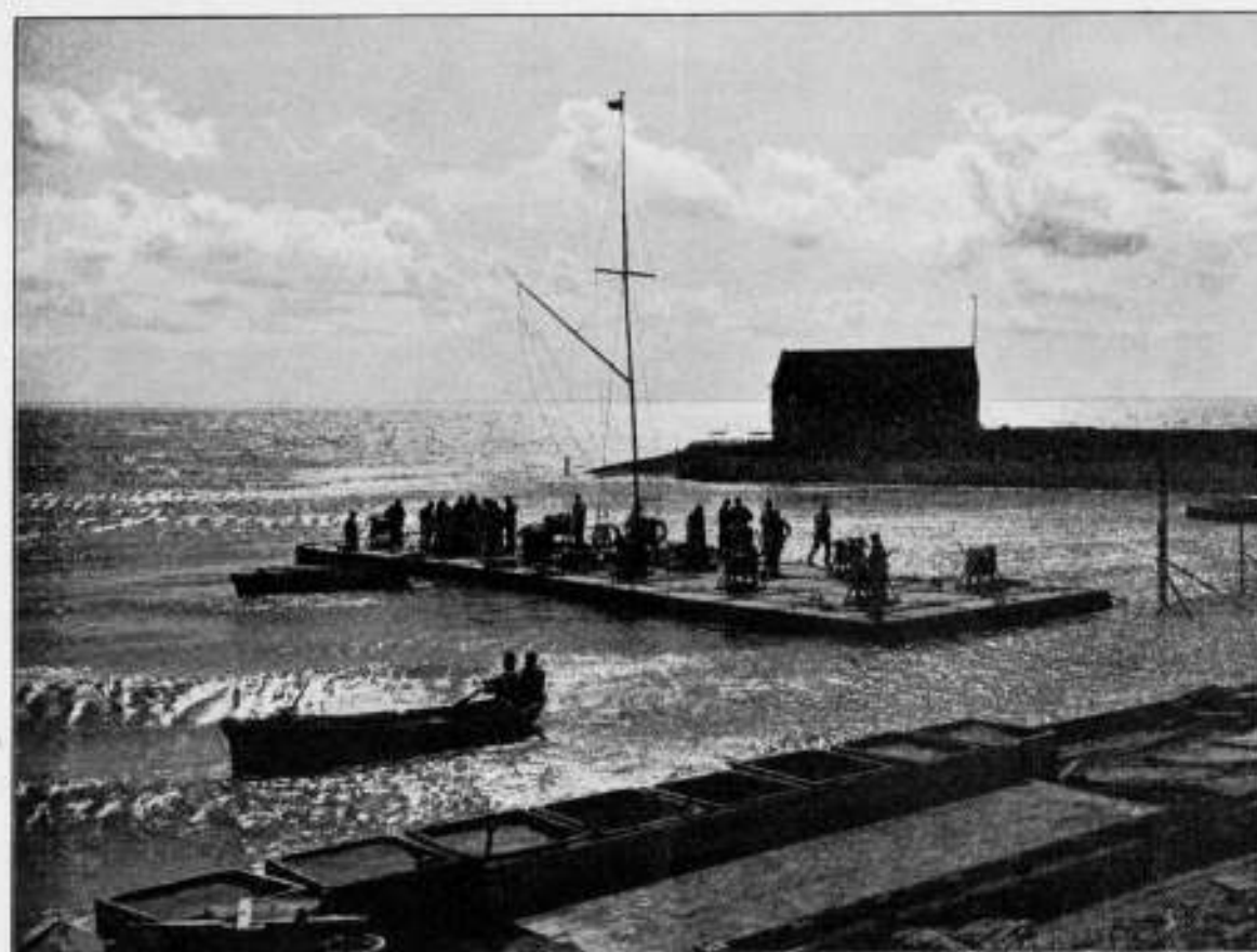
Fig. 28. De drijver verdeven boven het betonzinkstuk. Het betonzinkstuk wordt hierop onder tegen den drijver aangetrokken.
