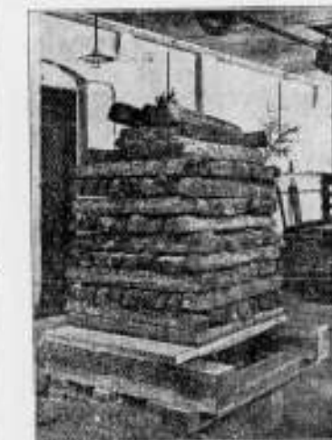
met ijzeren balken met een gewicht van twee duizend Kg. te-late CEMENTVLOER op STEENEN en s-grammen over 1.30 M. van elkaar liggende balken.
