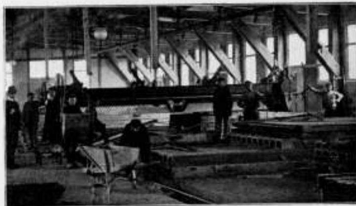
Fabriek te Stormpolder bij Rotterdam. Binnenaanzicht.
