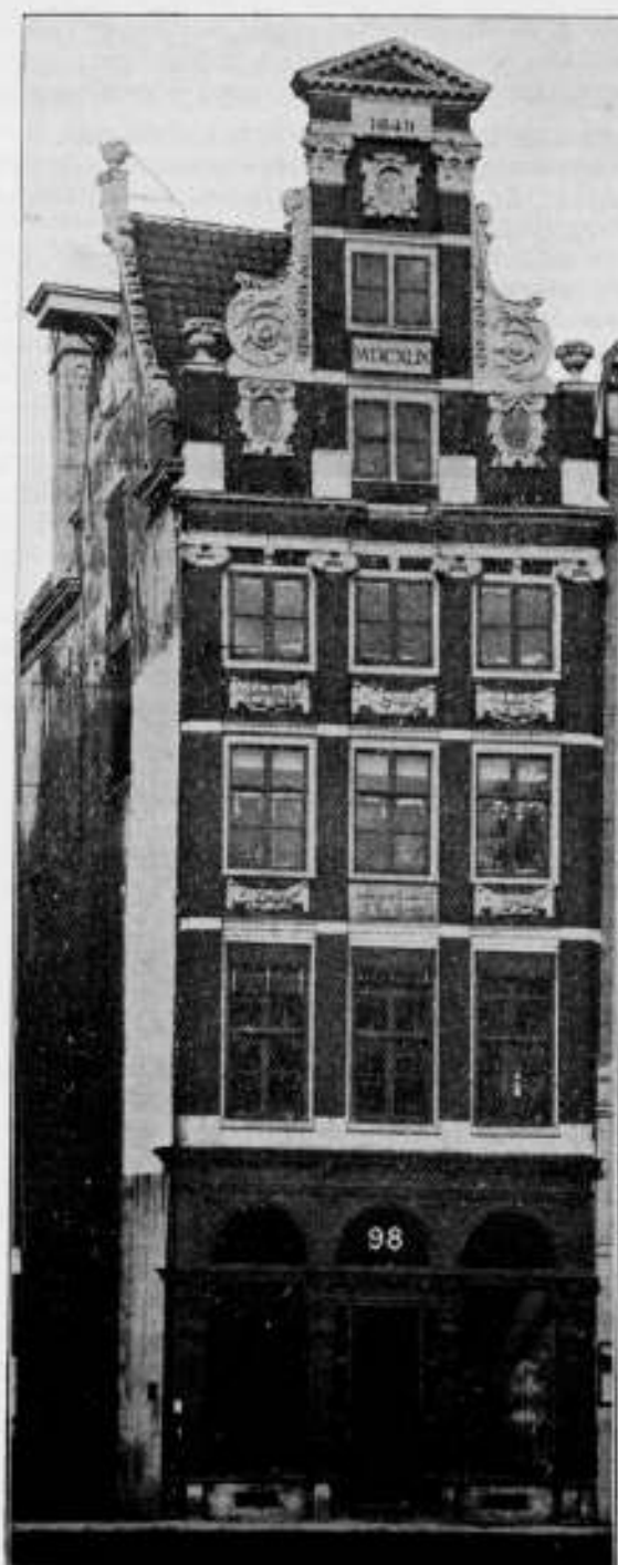
Afgebroken gebouw van 1649.
