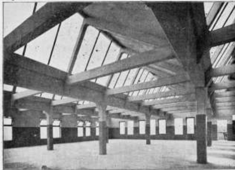
Gezicht op vloeren en kappen van GEBR. PALTHE te Almelo, uitgevoerd in gewapend beton.
