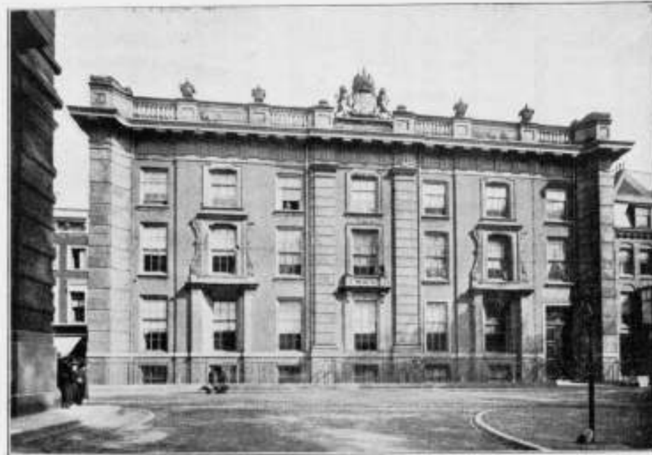
Het voormalig Rijks-Archiefgebouw.
