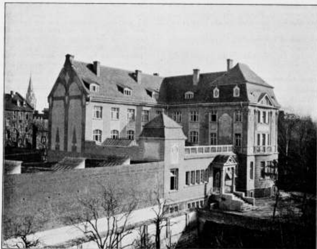
Administratie gebouw der Ortskrankenkasse.
