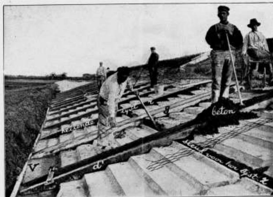
Fig. 14. Aanleg van de hellende lijsten.
