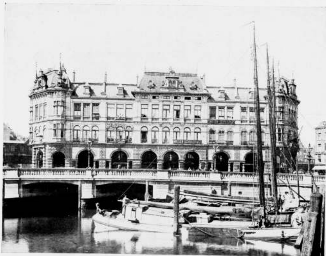
Bouwcomplex Plan C te Rotterdam (gebouwd in vereeniging met den Heer A. W. van Dam.)
