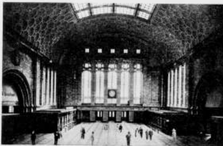
Afb. 15. De entree-vestibule van het nieuwe station te Leipzig.
