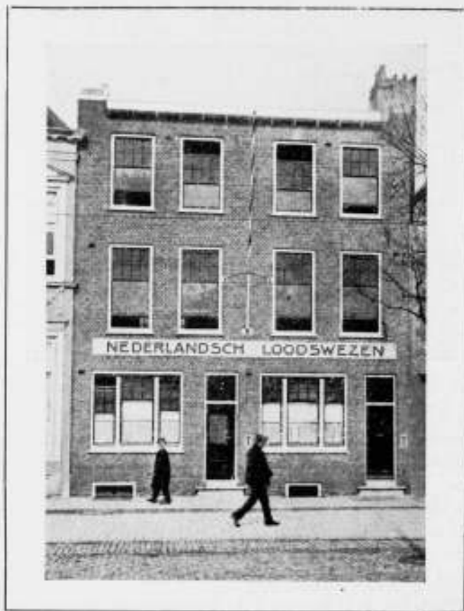
Afb. 3. Door het Rijk anno 1912 gebouwd Loodskantoor te Vlissingen, geflankeerd door fraaie Renaissance gevels. In de lichtopeningen schreeuwend geel gekleurd glas.
