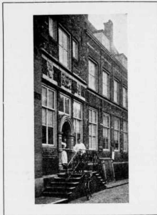
Afb. 5. Rijkskleedingmagazijn te Middelburg. In 1906 werd een aanvang gemaakt met het bepleisteren van de muren, terwijl het steenen beeldhouwwerk steeds geveerd wordt.
