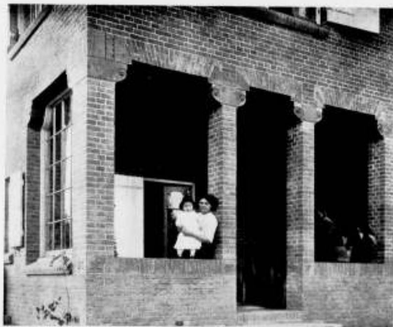
DETAIL VAN DE LOGGIA.
