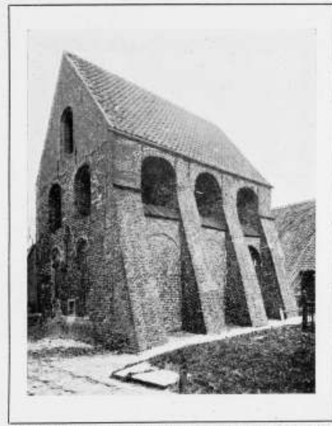
Afb. 4. Baksteenen klokkengestoele in torenvorm te Hinlo in Oost-Friesland.
