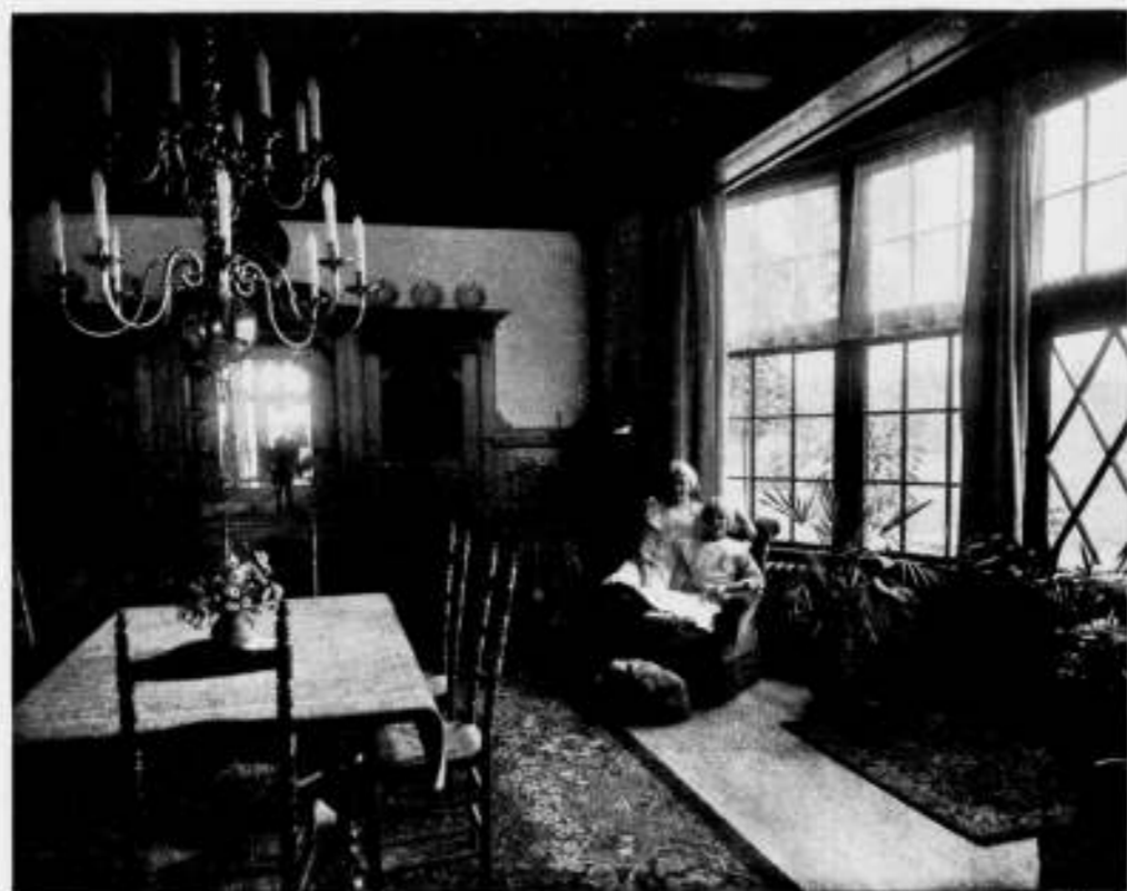
LANDHUIS TE BOEKELO. Buitenaanzicht en Eetkamerinterieur.
