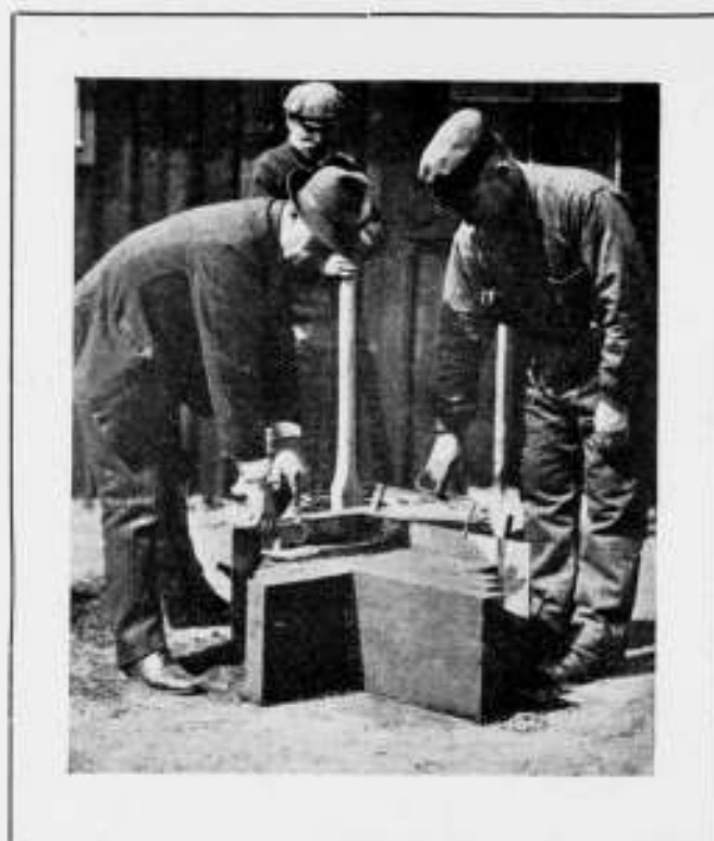
Afb. 5. Het maken van beton steenen.
