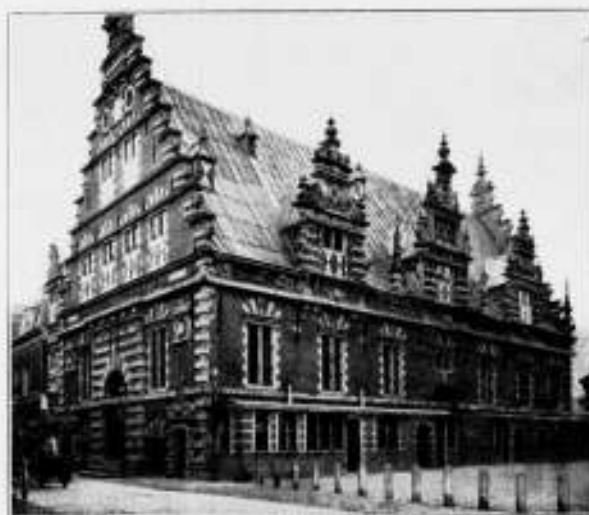
VLEESCHHAL TE HAARLEM. Prachtige architectuur (begin 17de eeuw) groote rijkdom bij rust en kloekheid in de hoofdzaken (muren, topgevels en dak) de kleine ramen met forsche ontlastings bogen in stevige muurdammen.
