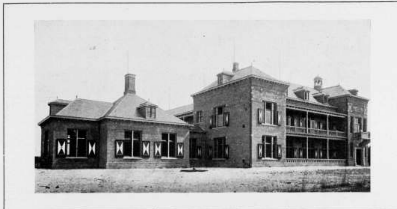
Te Huis voor alleenstaande blinden te Wolfhezen. Voorgevel.
