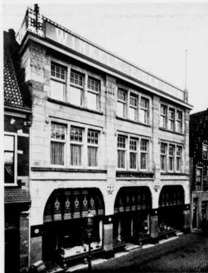
Winkelgebouw: „Eigen Hulp“ te Haarlem, Zijlstraat. Architect J. van den Ban. Bekroond met een zilveren medaille, uitgelooft door de Gemeente Haarlem.
