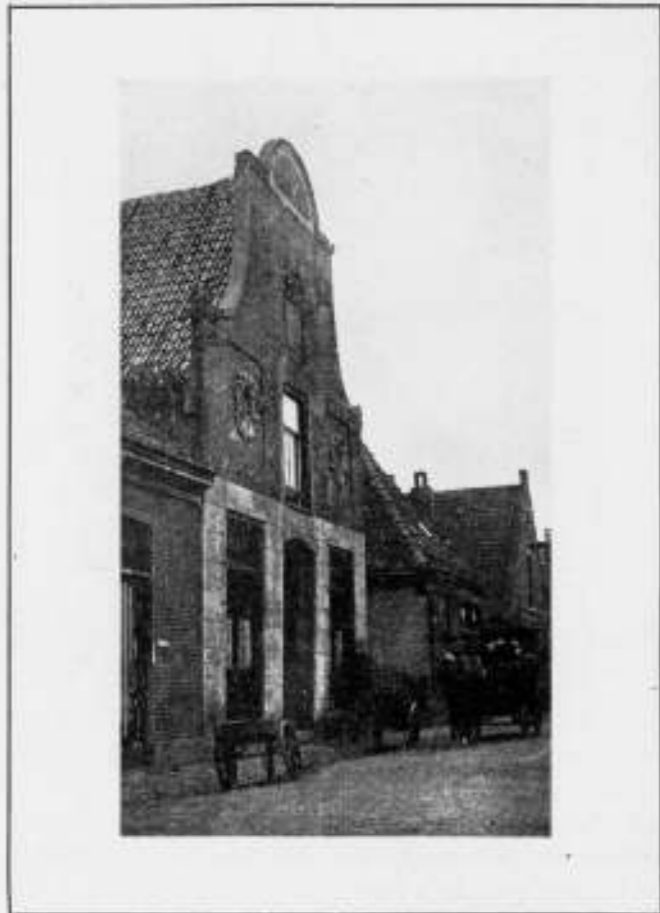
Afb. 5. Barockgevel aan de Middenstraat.
