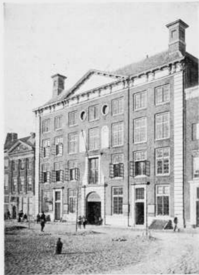
Afb. 6. Oost-Indisch huis te Middelburg. (Rijkseigendom). In 1911 wilde men de stijlvolle raamverdeling van dit gebouw door spiegelruiten vervangen, en een der deuren dichtmetselen, waardoor dit monument geheel zou zijn verknoeid.
