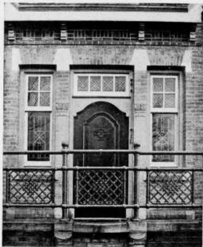
Detail van villa „Tunicum“ te Halfweg. Architect Adr. Moen. Zie de losse plaat.
