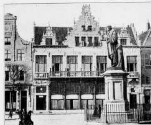
CAFÉ DE KROON TE HAARLEM. (Einde 19de eeuw). Gelegen tegenover de Vleeschhal en daarom getracht deze na te maken. Echter is hier de eisch geheel anders: opengevoerde gevel, veel glas, spiegelruit. Dit gegeven niet aanvaard en tot eigen kunst verwerkt. Van daar aesthetische conflicten, o. a. zware bovenbouw op lichte onderbouw, te forsche bogen boven de ramen der verdiepingen, die niet opgesloten zijn in muurdammen. Voorbeeld van slechte stijlnamaak.
