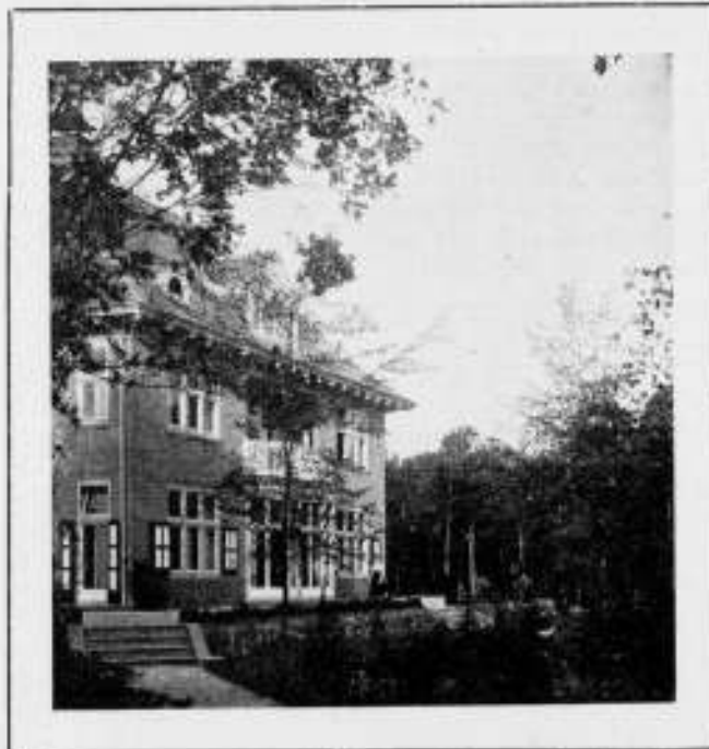
Villa te Heemstede, van Merlenstraat 4, van den heer F. van Heel. Architect K. P. C. de Bazel. Bekroond met de gouden medaille, uitgelooft door de Afdeeling Haarlem en Omstreken der Mij. t. bev. d. Bouwk. Tot haar leedwezen kon de Redactie van deze villa geen betere afbeelding geven. Zij hoopt echter binnen kort een duidelijker foto te reproduceeren. Het volledig Rapport der Jury van dezen gevelwedstrijd is opgenomen op blz. 597 en 598.
