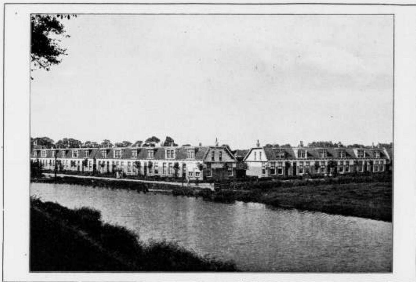
Afb. 2. GEMEENTELIJKE WONINGEN TE FRANEKER (NOORDERPOORT) UH Friesland en de Woningwet, door Th. van Welderen baron Rengers en J. H. Faber.
