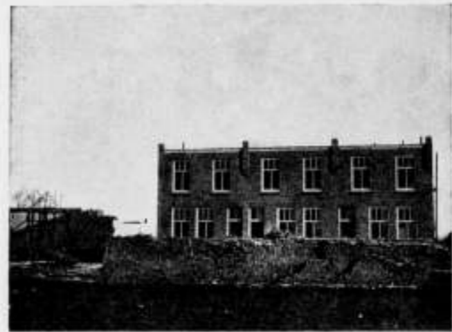
Volkswoningbouw, vakpatroons, Wippolder, Delft. 1916-1917.
