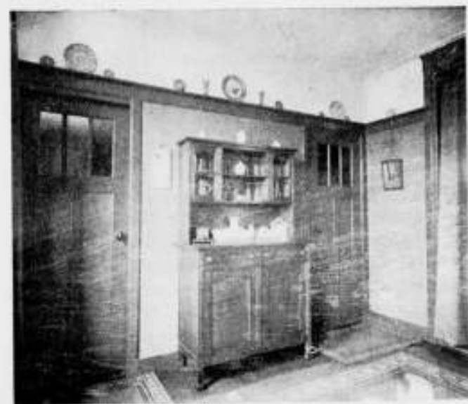
Wand met schilderijlijst en aansluitende deuromtimmering in een woning van de „Algemeene“ aan het Spreewenpark benoorden het IJ te Amsterdam.
