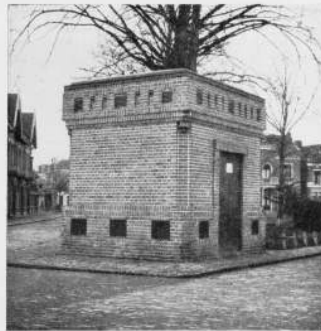
Schakelhuisje van de IJssel Centrale te Deventer. W. Uytendoude, Architect.
