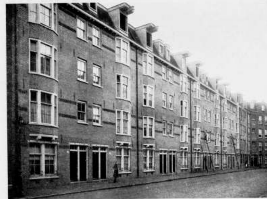
Bij perceelen aan de Hasebroekstraat te Amsterdam van de Vereeniging „Amsterdamsch Bouwfonds”. Architect J. E. van der Pek. Elk woonhuis heeft twee toegangen: één voor de benedenwoning en de andere gemeenschappelijk voor de drie bovenwoningen.
