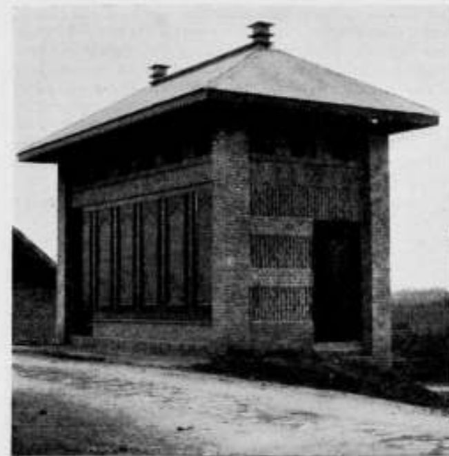
Transformatorhuisje te Aerdt, Gelderland.
