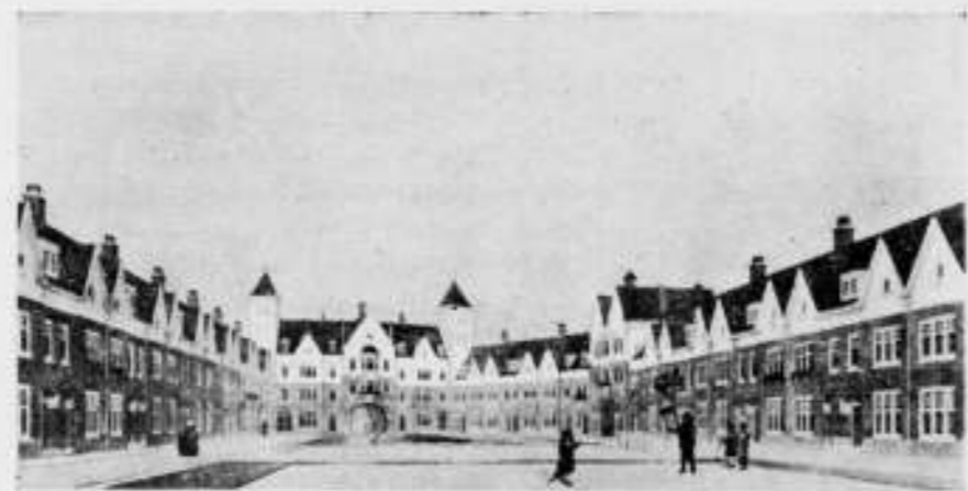
Hofbouw in aanbouw in de Spaarndammerbuurt te Amsterdam. Architect H. J. M. Walenkamp Czn.
