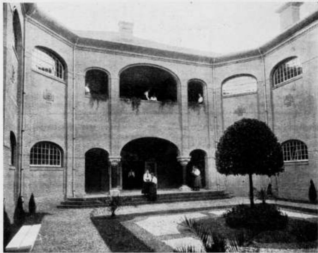
Hoogere Burgerschool voor meisjes te Arnhem. Hof. Bureau: Gemeentewerken Arnhem. Architect C. G. Bremer b.l.
