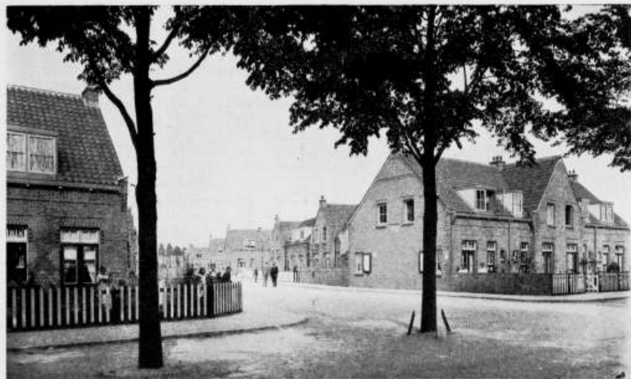
Arbeiderswijk van de Vereeniging „Zuilen“ bij Utrecht. Gezicht in de Marconistraat uit punt G aan den Amsterdamschen straatweg.
