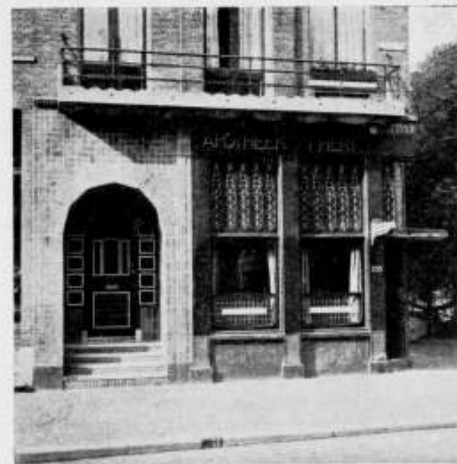
Apotheek 't Hert. Gevel na de verbouwing.
