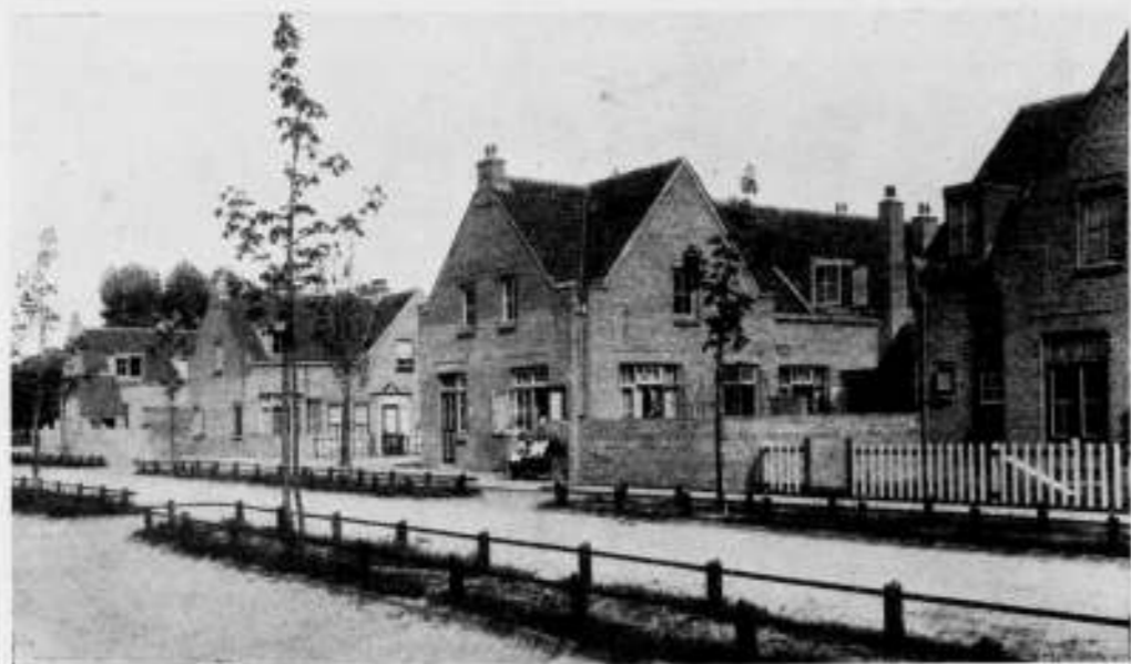
Arbeiderswijk van de Vereen. „Zuilen”. Hoekpartijen aan de De Lessepstraat gezien van uit punt N.
