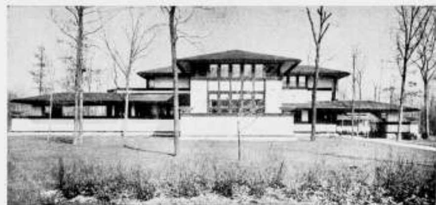
Fig. 14. Woonhuis Highland Park III.
