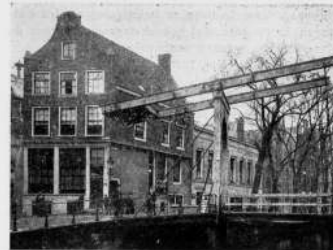
Het huis Staalstraat hoek Groenburgwal te Amsterdam.
