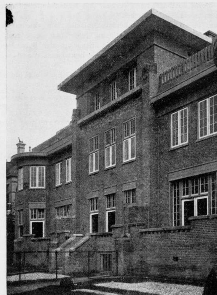
WOONHUIZEN IN HET WILLEMSPARK.
