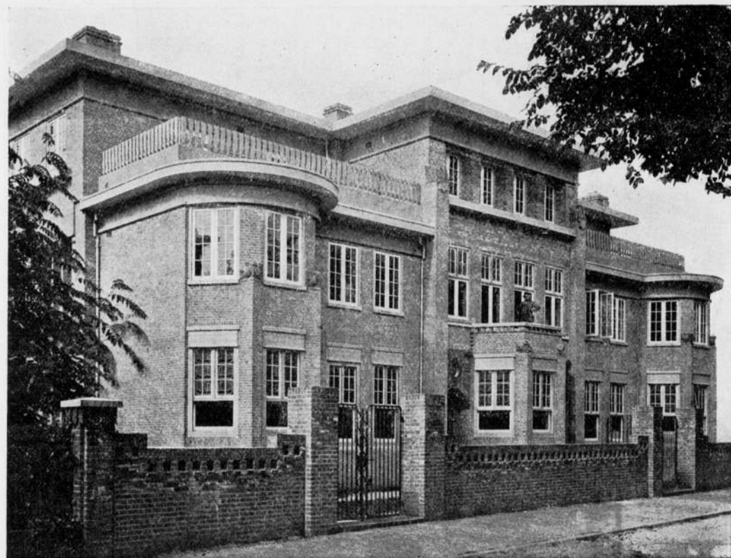
WOONHUIZEN IN HET WILLEMSPARK.
