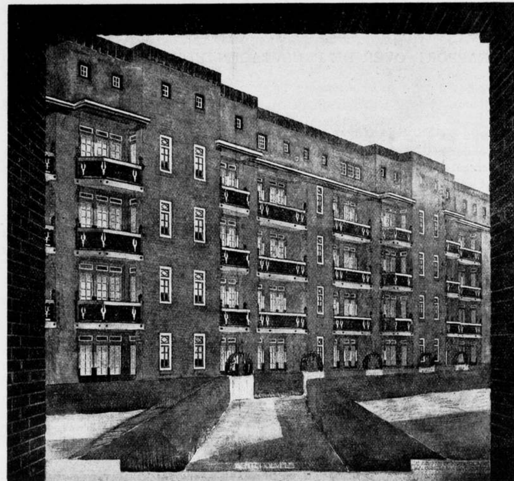
GEMEENTELIJKE WONINGBOUW TRANSVAALBUURT, AMSTERDAM. HOOGBOUW, ACHTERGEVEL.
