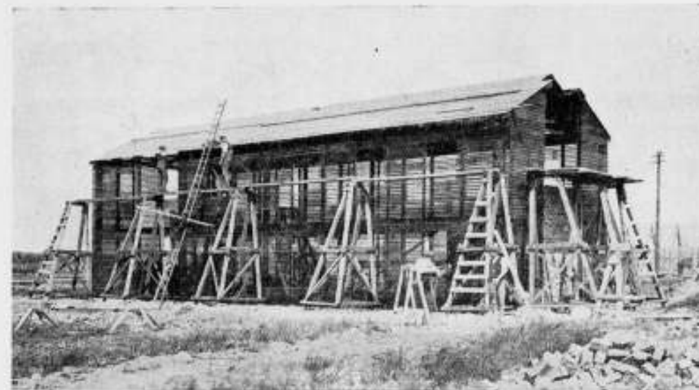
„DORLONCO“ DUBBEL-HUIS-TYPE B, STALEN „FRAME“ OPGERICHT, HY-RIB BEVESTIGD EN DAKBESCHIETING AANGEBRACHT.
