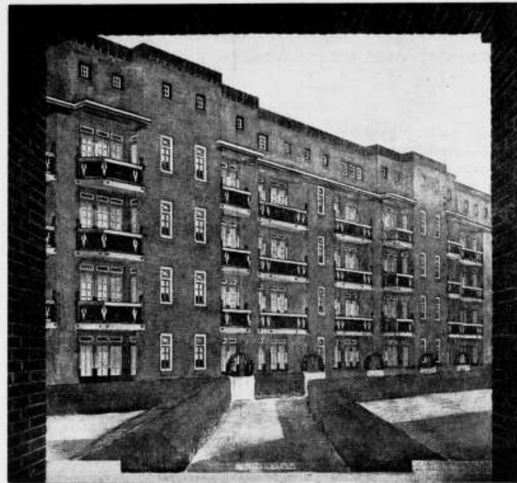
GEMEENTELIJKE WONINGBOUW TRANSVAALBUURT, AMSTERDAM. HOOGBOUW. ACHTERGEVEL.
