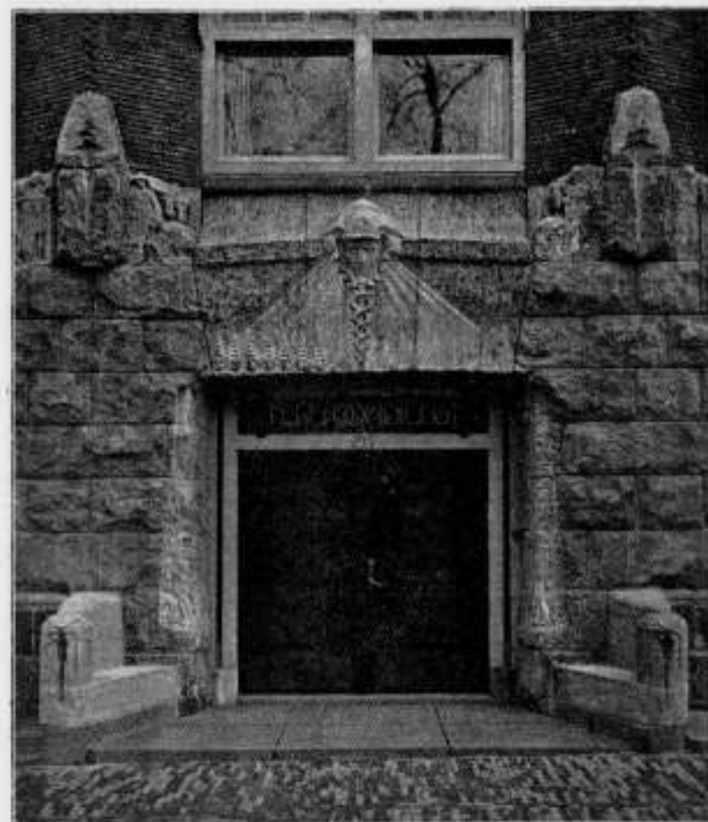
3DE TELEFOON-CENTRALE: GEVEL HEERENGRACHT (HOOFDINGANG).
