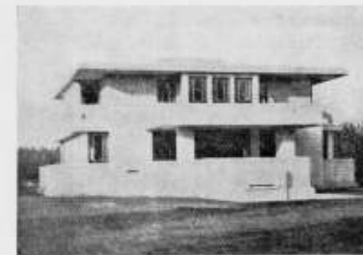
Afb. 23. WOONHUIS „HUIS TER HEIDE”. ARCH. R. VAN 'T HOFF, 1916.
