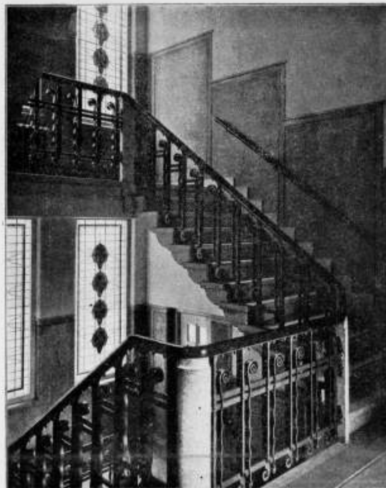
3DE TELEFOON-CENTRALE: TRAPPENHUIS AAN DE HEERENGRACHTZIJDE.
