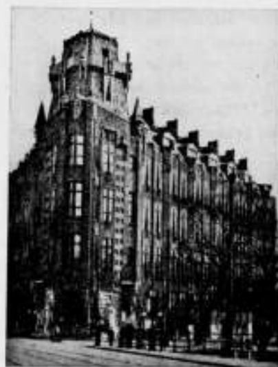
Afb. 21 A. KANTOORGEBOUW „HET SCHEEPVAARTHUIS". ARCH. J. M. VAN DER MEY.
