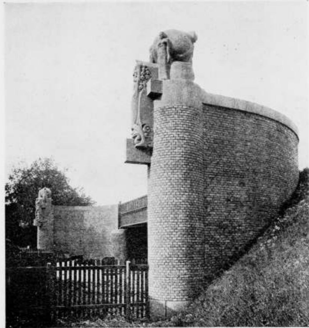
VIADUCT BIJ DE SPAARNDAMMERSTRAAT TE AMSTERDAM.
