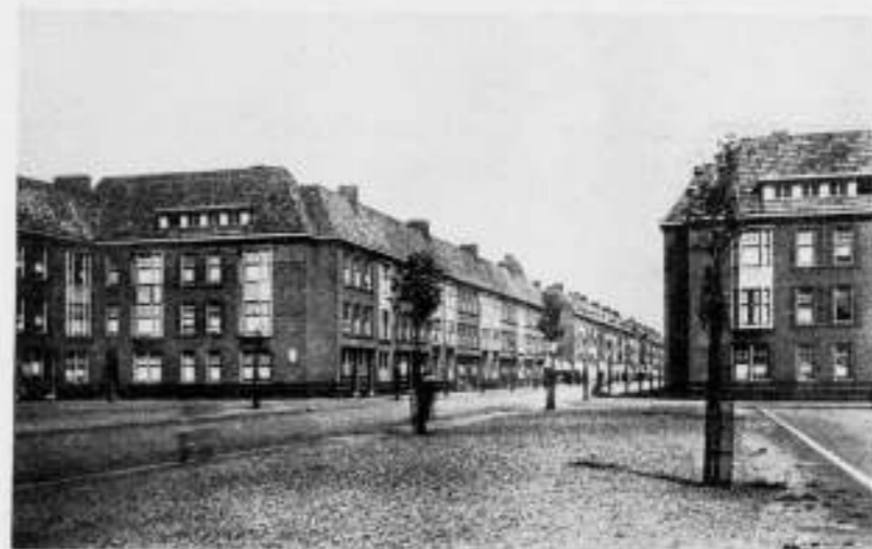
DE BILDERDIJKSTRAAT, GEZIEN VAN UIT DE SPAANSCHER BOCHT. WONINGBOUW: „ONZE WONING". MEISCHKE EN SCHMIDT, ARCH.
