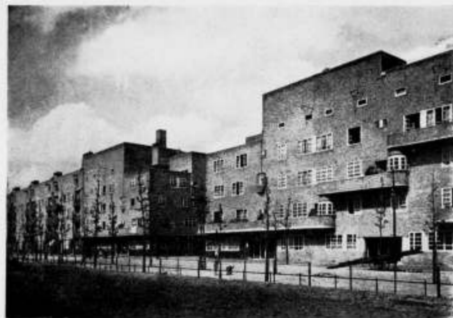
DE AMSTELLAAN. GEVELS VAN M. DE KLERK.
