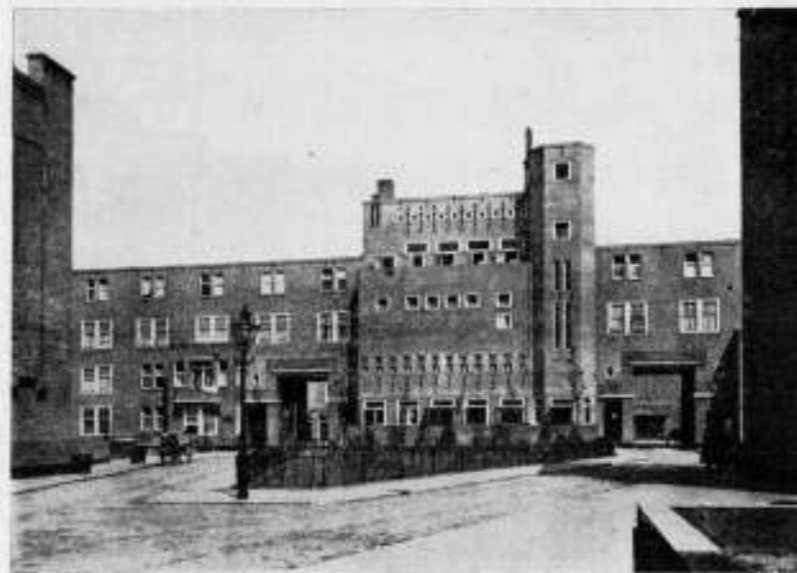
GALERIJBOUW, GEZIEN DOOR DE POORT IN DE JAN LUYKENSTRAAT. IN HET MIDDEN HET WASCHHUIS. ARCHITECT: M. BRINKMAN.
