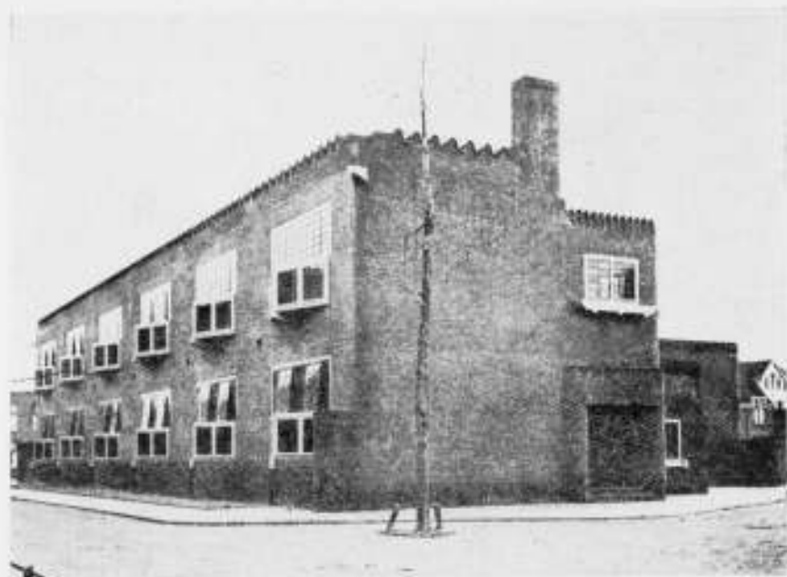
DA COSTA-SCHOOL TE UTRECHT. ACHTERGEVEL.
