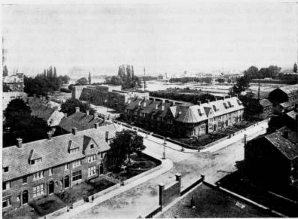
MIDDENSTANDSWONINGEN VAN DE BOUWVERENIGING „WONINGZORG” TE MAASTRICHT. ARCHITECTEN: V. F. MARRÉS EN W. J. SANDHÖVEL, B. N. A.
