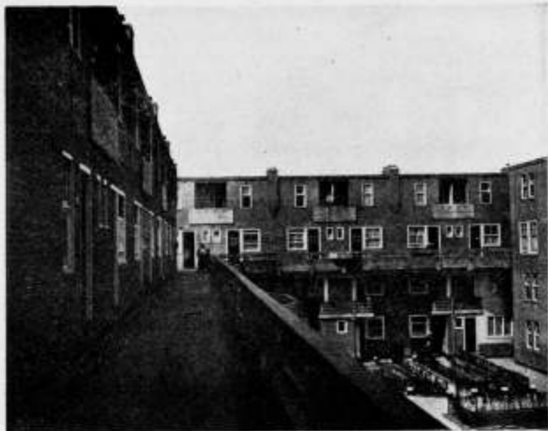
GALERIJBOUW, BINNENTERREIN GEZIEN VAN AF DE GALERIJ. ARCHITECT: M. BRINKMAN.
