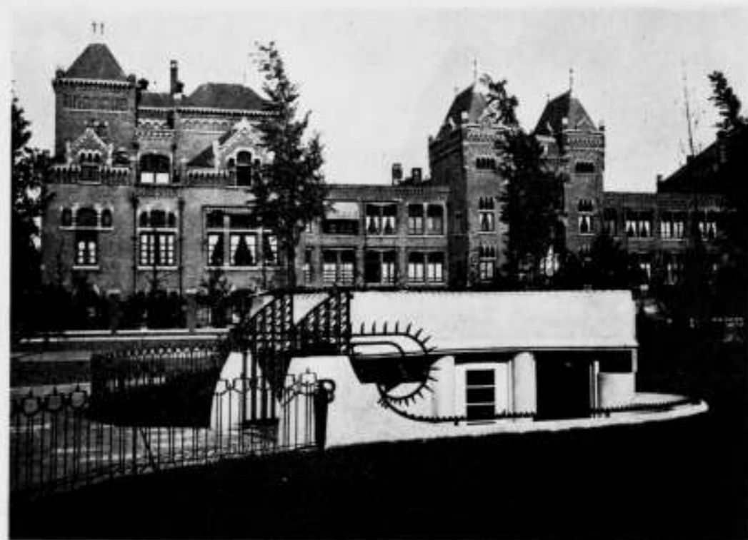
EEN DER ONDERGRONDSCH E TOILETGELEGENHEDEN OP HET VALERIUSPLEIN. OP DEN ACHTERGROND DE VALERIUSKLINIEK. ARCHT. H. BONDA.
