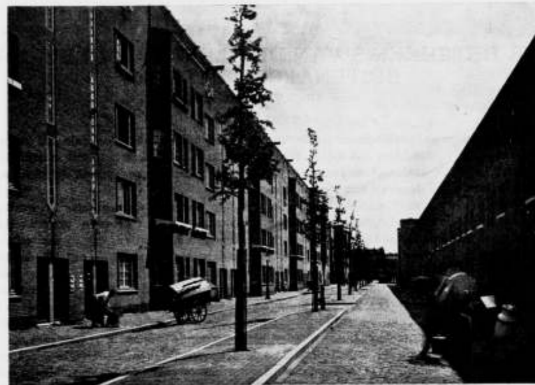
DE GERAARD TERBORGSTRAAT. LINKS DE HOOGBOUW, RECHTS DE LAAGBOUW. WONINGCOMPLEX VAN DE AMSTERDAMSCH E COÖPERATIEVE WONINGVEREENIGING „SAMENWERKING“.
