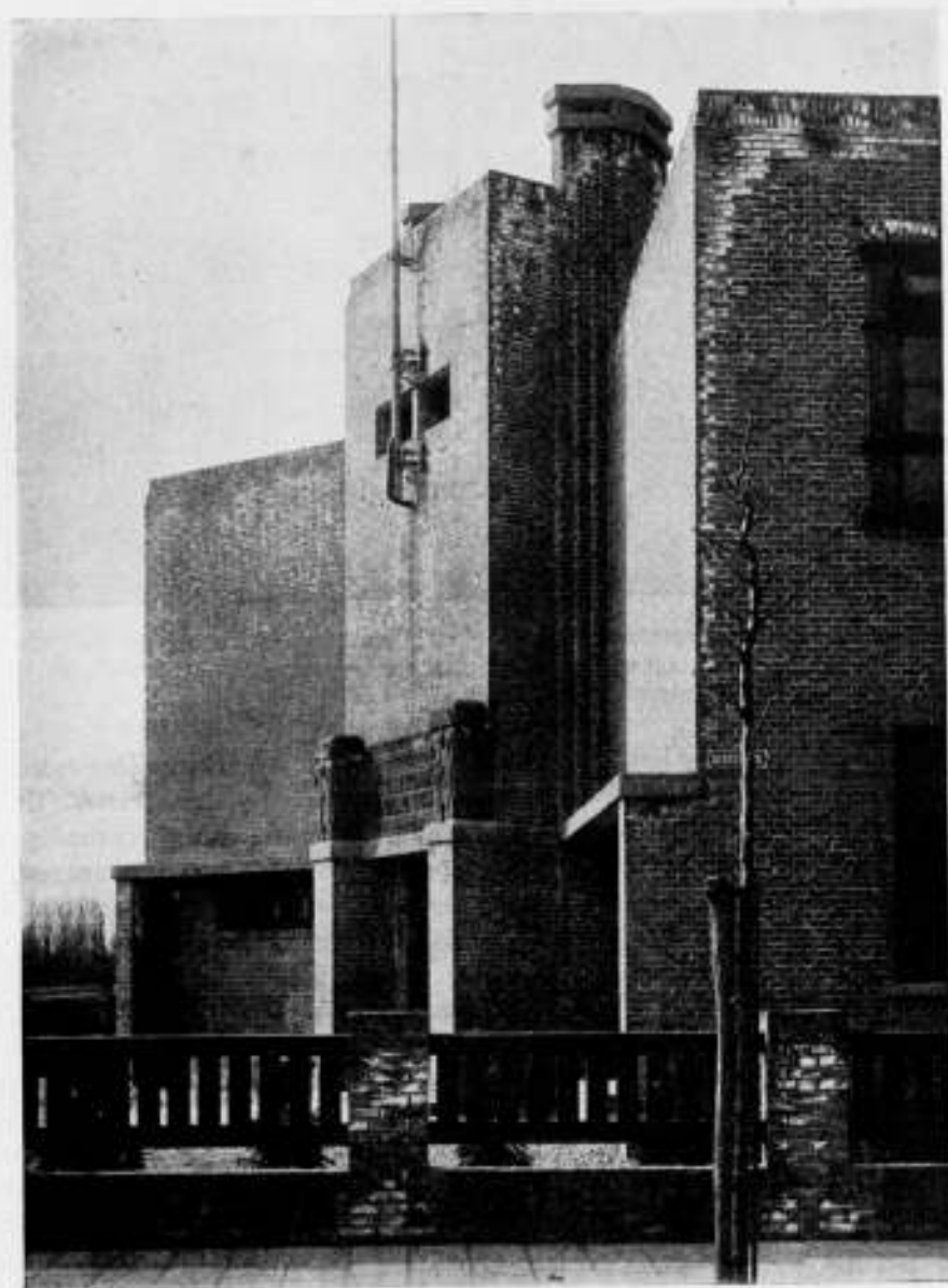
INGANG WILHELMINA - M. U. L. O. SCHOOL TE VOORBURG. ARCHITECT H. V. D. KLOOT MEYBURG.
