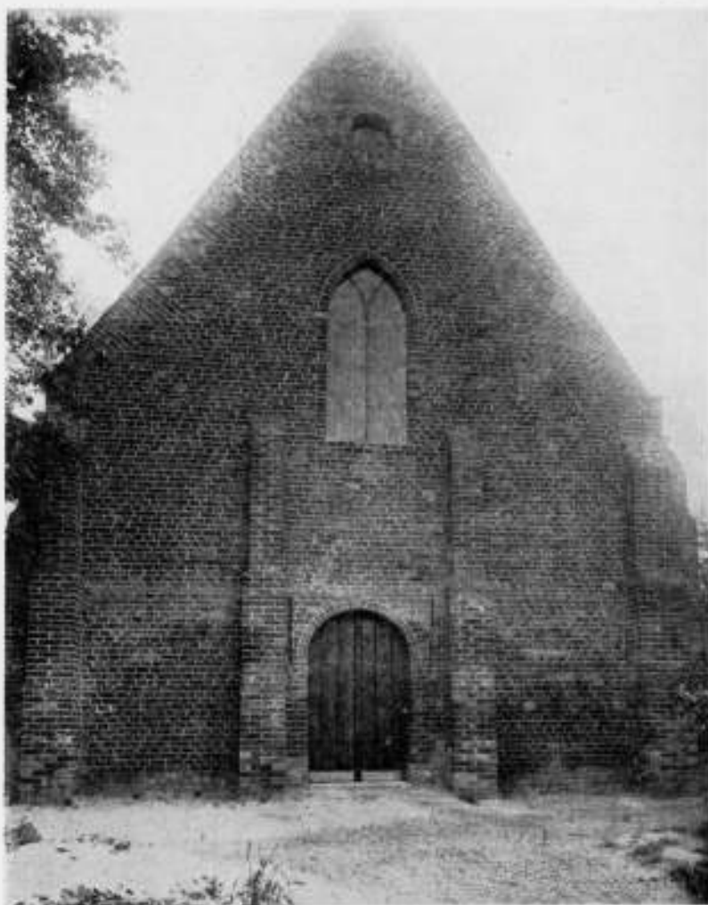
KERKJE TE KLOOSTERZANDE. WESTGEVEL NA DE RESTAURATIE.
