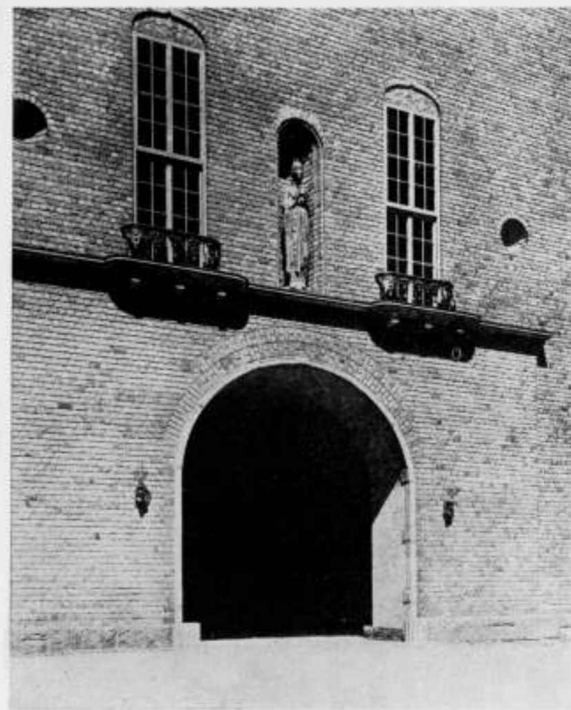
POORT AAN DE OPEN BINNENPLAATS.
