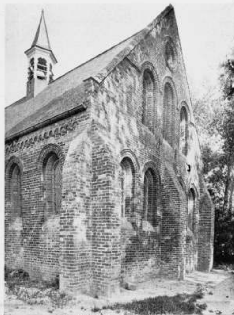
OOSTGEVEL NA DE RESTAURATIE.
