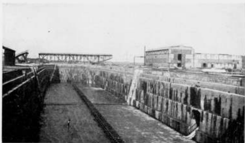
DOK IN GEWAPEND BETON MET LOOPKRANEN TE AMSTERDAM.
