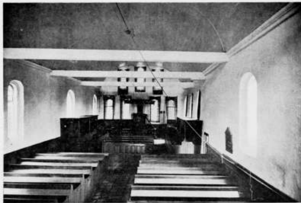
INTERIEUR NAAR 'T OOSTEN VÓÓR DE RESTAURATIE.
