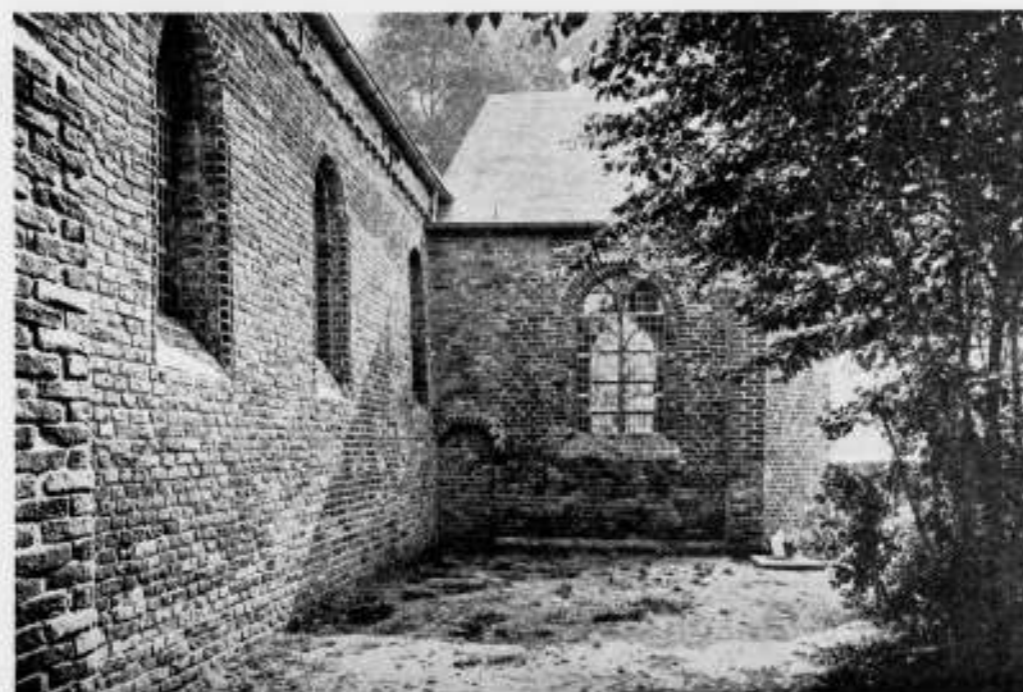
ZUIDGEVEL NA DE RESTAURATIE.
