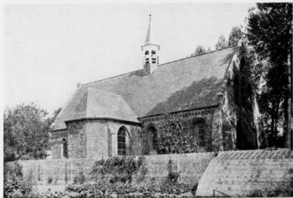
KERKJE NA DE RESTAURATIE. ZUID- EN OOSTGEVEL.
