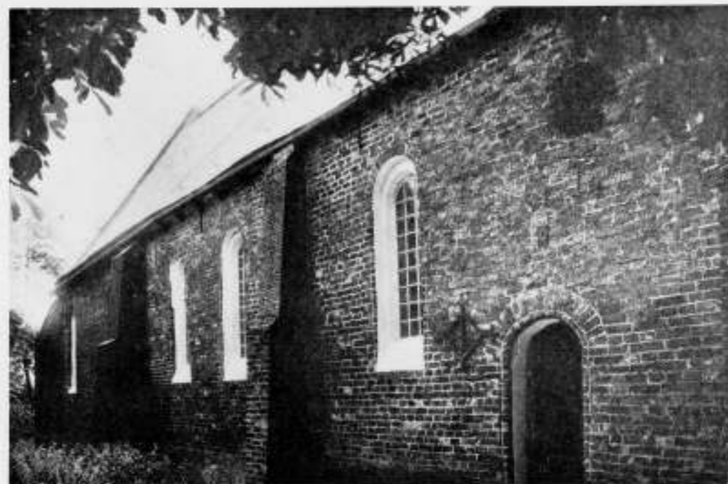
NOORDGEVEL VOOR DE RESTAURATIE.
