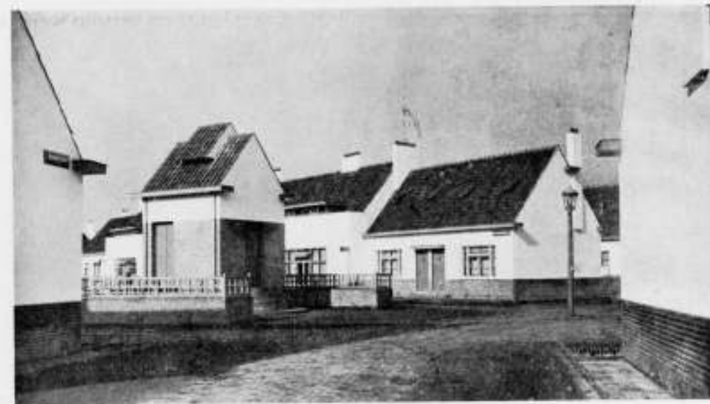
GEMEENTELIJKE WONINGBOUW: „OUD MATHENESSE" TE ROTTERDAM. BOVEN: DE DAMLOOPSTRAAT, GEZIEN UIT PUNT F. ONDER: DE DAMLOOPSTRAAT, GEZIEN UIT PUNT E.
