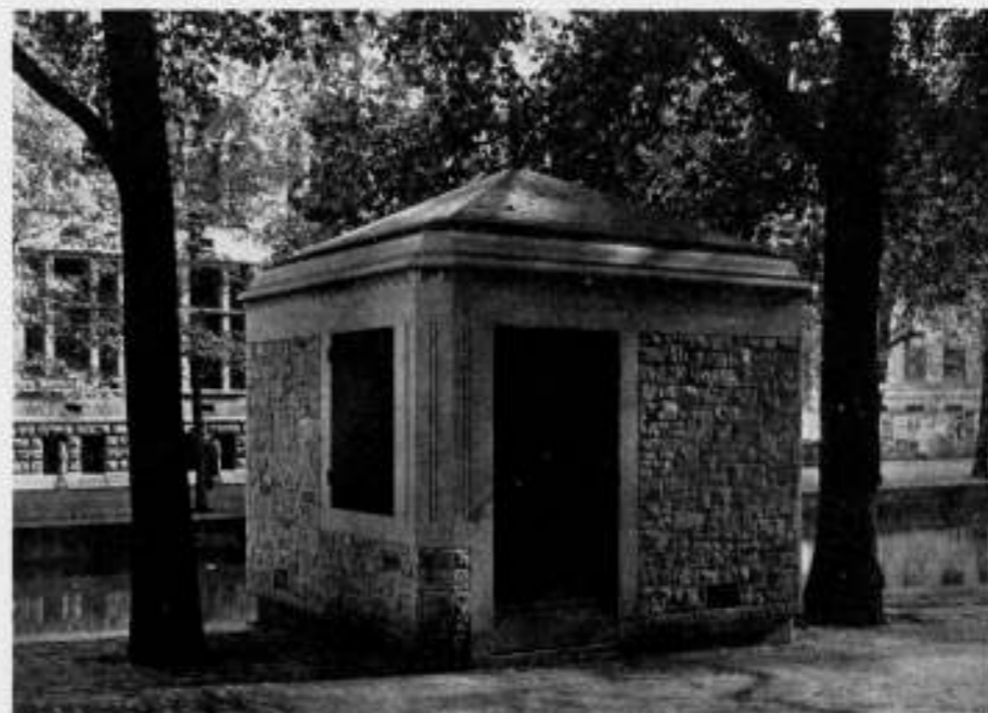
TRANSFORMATOREN-GEBOUWTJE HEERENGRACHT BIJ DE RAADHUISSTRAAT.
