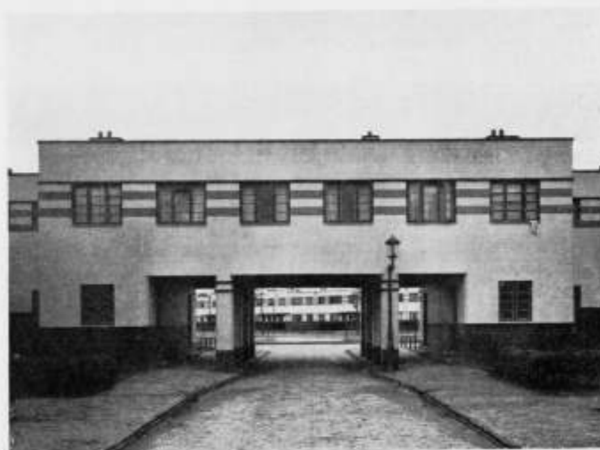
BETONWONINGEN IN ISOLA-BOUW TE ROTTERDAM. Doorkijk poort Dubbelmanstraat.
