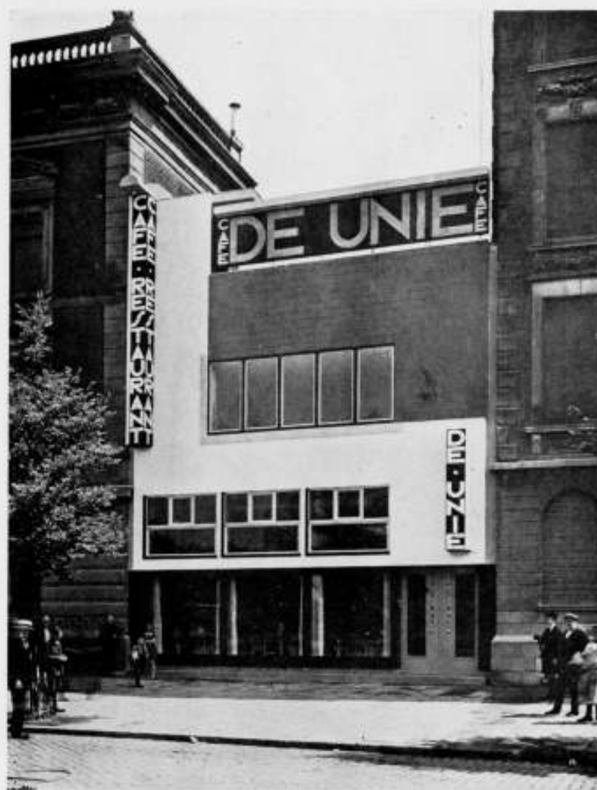
CAFÉ-RESTAURANT AAN HET CALANDPLEIN TE ROTTERDAM, ARCHITECT J. J. P. OUD.
