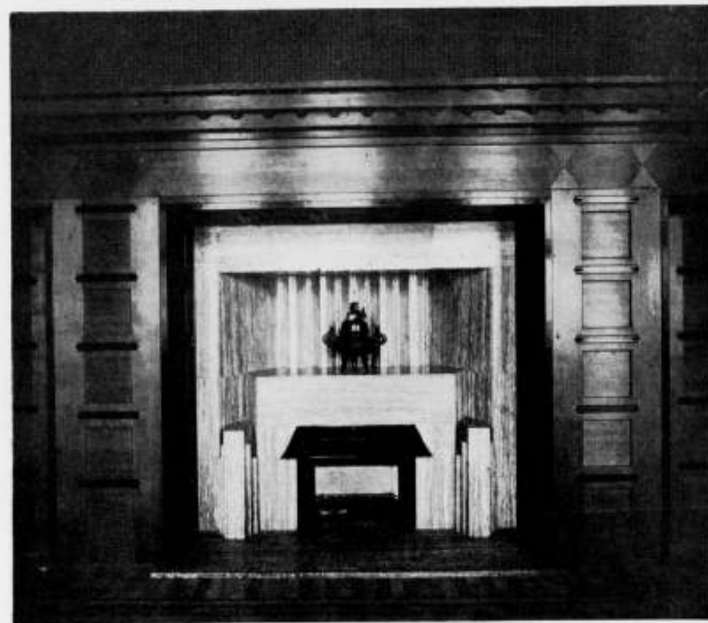
SCHOUW IN EEN DER DIRECTIEKAMERS, KANTOORGEBOUW „PETROLEA“ te GRAVENHAGE. DE ROOS EN OVERKLINDER, Architect B.N.A.
