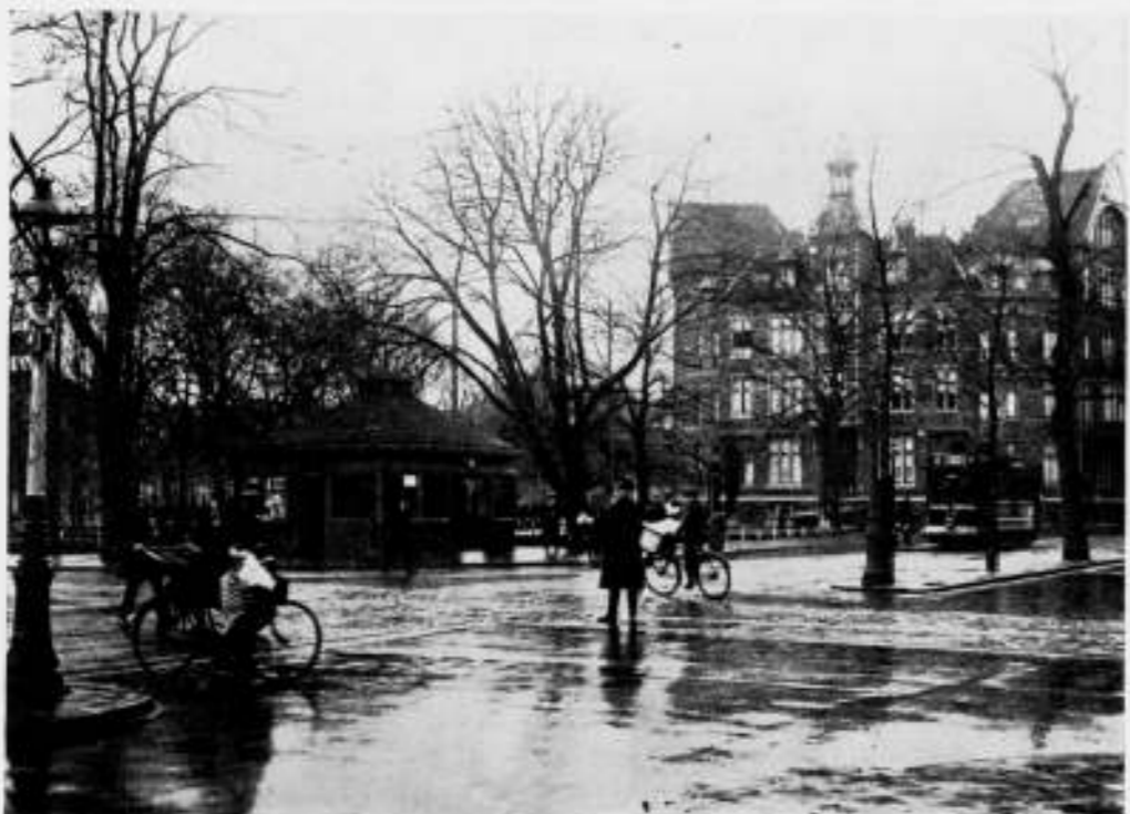
GEBOUWTJE, WAARIN TRAMWACHTKAMER, KIOSK, PUBLIEKE TELEFOONCEL EN TRANSFORMATORENRUIMTE.
