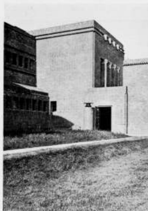
FRAGMENT VAN DEN ACHTERGEVEL R.H.B.S. TE TER APEL.
