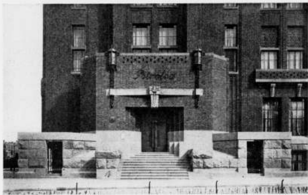
KANTOORGEBOUW „PETROLEA” -GRAVENHAGE. HOOFDINGANG.
