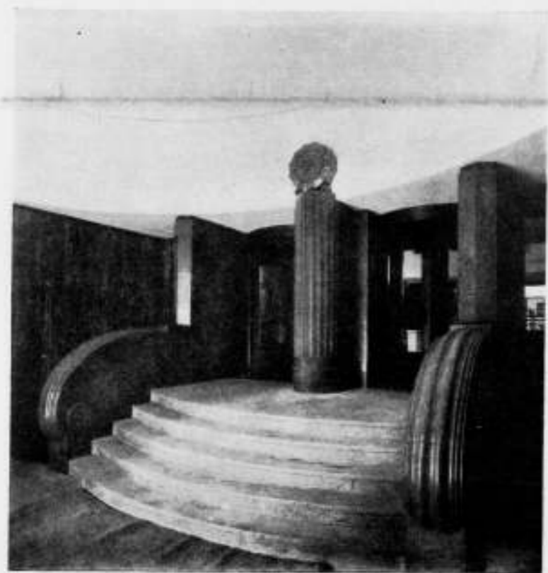
TRAP IN DE ENTREE. GEBOUW ROTTERDAMSCHER BANKVEREENIGING TE 's-GRAVENHAGE. Architect: Ir. H. F. MERTENS.
