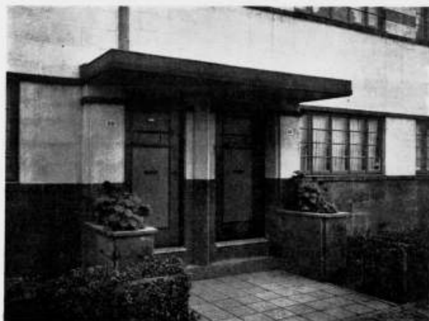
BETONWONINGEN IN ISOLA-BOUW AAN HET DORDMONDPLEIN TE ROTTERDAM. Voordeur-detail.
