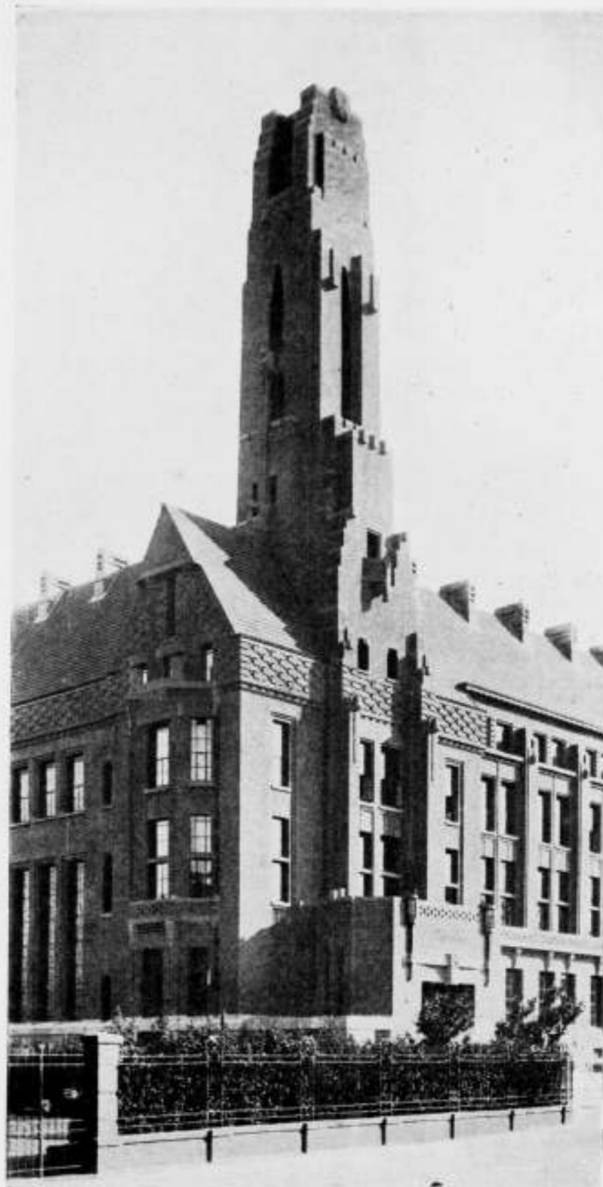
KANTOORGEBOUW „PETROLEA“ TE 's-GRAVENHAGE. DE ROOS EN OVEREIJNDER, Architecten B.N.A. FRAGMENT MET INGANG EN TOREN.
