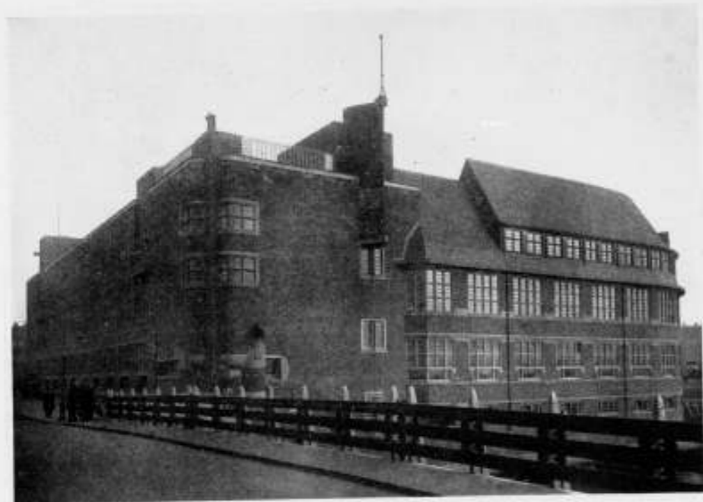
ACHTERGEVEL EN ZIJGEVEL.
