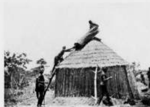
DE RIETDEKKER AAN HET WERK.
