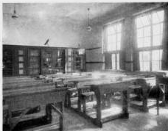
LESLOKAAL MET NATUURKUNDE KAST. CHRISTELIJKE SCHOOL AAN DEN OUDEN DIJK TE ROTTERDAM. ARCHITECT: IR. M. C. A. MEISCHKE B.N.A.
