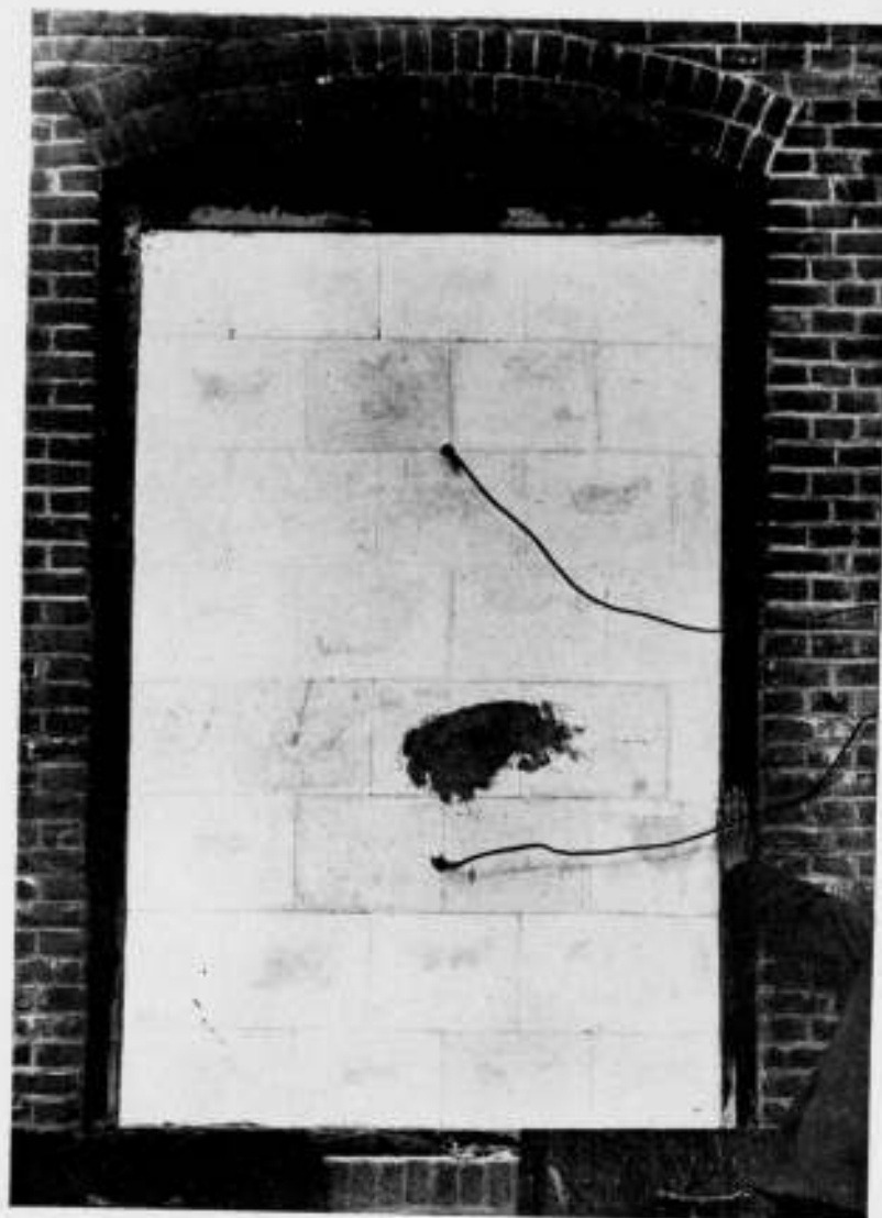
BUITENZIJDIGE CELLENBETONWAND NA DE PROEF.
