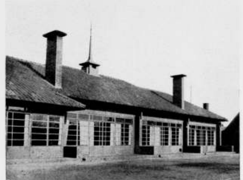
SCHOOL TE ALMELO, ARCH. IR. W. H. ENNO VAN GELDER, DIR. GEM. WERKEN.
