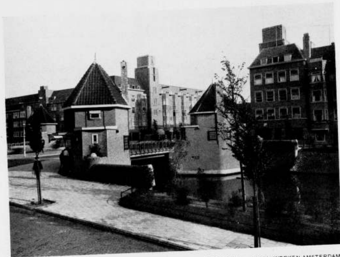
BRUG OVER DE JOZEF ISRAËLSKADE-EIND FERD. BOLSTRAAT AMSTERDAM. PUBL. WERKEN AMSTERDAM.
