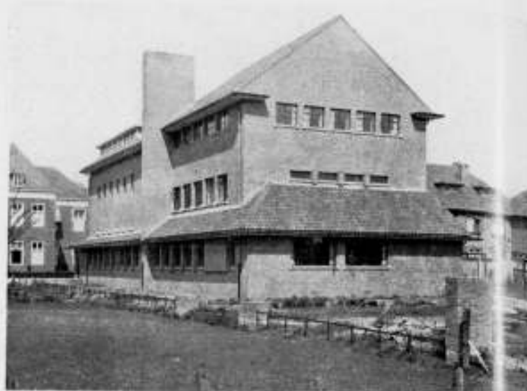
MACHINEHUIS WATERECHAP DE REGGE TE ALMELO, ARCH. DR. H. F. MERTENS I.N.A.
