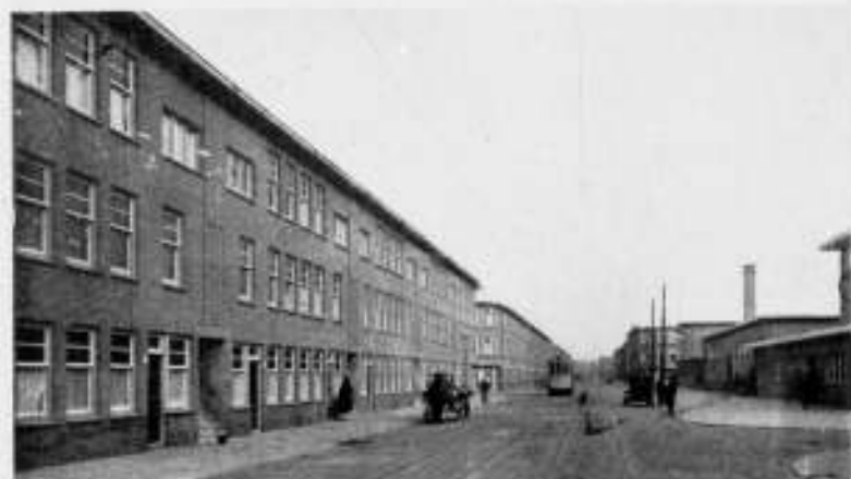
FIG. 49. STRAATBEELD IN NIEUW DUINDORP (PLUVIERSTRAAT), verhouding van straatbreedte en hoogte van bebouwing met het straatprofiel een belangrijke zaak, terwijl daar ook de architectonische detailverzorging van veel belang is, doordat de afstand waarop de bebouwing gezien wordt steeds gering is. Een gelijksoortige en overal even hoge bebouwing kan hier alleen bij in alle opzichten bevoegde architectonische verzorging leiden tot een straatbeeld dat door rust en ritme beheerscht wordt. (fig. 39, 46 en 50). Ontbreekt de noodige verzorging en bestudeering dan ontstaat een dorre troosteloze eentonigheid die b.v. het gehele boomlooze Boomenkwartier, de nieuwere gedeelten van Duindorp, Bezuidenhoutkwartier kenmerkt. (fig. 38, 45, 47, 48, 49, 51, 55 enz.). De op zichzelf zeker niet aanvechtbare indeeling van gesloten blokbebouwing waarbij de korte zijden onbebouwd blijven stelt hoge eischen aan de architectonische verzorging. Op tal van plaatsen is daaraan niet of slecht voldaan en is noch in de architectuur noch in de materialen rekening gehouden met het feit, dat daardoor de achterzijden der bebouwingen voor het stadsbeeld van groot belang gaan worden. (fig. 51, 53, 54, 57, 58 en 59).
