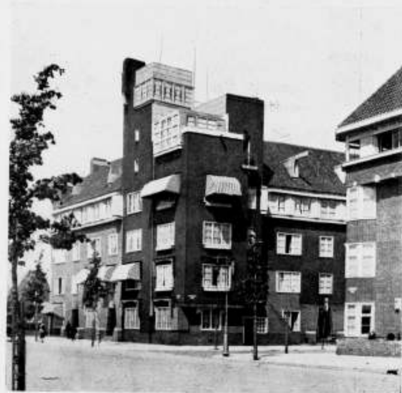
TITIAANSTRAAT HOEK OLYMPIAPLEIN. ARCH. J. M. VAN DER MEIJ.
