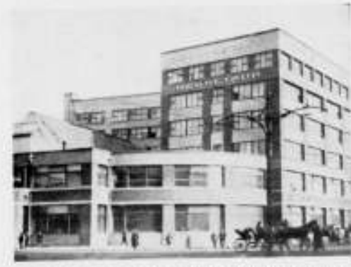
HET GEBOUW ORGA-METAL TE MOSKOU.
