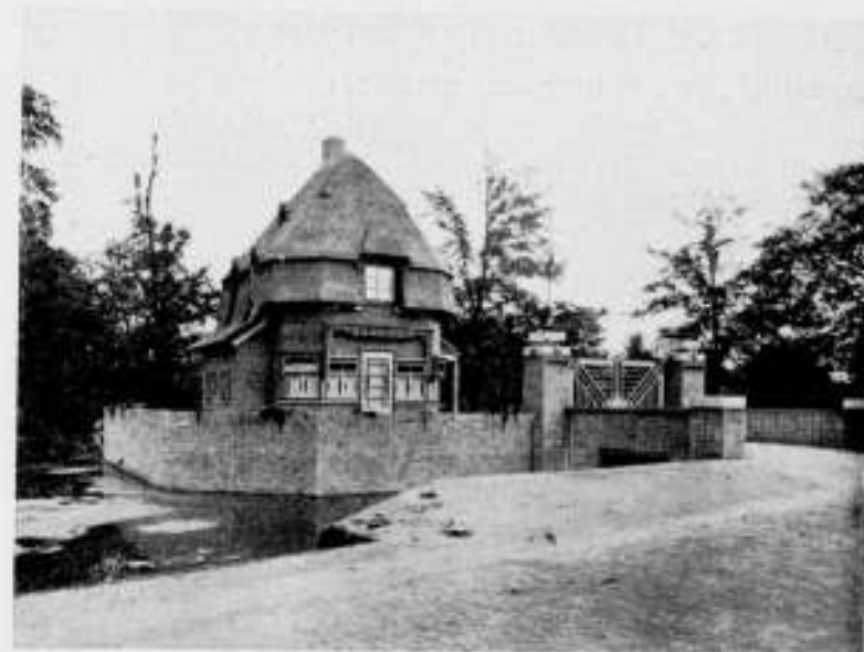
LANDHUIS „DE IPENHOF”. PORTIERSWONING.
