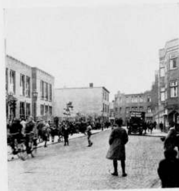
SLECHTE AANSLUITINGEN AAN BEBOUWING.
