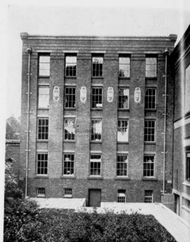
ARCHIEFGEBOUW DER ALGEM. FRIESCHE LEVENSVZERKERING MAATSCHAPPIJ 1923. ARCHITECT H. H. KRAMER B.N.A.
