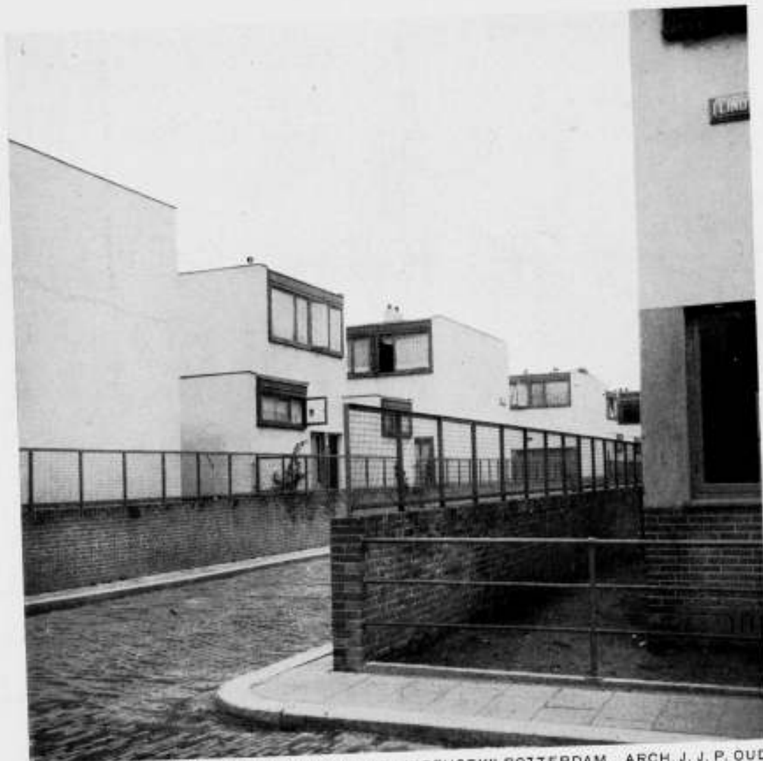
DWARSSTRAAT VAN DE LINDTSTRAAT IN DE „KIEFHOK” ROTTERDAM. ARCH. J. J. P. OUD.
