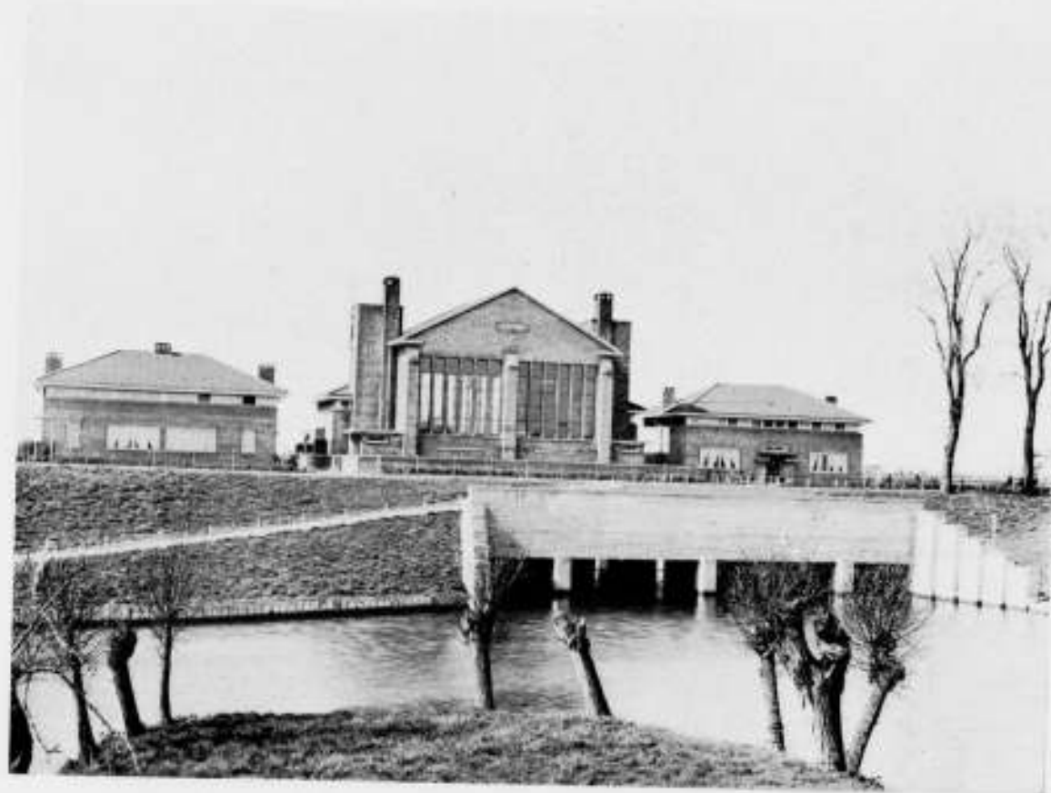
DIESELGEMAAL TE MAASSLUIS.
