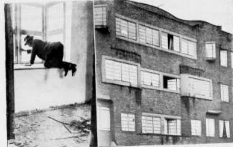
ERKER ZONDER UITZICHT. EEN VOORBEELD VAN SLECHTE ARCHITECTUUR MET INWATERENDE GEVELS.
