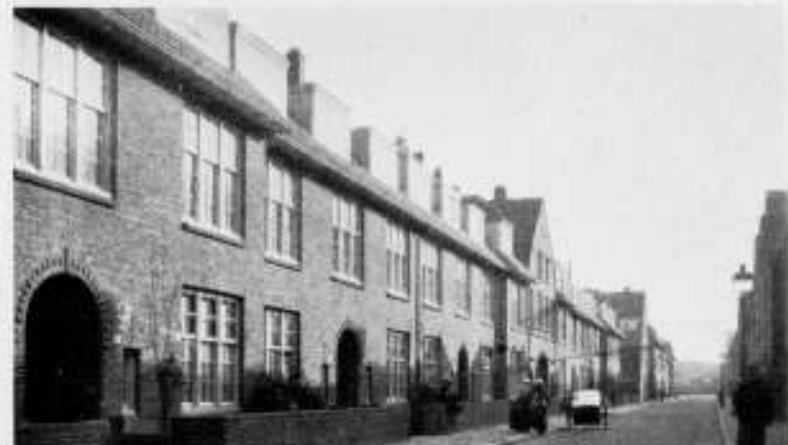
FIG. 50. STRAATBEELD IN OUD DUINDORP (ZEEZWALUWSTRAAT), het stadsbeeld wanneer straatprofielen, ruimteindeeling c.s. niet met alle mogelijke zorg zijn overwogen en het gevaar, dat daaruit in den opbouw volslagen willekeur en onoverwogen groepeerings ontstaat, wanneer niet te voren nauwkeurig zijn vastgesteld schema's van verkaveling en bebouwingssilhouetten, terwijl daarbij de middelen aanwezig zijn, die de naleving daarvan verzekeren voorzover door bekwame ontwerpers geen gelijkwaardige of betere afwijkingen worden voorgesteld. Bij de vorige opmerkingen en zeer duidelijk bij dit laatste bezwaar komt tot uiting het gevaar van beperking der welstandskeuring uitsluitend tot de gevels-aan-de-straat.
