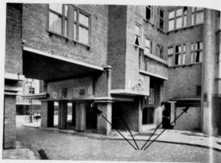
DEZE ARCADE-BOUW TOONT OP DE PLAATS WAAR HET PUBLIEK PASSEERT WEL GLASVLAKKEN, MAAR ZE ZIJN GEPLAATST OP P.L.M. 2 M. HOOGTE EN ZE ZIJN P.L.M. 50 CM. DIEP.
