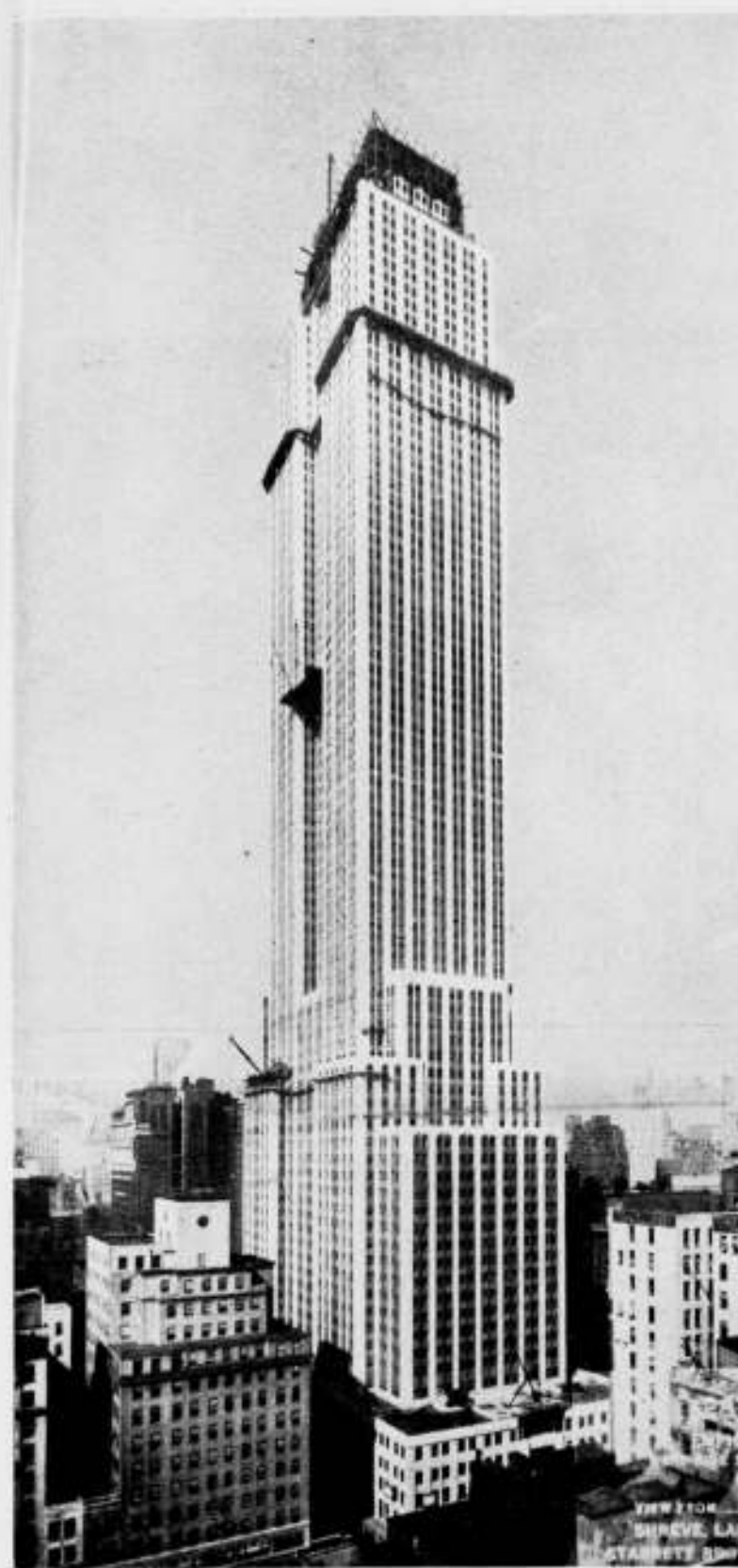
EMPIRE STATE BUILDING NEW-YORK. ARCH. SHREVE, LAMB EN HARMON. IN AANBOUW, VOLTOOID TOT DE 86e VERDIEPING
