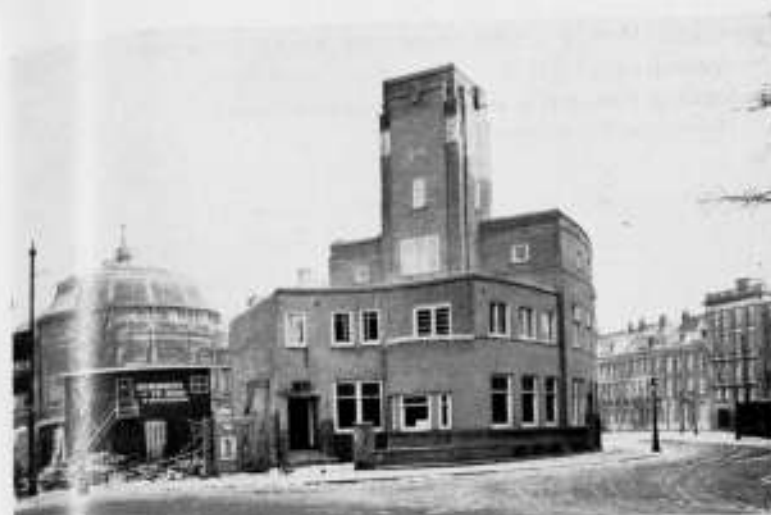
TERWILLE VAN DE ARCHITECTUUR VERMINKT HEERENHUIS DE SLAAPKAMERS IN DEN TOREN GEBOUWD IN PLAATS VAN OP DE VERDIEPING.
