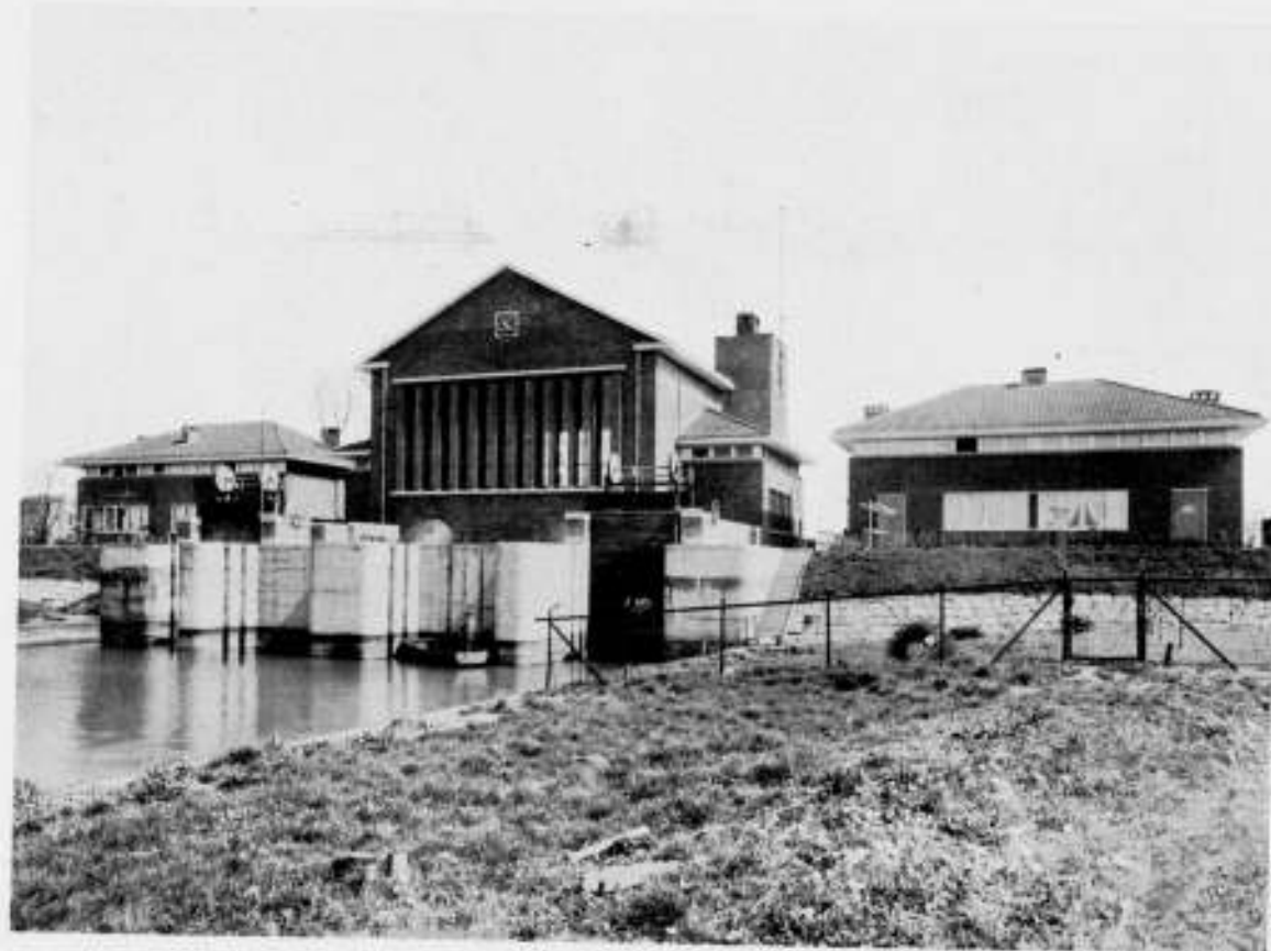
DIESELGEMAAL TE MAASSLUIS.
