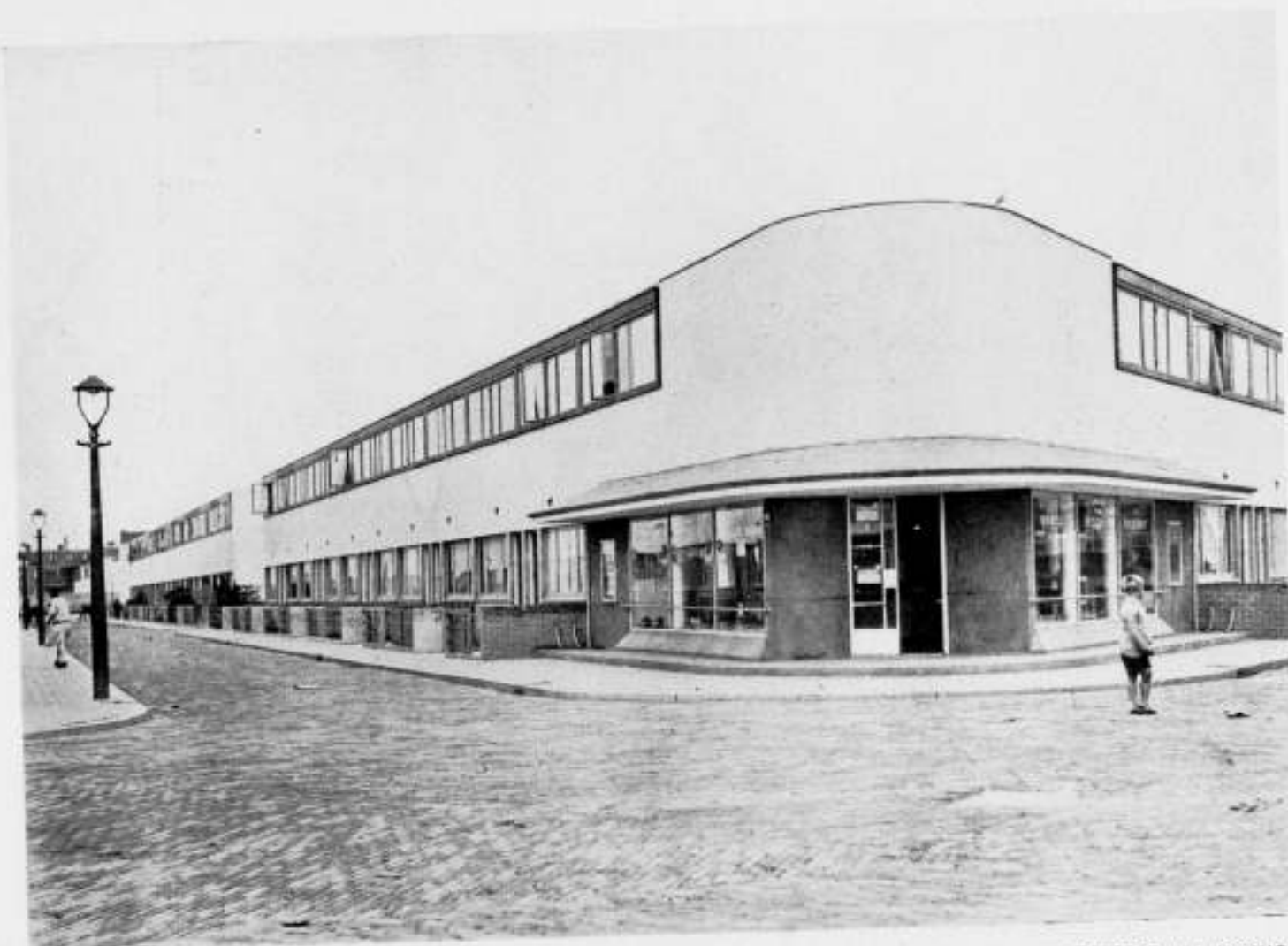
HEER ARNOLDSTRAAT IN HET COMPLEX „KIEFHOK” ROTTERDAM
