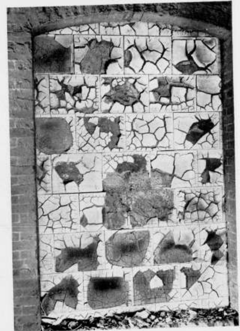
WAND VAN CELLENBETON NA DE PROEF.
