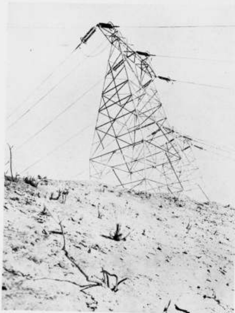
AMERIKA. STALEN VAKWERKMAST, IN DE MOJAVE WOESTIJN, TEN DIENSTE V.H. LEIDINGSNET TER VERBINDING V.H. STATION OP DE HOOGTE SIERRA MET DE Z. CALIFORNISCHE GEBRUIKSCENTRA.
