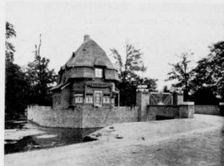
LANDHUIS „DE IPENHOF”. PORTIERSWONING.
