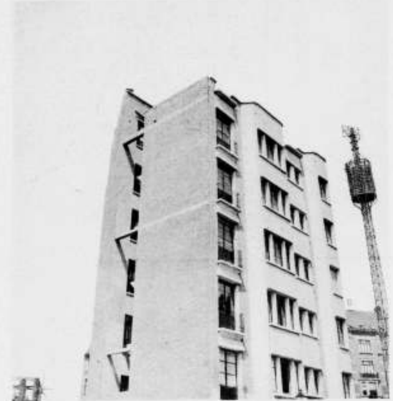
FLATGEBOUW MET BINNENPLAATS. AVENUE ALPHONSE RENARD.
