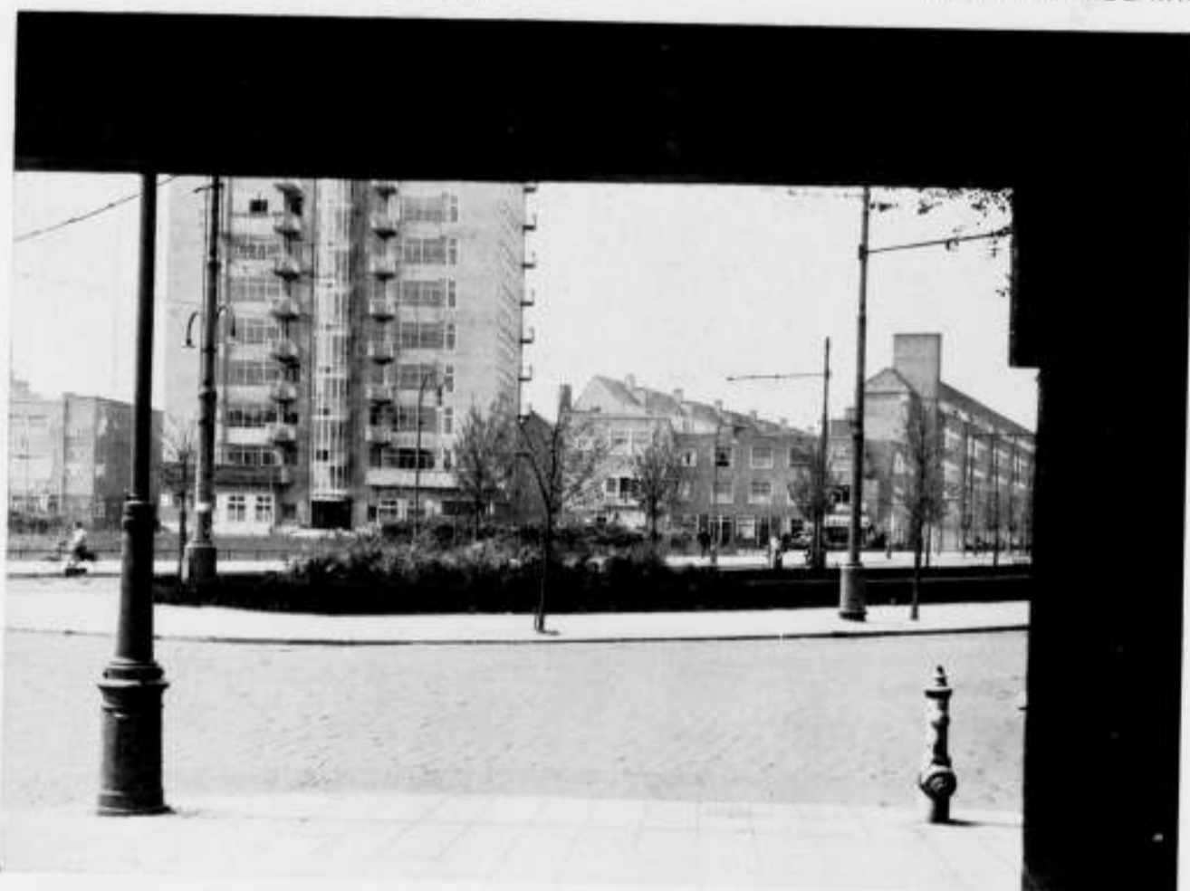
HOOGBOUW GEZIEN VAN ONDER DEN ARCADEBOUW UIT - HOEK RIJNSTAAT
