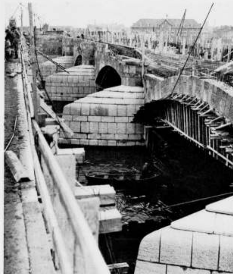
CONSTRUCTIE LAATSTEN BOOG STADSZIJDE, DECEMBER 1931.
