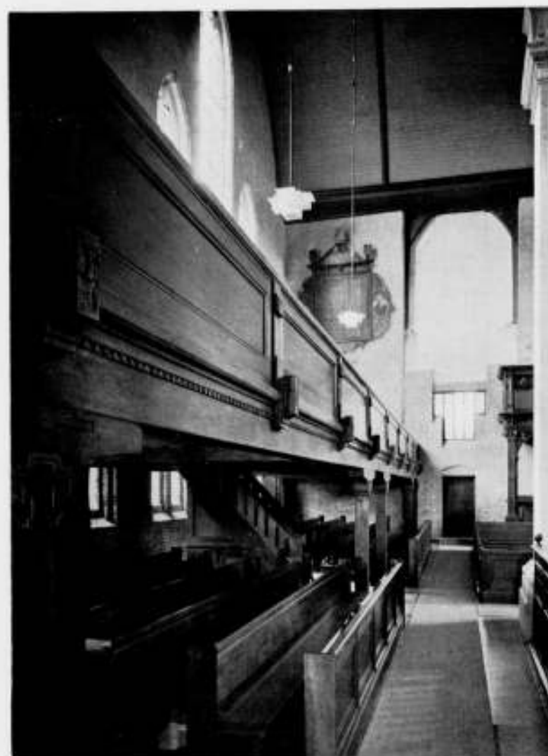
TRIBUNE. BEELDHOUWERK VAN TH. VOS RESTAURATIE VAN DE NED. HERVORMDE KERK TE SCHOONHOVEN
