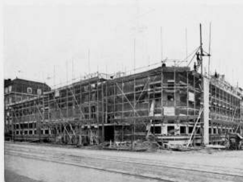
IJZEREN STEIGER ROND HET IN AANBOUW ZIJNDE LABORATORIUM VOOR DE VRIJE UNIVERSITEIT TE AMSTERDAM
