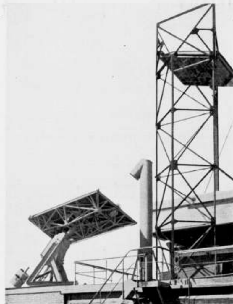
HELIOSTAAT EN REFLECTOR OP HET DAK
