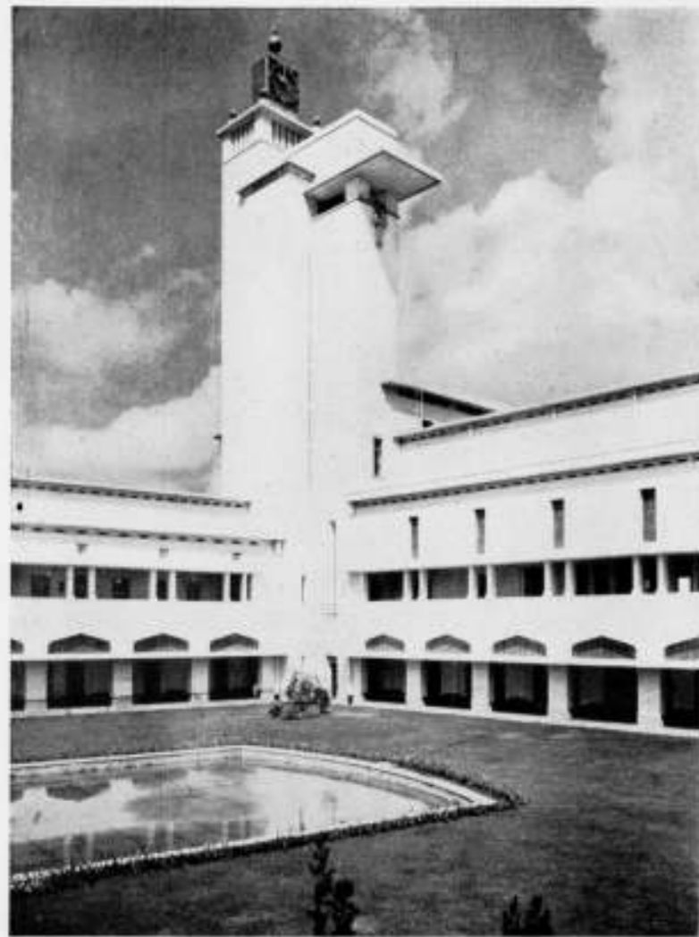
BINNENPLAATS GOUVERNEURSKANTOOR TE SOERABAIA ARCH. Ir. W. LEMEIJER
