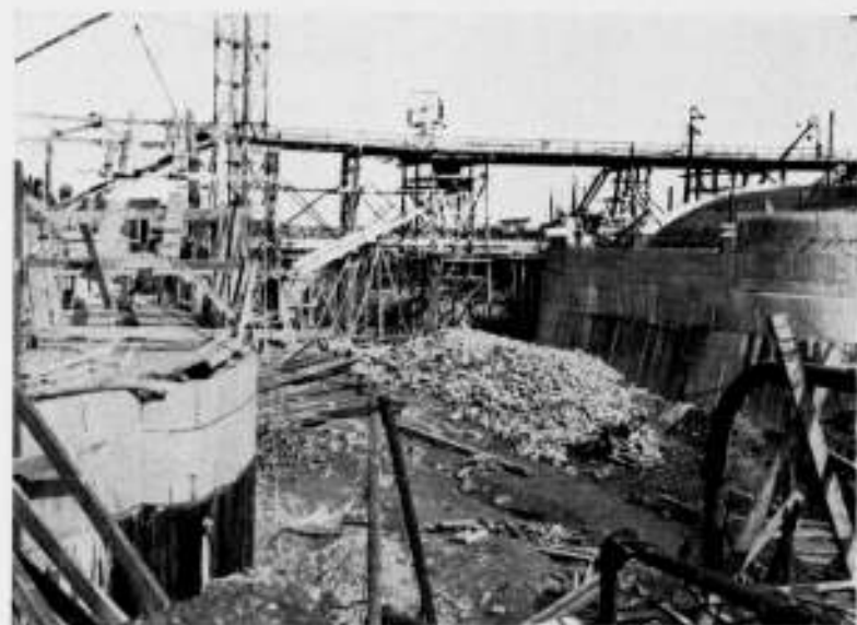
BOUWPUT LINKER LANDHOOFD NOVEMBER 1931
