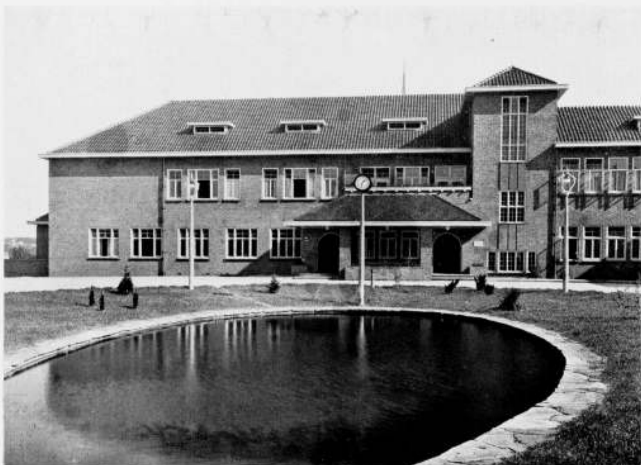
FRAGMENT VOORGEVEL ZIEKENHUIS
