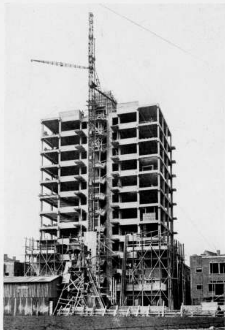
HET GEW. BETON FRAME VAN DEN HOOGBOUW OVER DE VOLLE HOOGTE, GEREED OP 16 APRIL 1931. DE HOUTEN VLOEREN ZIJN REEDS GELEGD, DE 4e, 8e EN DE PLATVERDIEPING ZIJN VAN GEW. BETON. OP DEZE FOTO'S TEVENS DE 60 M. HOOGTE HIJSCHTOREN MET DRAAIBAREN KRAANARM VAN 15 M., TIJDENS DEN OPBOUW GEBRUIKT
