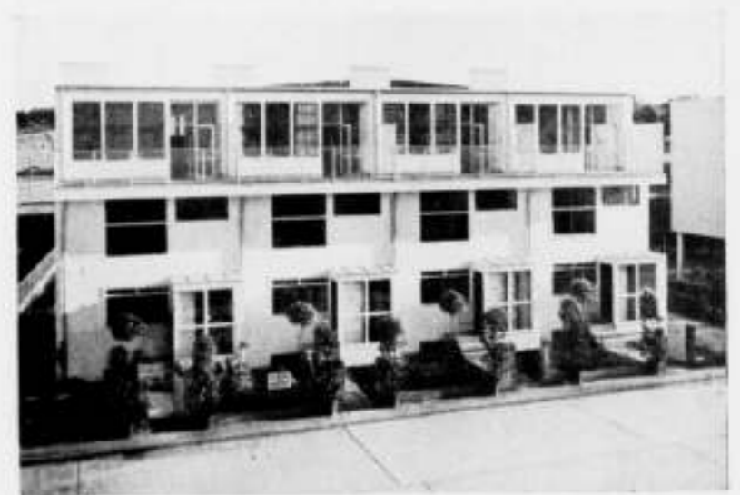
WOONHUIZEN IN DE WERKBUNDSIEDLUNG TE LAINZ ARCHITECT G. RIETVELD
