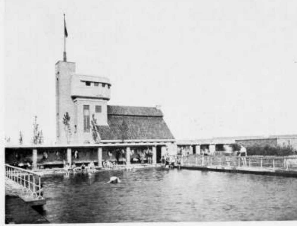
POMPGEBOUW DIENT PUBLIEKE WERKEN
