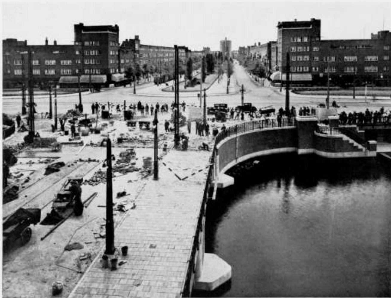
AMSTELLAAN GEZIEN VANAF DE BERLAGEBRUG
