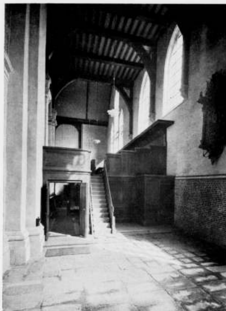
TOEGANG TOT KERKRUIM EN TRIBUNE RESTAURATIE NED. HERVORMDE KERK TE SCHOONHOVEN
