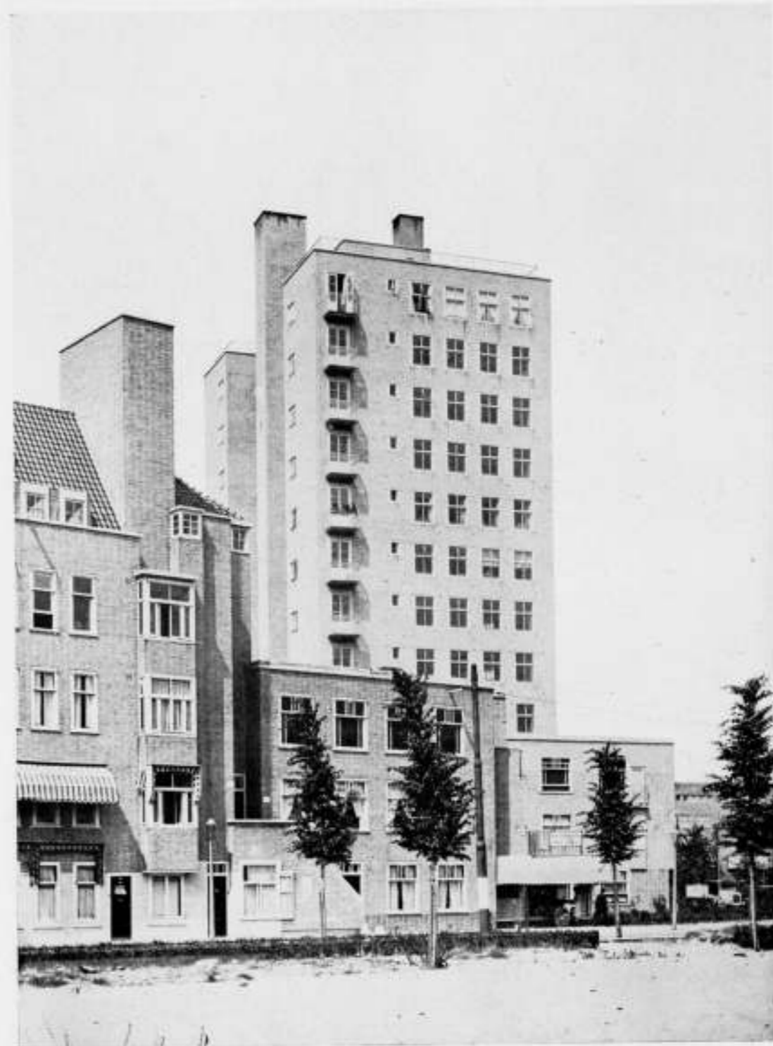
HOOGBOUW GEZIEN VANAF DE ZUIDER AMSTELLAAN
