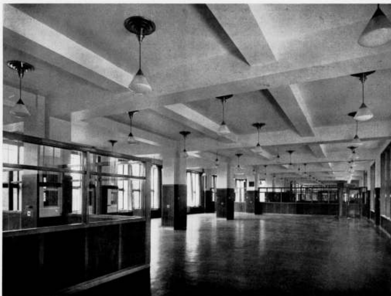
KANTOORRUIMTE. HOOFDGEBOUW AMSTERDAMSCHER BANK TE AMSTERDAM. ARCHITECTEN B. J. OUENDAG †, Dr. H. P. BERLAGE EN Ir. W. B. OUENDAG B.N.A. 435
