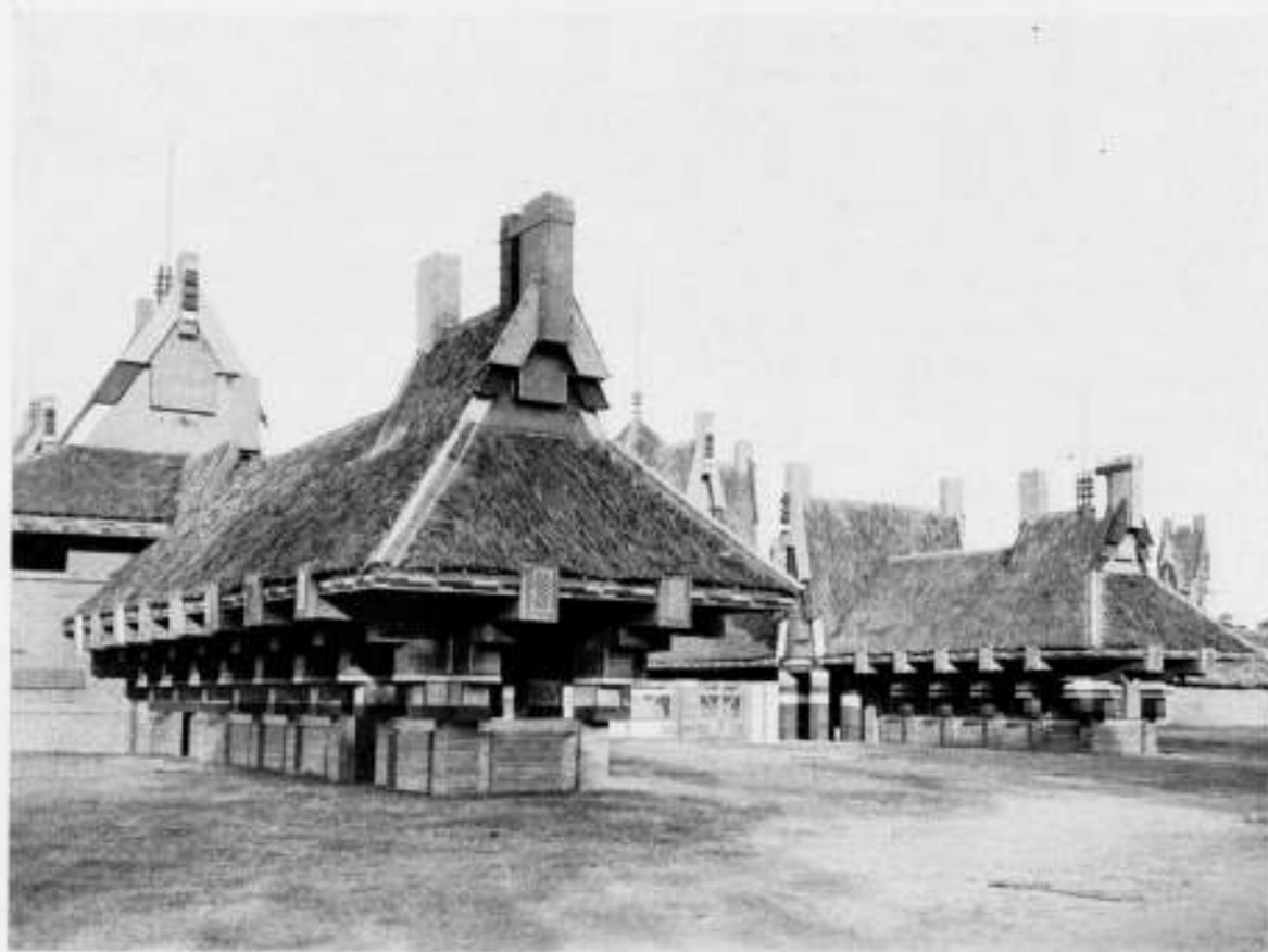
KAARTJESLOKETTEN EN WACHTLOKAALTE VERKEERSPOLITIE PASAR GAMBIR ARCHITECT J. H. ANTONISSE STADSARCHITECT VAN BATAVIA
