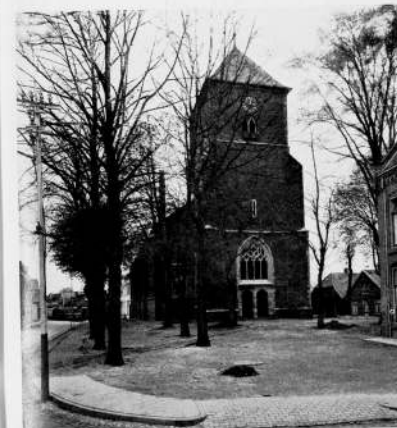
FIG. VII NIEUWE TOESTAND RESTAURATIE VAN DE N. HERV. KERK TE NEEDE ARCHITECT G. FEENSTRA B.N.A.
