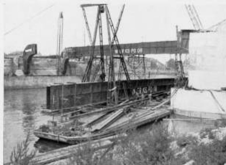
HET STELLEN VAN DE IJZEREN LIGGERS
