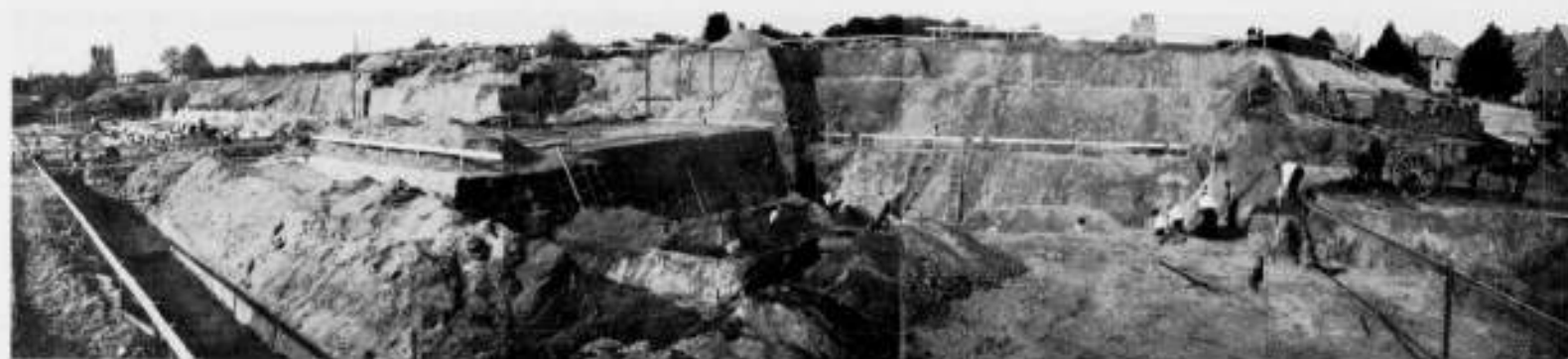
UITVOERING GRONDWERK VAN ZUSTERHUIS EN KETELHUIS DIACONNEN ZIEKENHUIS TE ARNHEM
