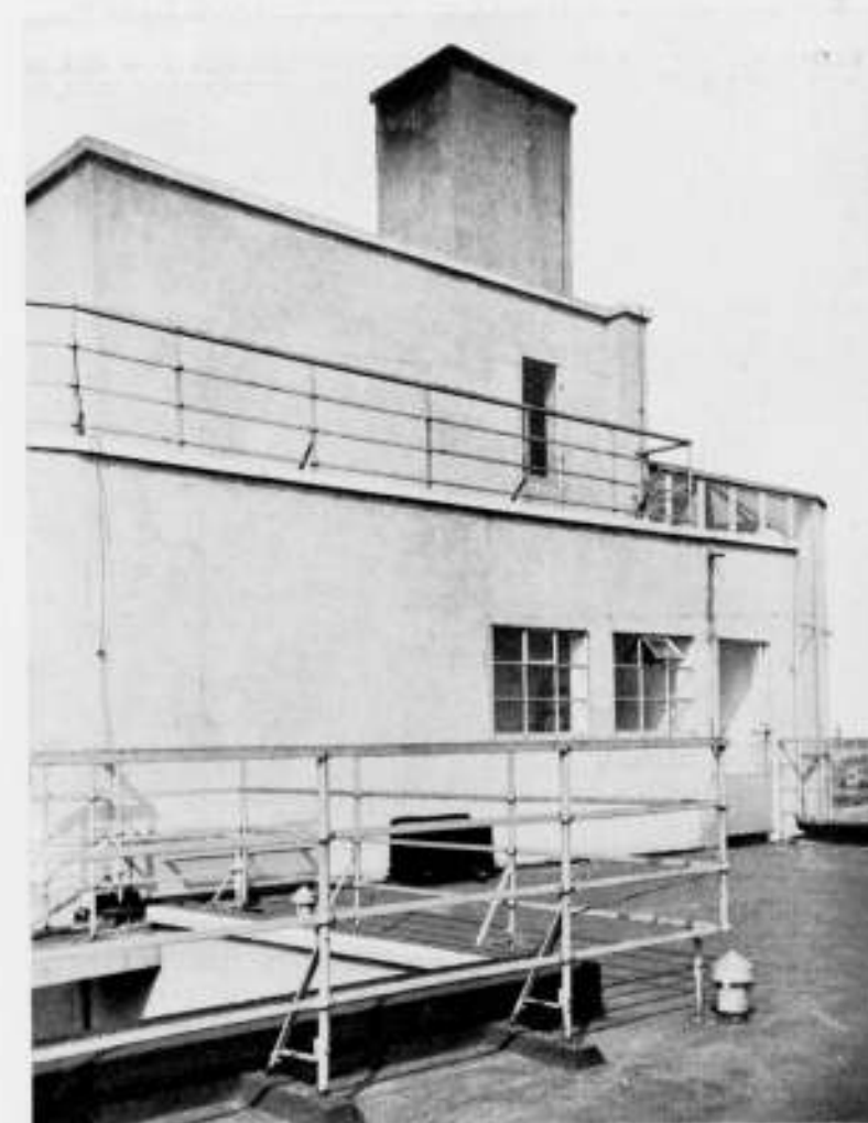
OP HET DAK VAN DEN HOOGBOUW. AFDEKKING PLAT MET BITUMEN. MEN ZIE SCHOORSTEEN DER WARMWATERVEROORZIENING
