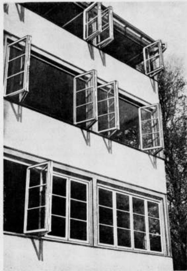
Wenn mehrere Flügel ohne festes Zwischenstück aneinanderstoßen, ist eine federnde Schiene zur Dichtung und zum Ausgleich von Ungenauigkeiten und Mäßeinheiten notwendig
