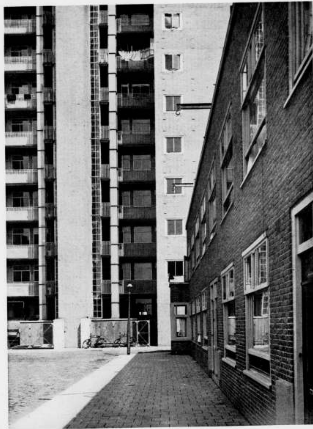
HOOGBOUW. ACHTERGEVEL MET VERWARMINGSSCHOORSTEEN EN VUILNISSTORTKOKERS ARCHITECT J. F. STAAL B. N. A.
