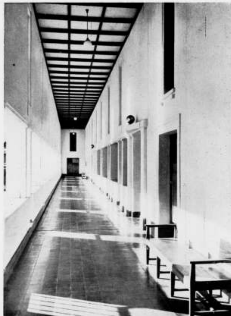
FRONTCORRIDOR OP DE VERDIEPING GOUVERNEURSKANTOOR TE SOERABAIA ARCH. Ir. W. LEMEIJER
