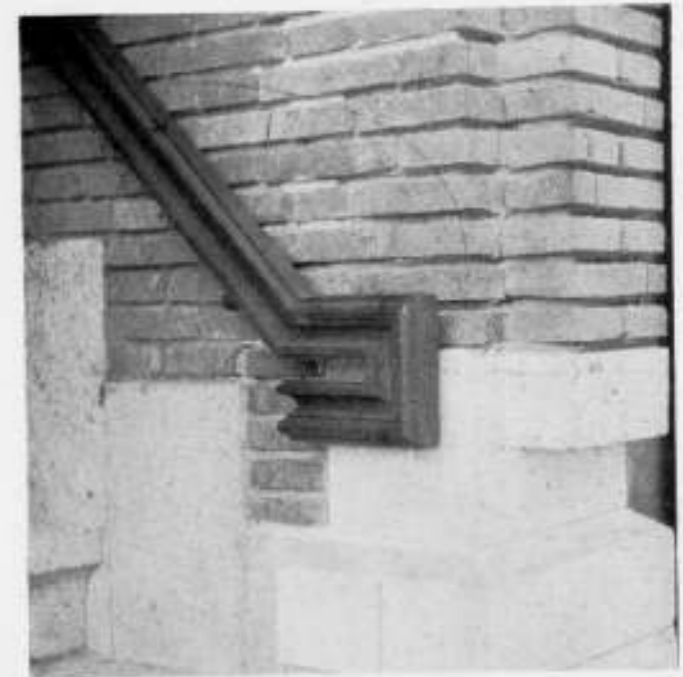
HIER IS HET EIND VAN WEG
