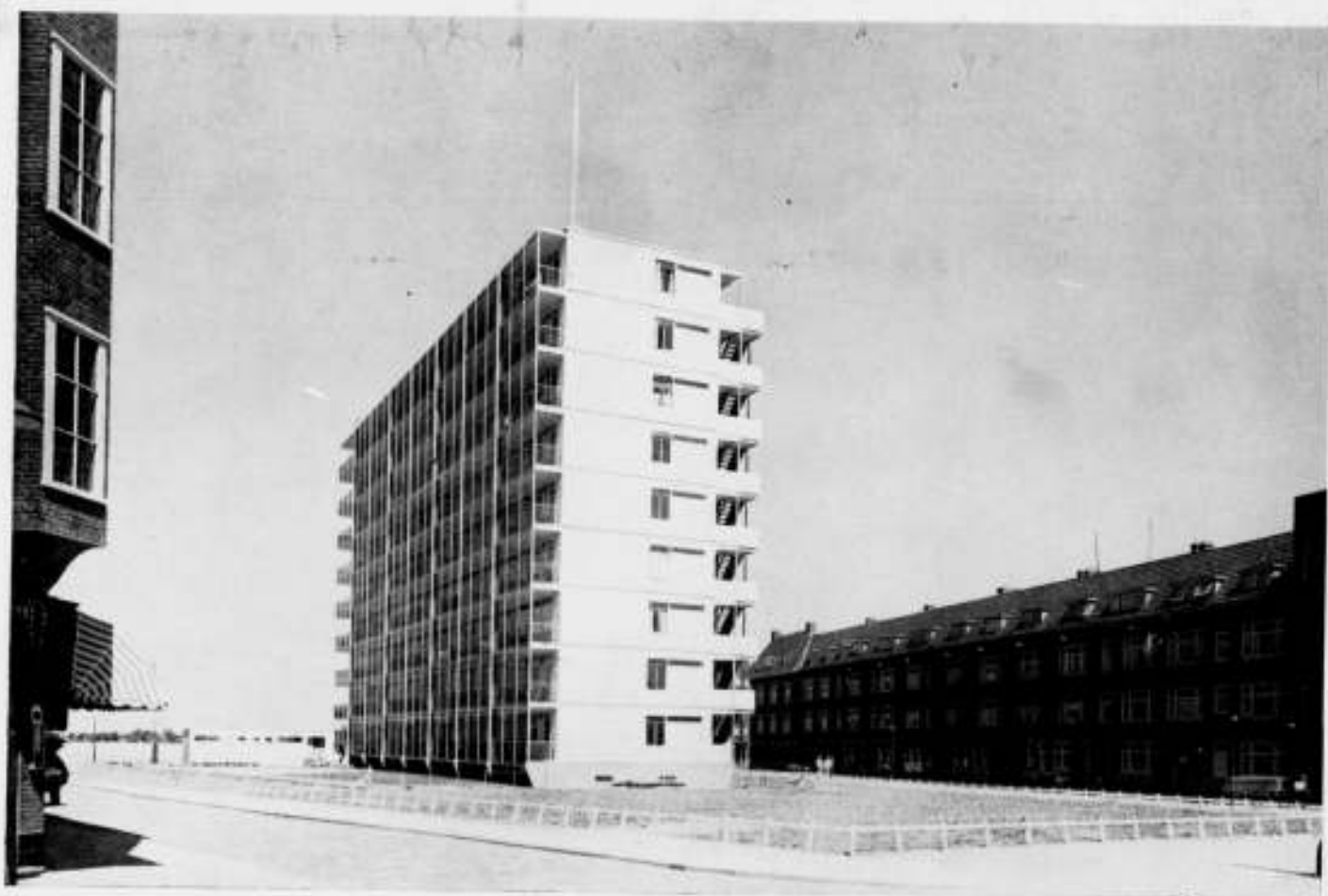
WOONGEBOUW BERGPOLDER TE ROTTERDAM. ARCHITECTEN Ir. W. VAN TIJEN, Ir. J. A. BRINKMAN EN L. C. v. d. VLUGT
