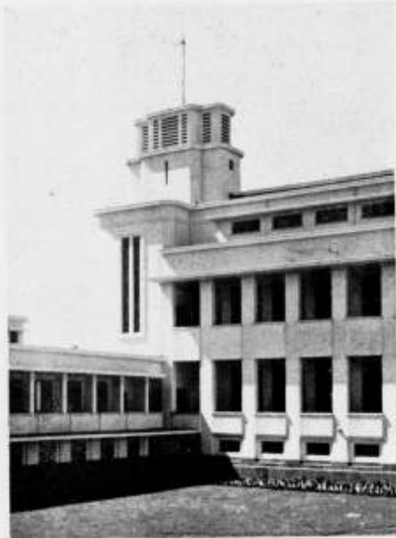
HOEK VAN DE BINNENPLAATS
