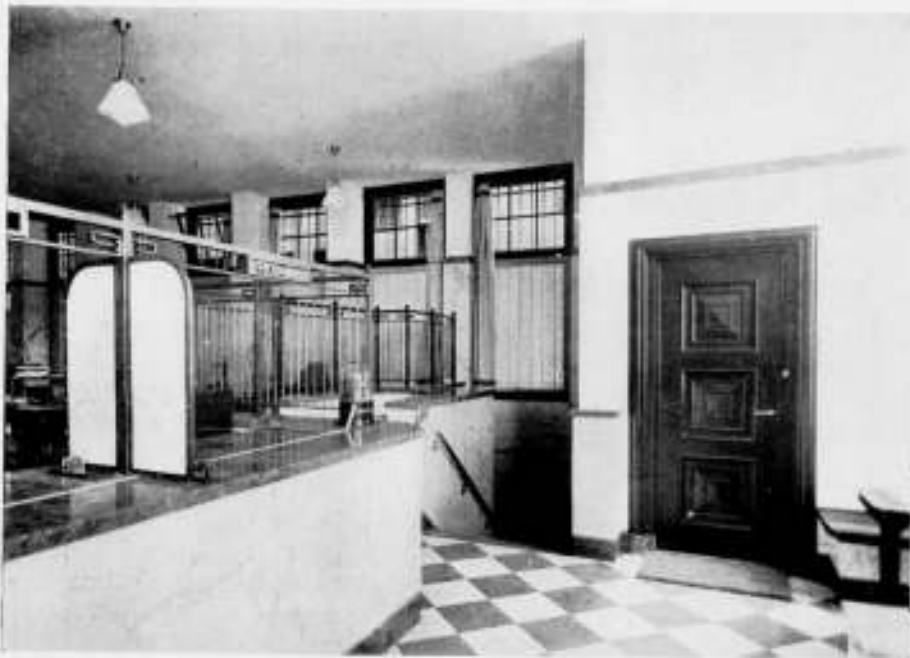
TOEGANG TOT DE Kelder-KLUIFAFDEELING
