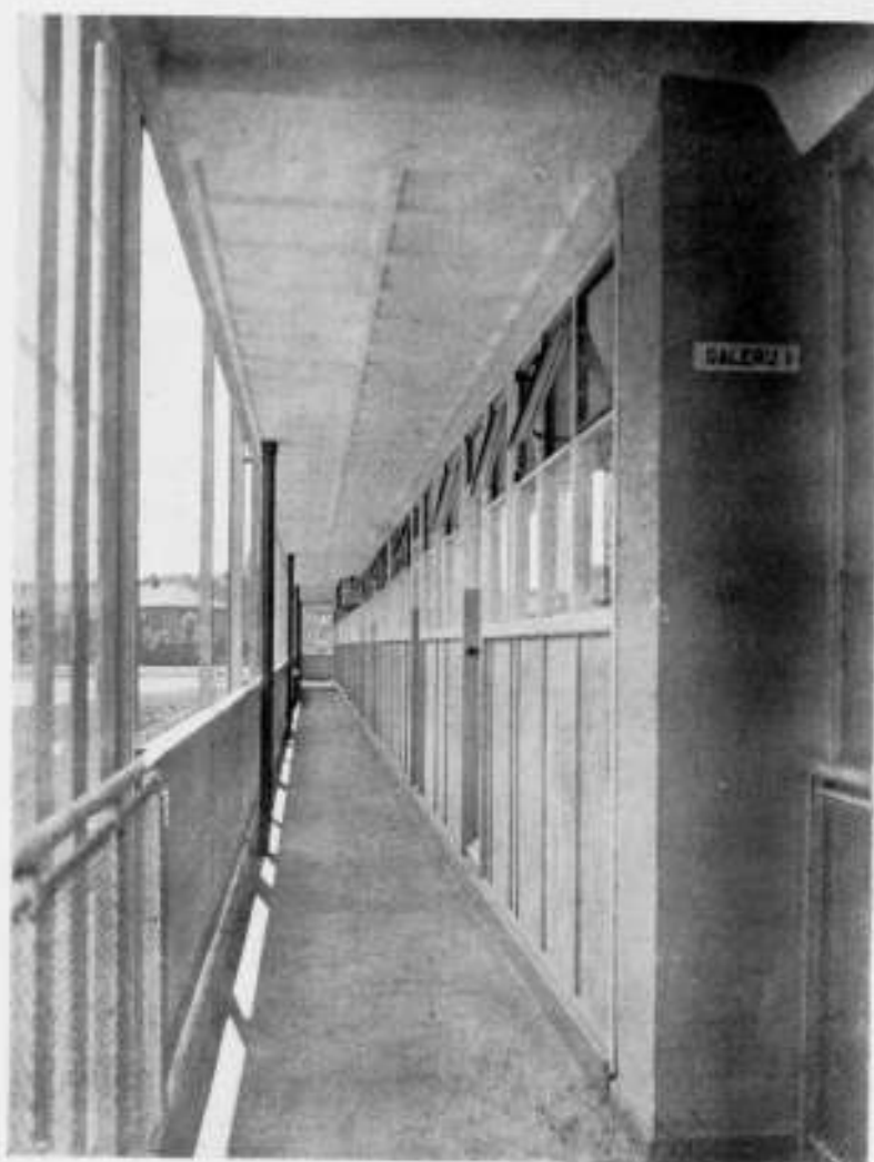
GEZICHT OP EEN DER GALERIJEN WOONGEBOUW BERGPOLDER TE ROTTERDAM
