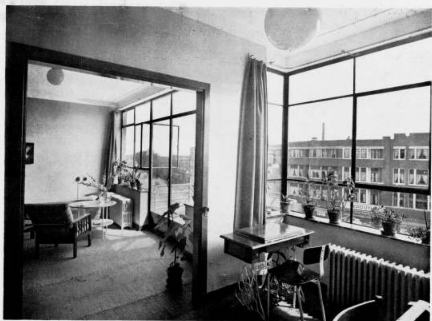
INTERIEURS IN HET WONINGBLOK TE SCHIEDAM
