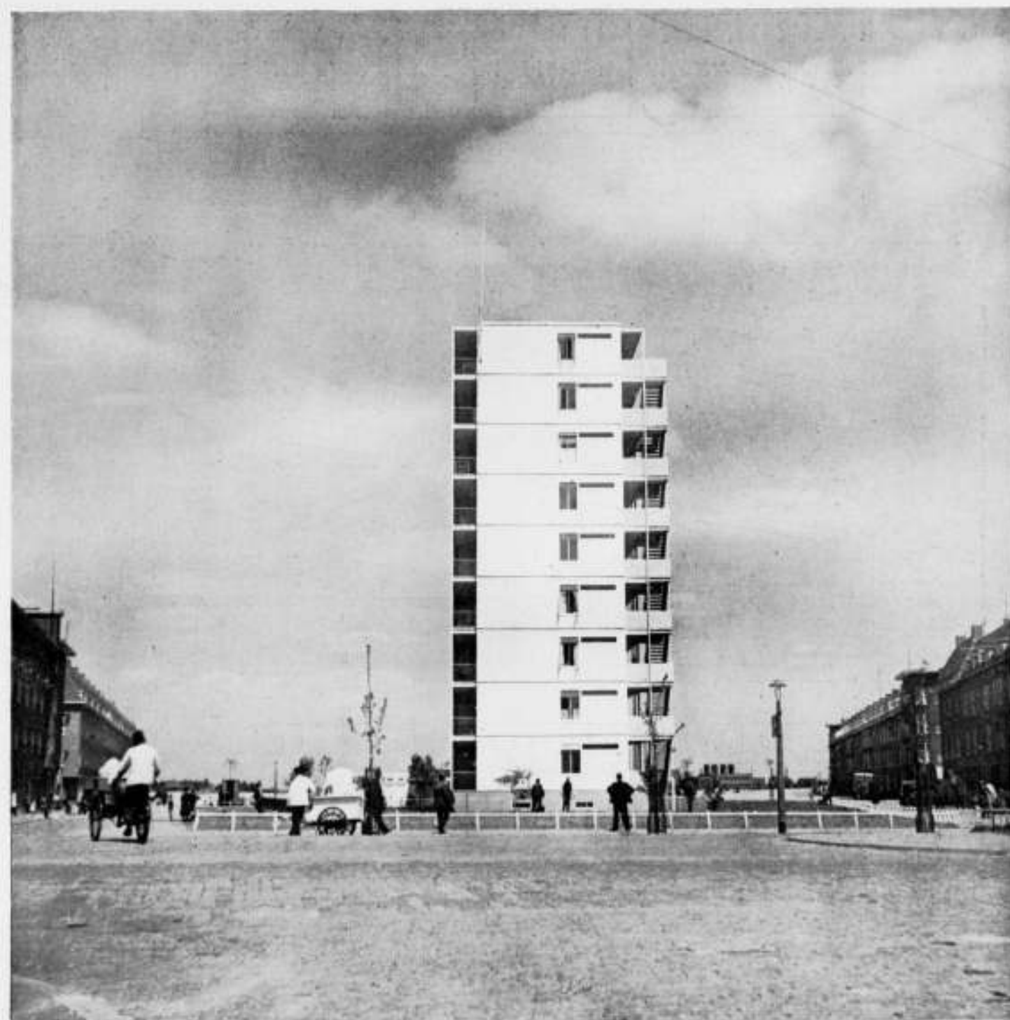
WOONGEBOUW BERGPOLDER TE ROTTERDAM ARCHITECTEN Ir. W. VAN TIJEN, Ir. J. A. BRINKMAN EN L. C. v. d. VLUGT
