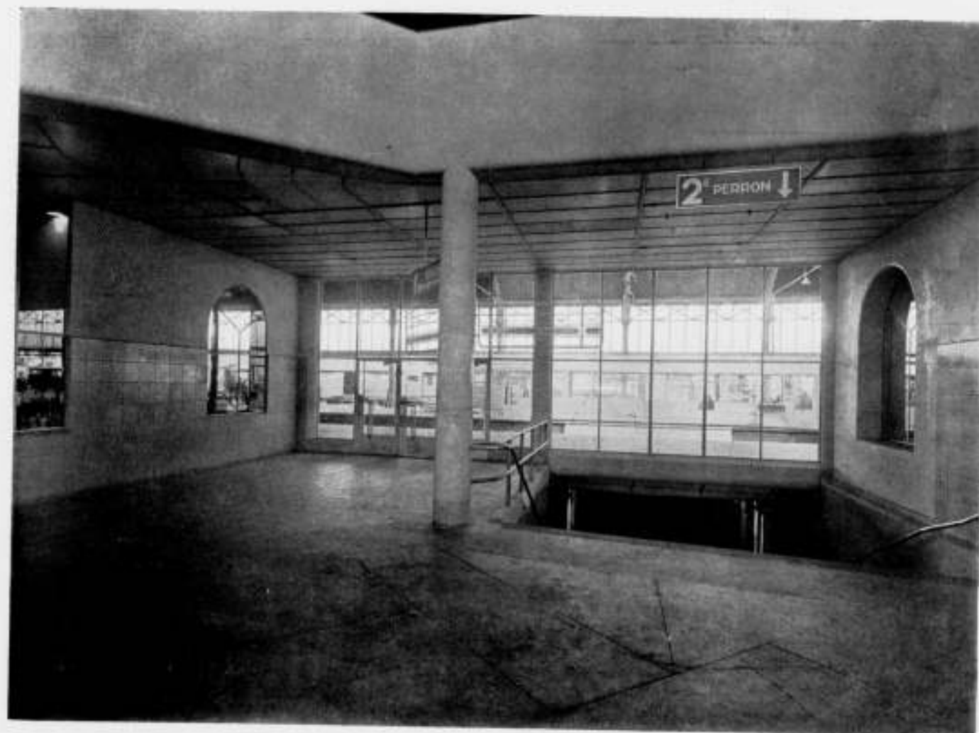
FIG. 5. ROTTERDAM-D.P. STATIONSHAL MET INGANG TUNNEL
