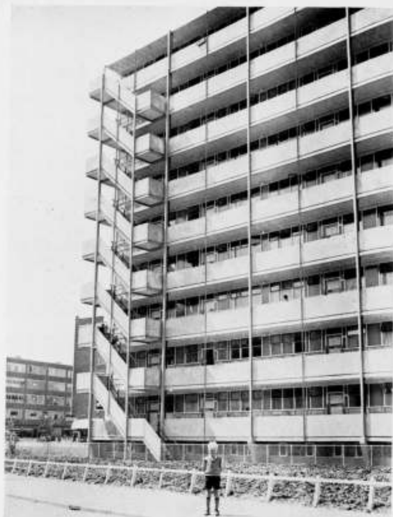
AANZICHT TEGEN DE GALERIJEN ARCHITECTEN I. W. VAN TIJEN, I. J. A. BRINKMAN EN L. C. v. d. VLUGT
