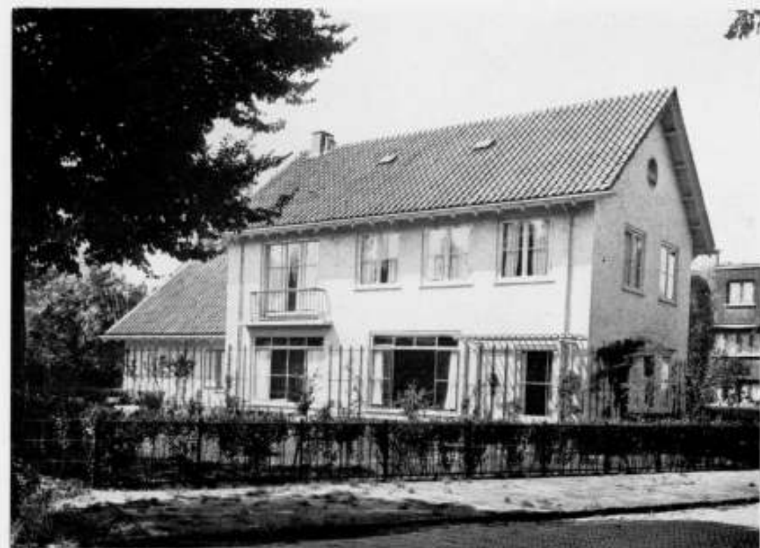
WOONHUIS EN ARCHITECTENBUREAU TE HAARLEM
