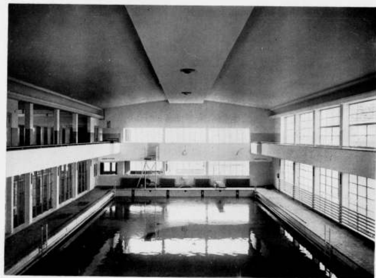
ZWEMZAAL IN HET NOORDERBAD TE GRONINGEN
