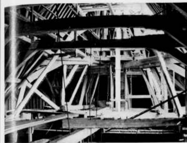
OUDE TOESTAND VIERINGSPANTEN EN ONDERSTEUNING VIERINGTOREN
