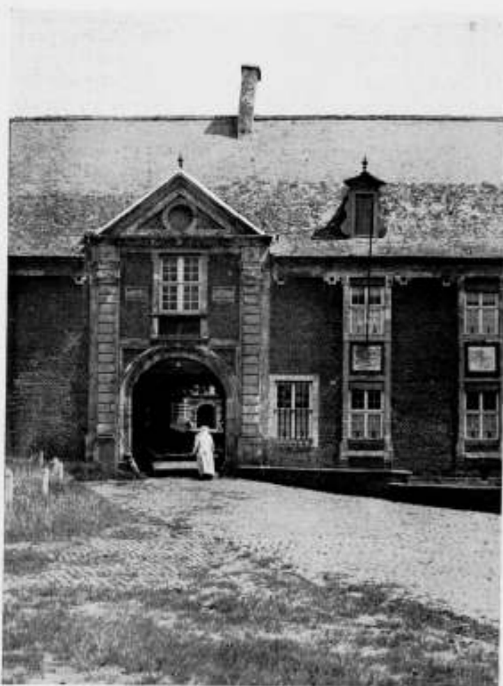
7. HOFZIJDE VAN DEN DOORGANG NAAR HET KLOOSTER
