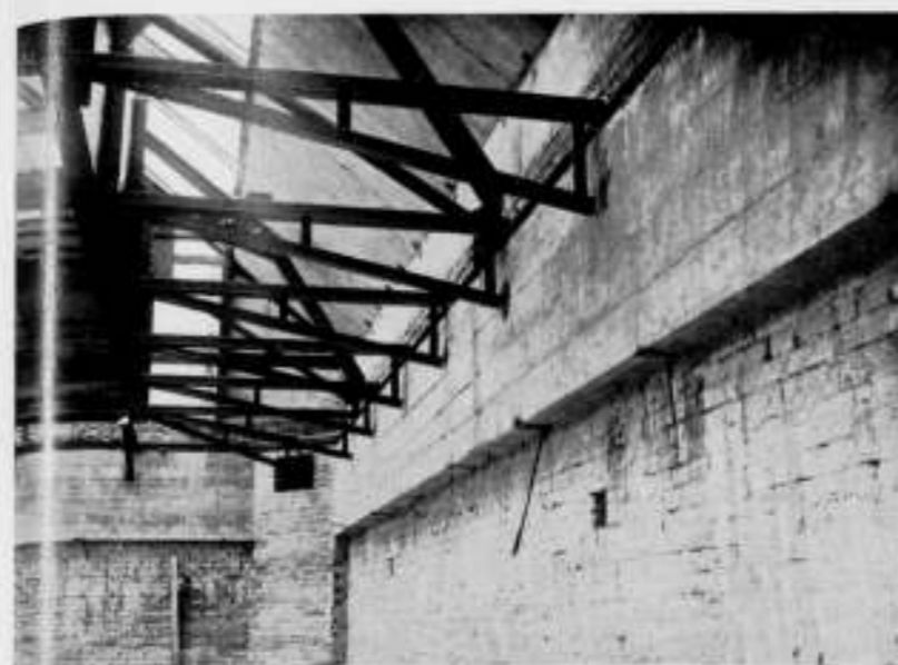
I. HET AANBRENGEN VAN EEN PANEL: DE IJZERCONSTRUCTIE.
