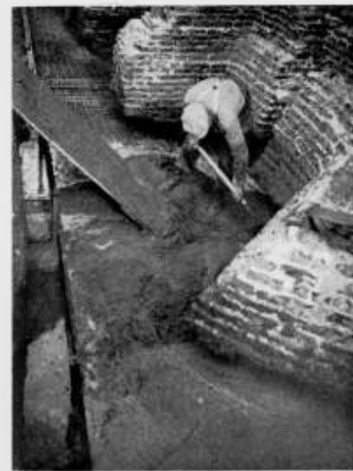
HET STORTEN VAN DE BETONPLAAT LANGS EN ONDER DEN NOORDERSCHIPMUUR
