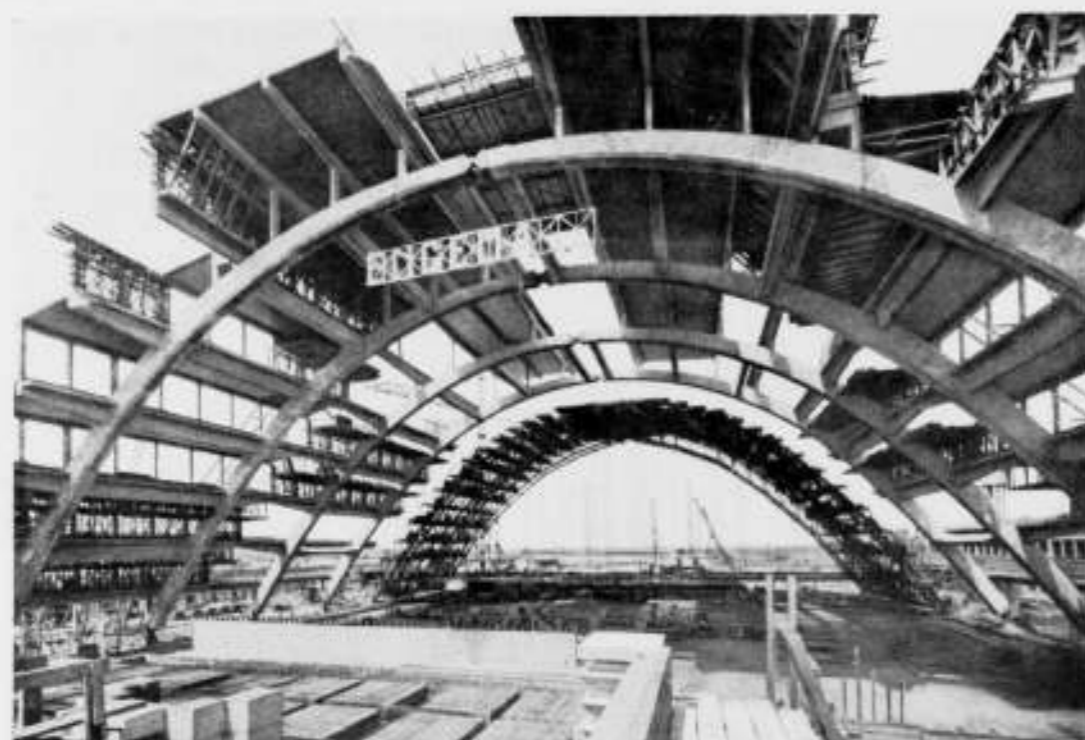
FIG. 11. GEWAPEND BETON SPANTEN. DAARACHTER HET IJZEREN FORMEEL
