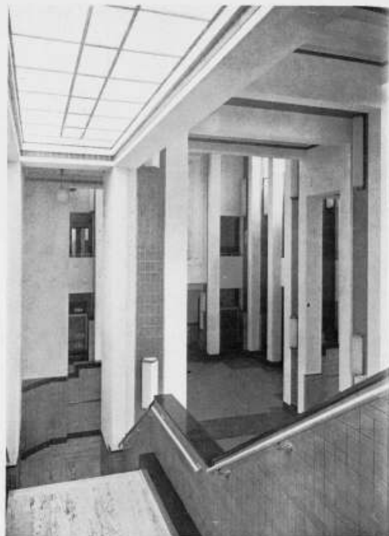
HAL EN HOOFDTRAP VAN EERSTE ÉTAGE AF GEZIEN
