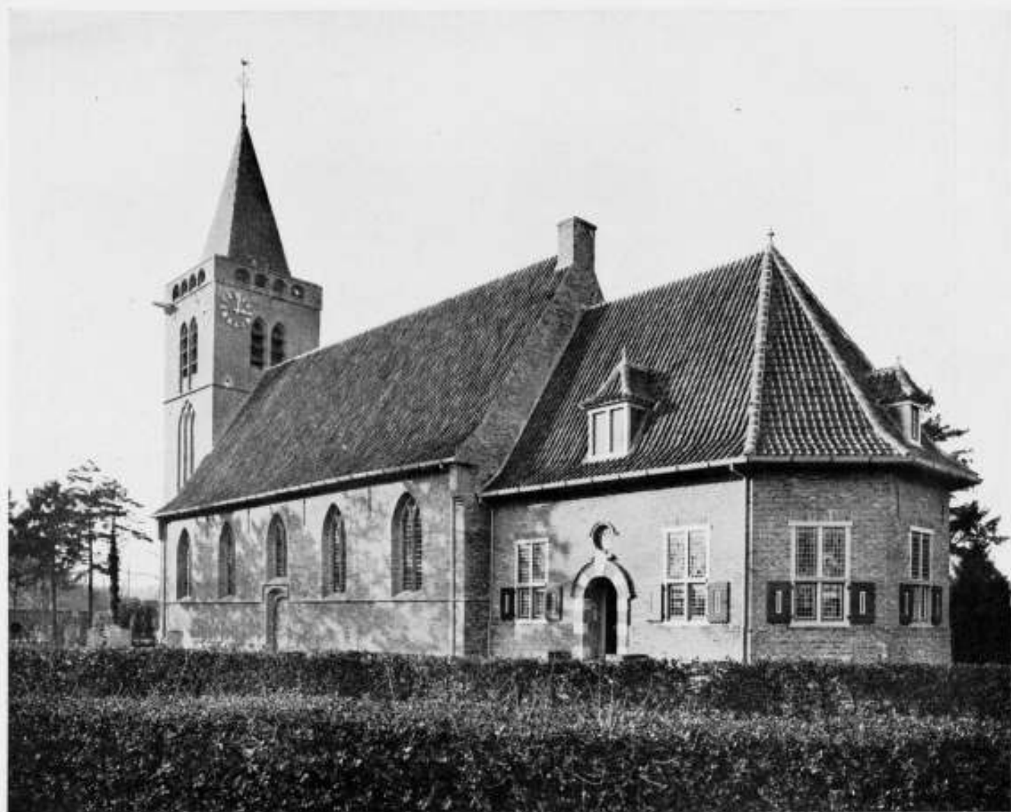
GERESTAUREERDE KERK DER NED. HERVORMDE GEMEENTE TE BLARICUM (N.H.) ARCHITECT VAN DE RESTAURATIE THEO RUETER
