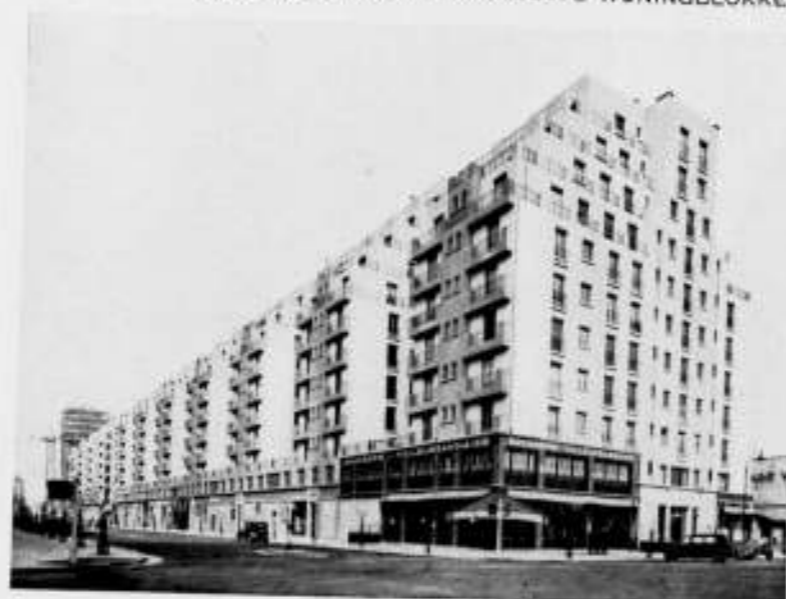
TWEE WONINGBLOKKEN AAN DE AVENUE DE L'HOTEL DE VILLE.
