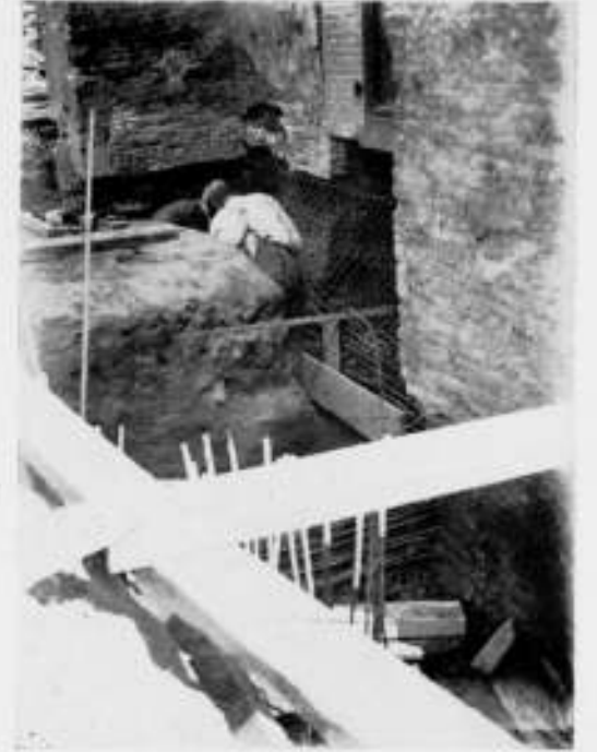
BETONVERSTERKING VAN HET TORENFUNDAMENT AAN DE WESTZIJDE
