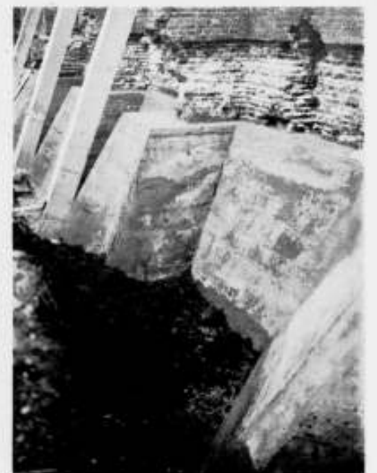
BETONVERSTERKING VAN DE FUNDEERING NOORDERSCHIPMUUR
