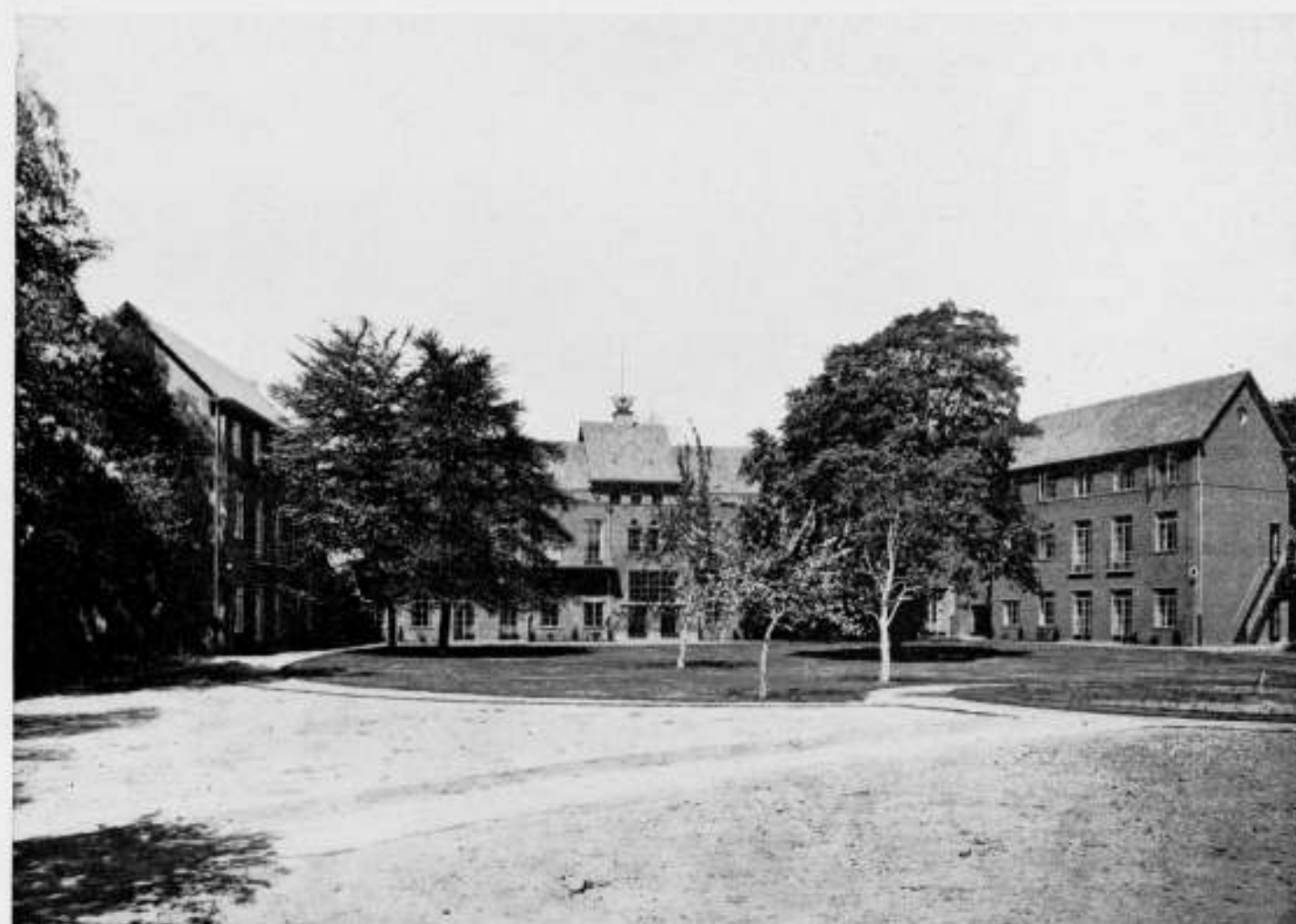
ACHTERGEVEL „VREEDENHOFF" TEHUIS VOOR OUDEN VAN DAGEN TE ARNHEM ARCHITECT W. J. GERRETSEN B.N.A.
