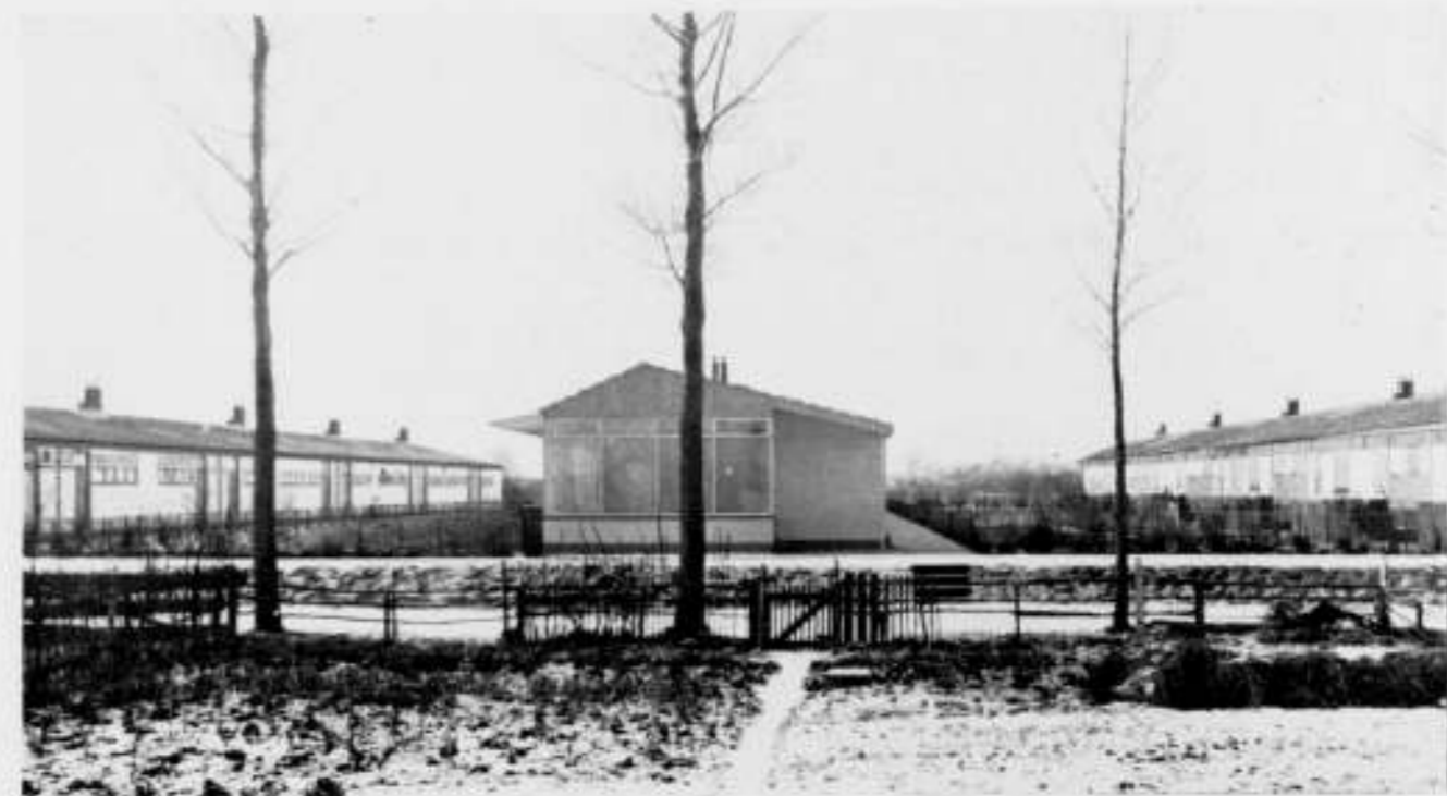
WONINGBOUW „DE POL” TE ZUTPHEN
