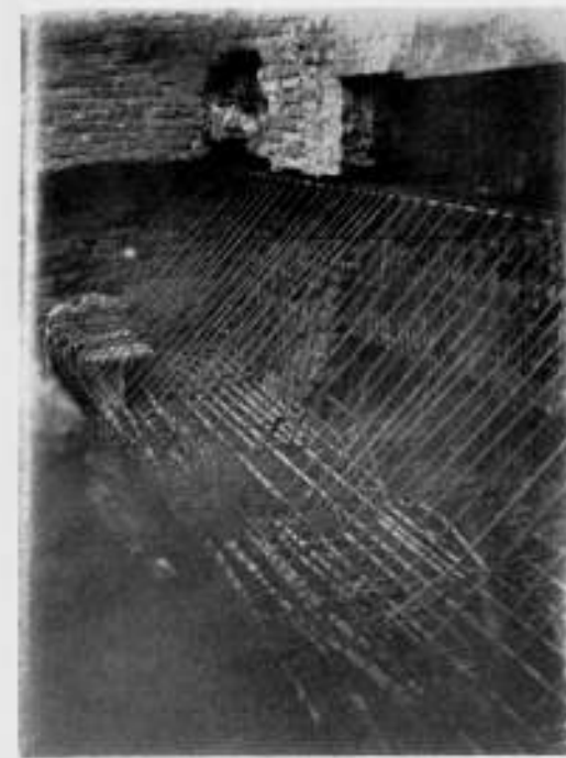
WAPENING VAN DE BETONVERSTERKING VAN HET TORENFUNDAMENT AAN DE WESTZIJDE VAN DEN TOREN
