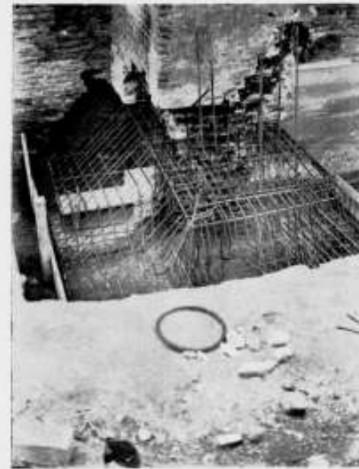
BETONVERSTERKING VAN HET TORENFUNDAMENT AAN DE WESTZIJDE OP 10 BETONPALEN, IEDER LANG 20 M.
