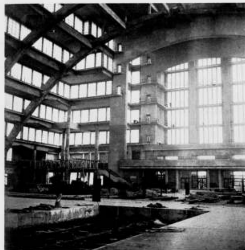
FIG. 3. GEZICHT TEGEN DEN VOORBOUW
