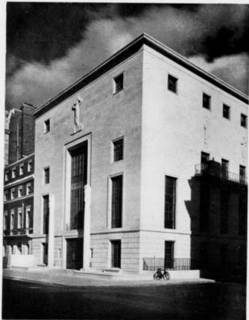
VOORGEVEL EN INGANGSPARTIJ VAN HET NIEUWE GEBOUW VAN HET R.I.B.A.
