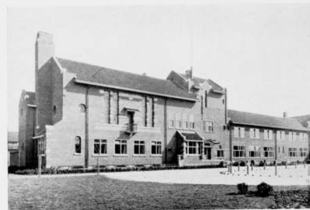
RAADHUIS TE ZWIJNDRECHT. ARCHITECTENBUREAU GRANPRÉ MOLIÈRE, VER- HAGEN EN KOK TE ROTTERDAM
