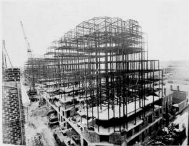
WONINGBLOKKEN IN AANBOUW
