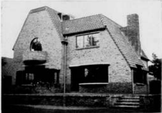
IX. Platte daken zijn in strijd met de dogmatiek van de landelijke architectuur: een borstwering als schijnkap is echter een toelaatbaar — en toegelaten — compromis.
