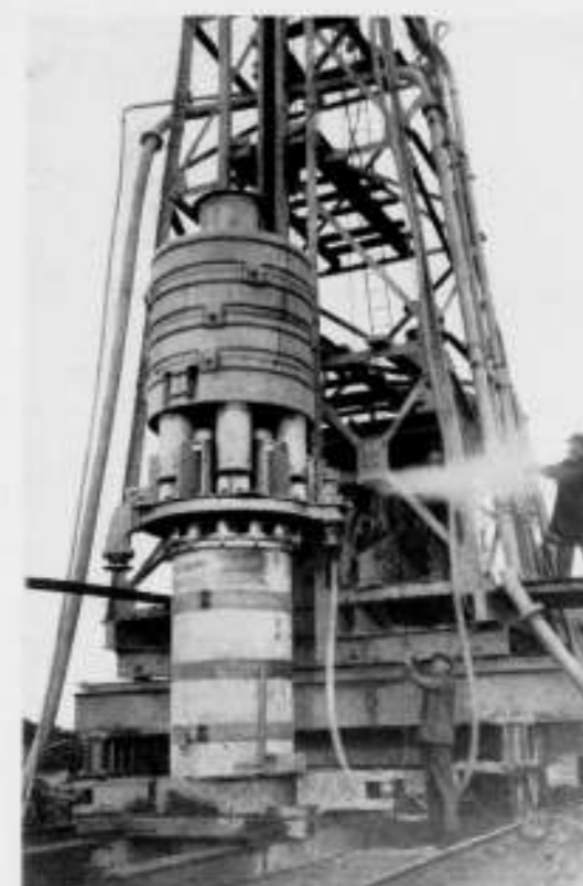
FIG. 15. UITSCHIETEN GROND BIJ ROTINOFF-CAISSON.
