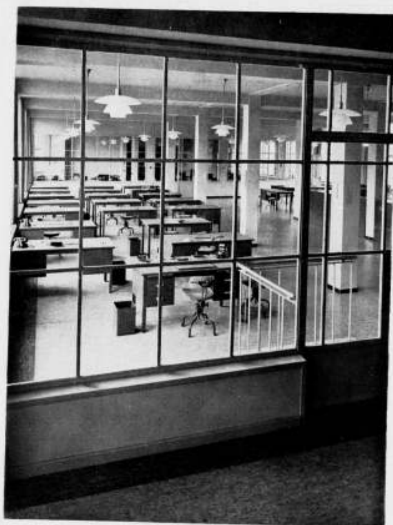
KANTOORLOKAAL GEZIEN UIT CHEFKAMER AFDEELING STROOMVERKOOP.
