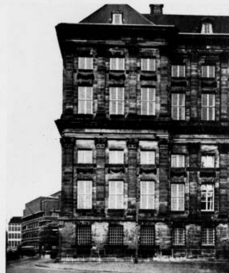
FIG. 5. HOEKRISALIJET NA DE RESTAURATIE.
