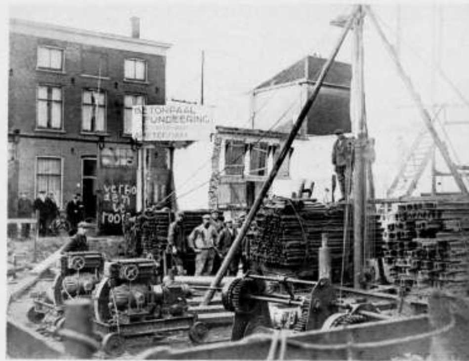
FIG. 12. IN DEN GROND BRENGEN VAN EEN „DE WAAL“ PAAL.
