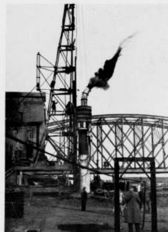
FIG. 14. HEI-INSTALLATIE ROTINOFF-CAISSON.
