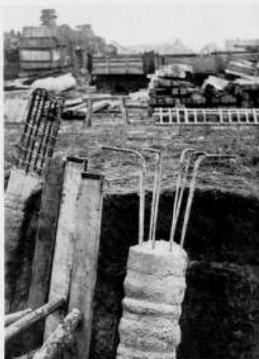
FIG. 18. ONTGRAVEN FRANKI-PAAL.
