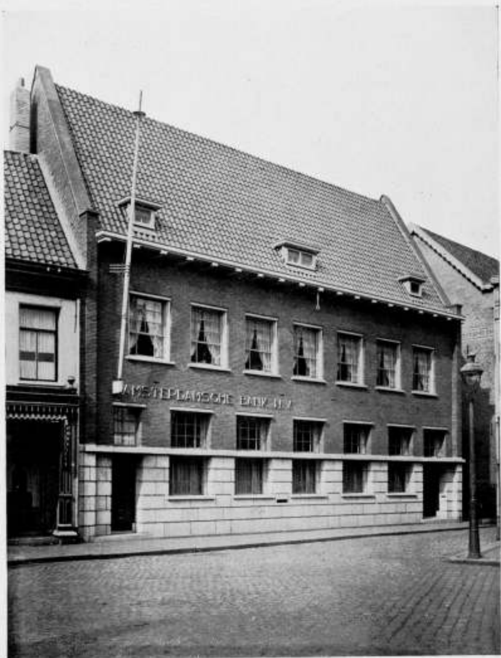
BIJKANTOOR DER AMSTERDAMSCHER BANK N.V. TE ROOSENDAAL. ARCHITECTENBUREAU: POSTHUMUS MEYJES EN V. D. LINDEN. ONTWERP EN BOUWLEIDING: C. B. POSTHUMUS MEYJES, B.N.A.
