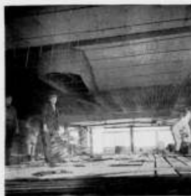
ISOLATIEPLATEN, RIBBEN-STREKMETAAL EN TUSSENSCHOTTEN, VOORBEELD VAN MONTAGE.
