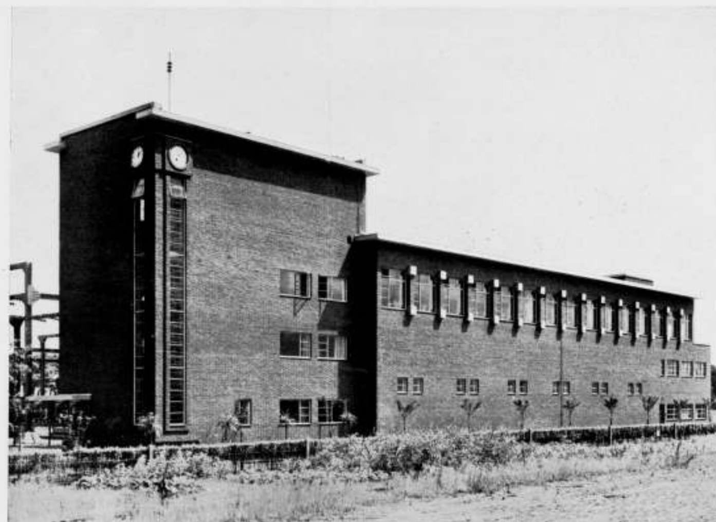
MAGAZIJN EN ADMINISTRATIEGEBOUW.
