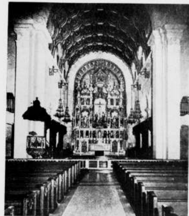
FIG. 4. INTERIEUR VAN EEN KATHOLIEKE KERK TE LOS-ANGELOS, 1500 ZITPLAATSEN, PLAFOND, MUREN VOORZIEN VAN ACOUSTISCH PLEISTERWERK.
