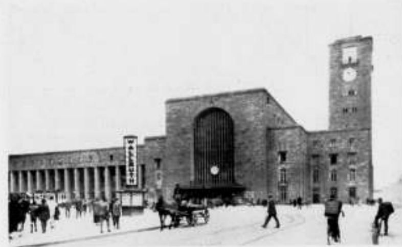
NATIONALE PRIJSVRAAG VOOR HET HOOFDSTATION TE STUTTGART. BEKROOND ONTWERP: ARCHITECTEN BONATZ EN SCHOLER.
