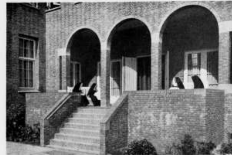
GEDEELTE ZUIDGEVEL VAN HET ZUSTERHUIS.
