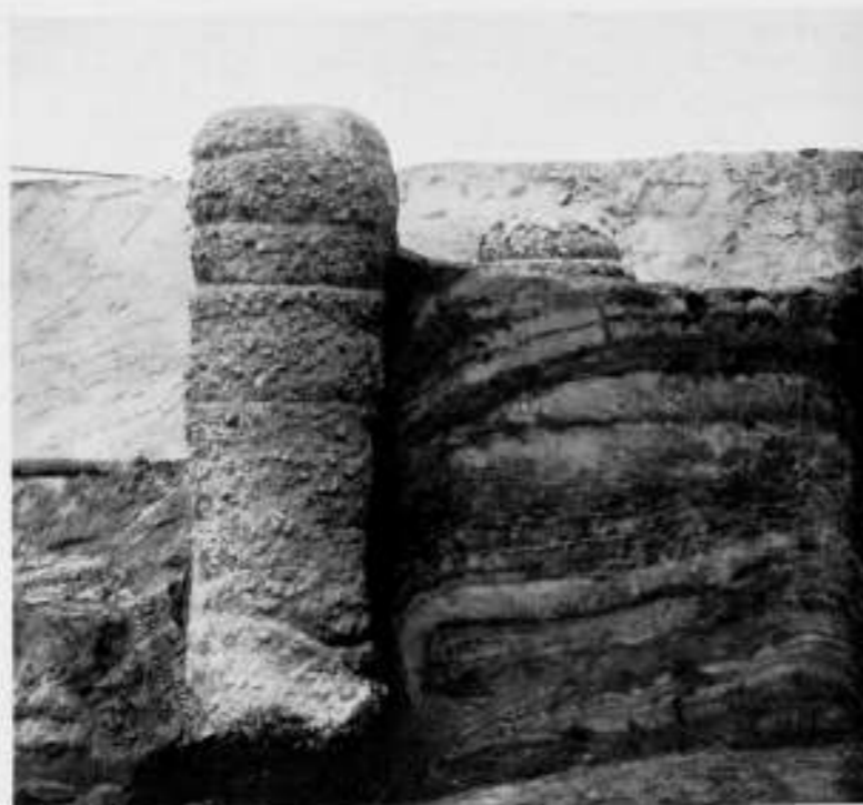
FIG. 19. BODEMVERDICHING NAAST EEN FRANKI-PAAL.
