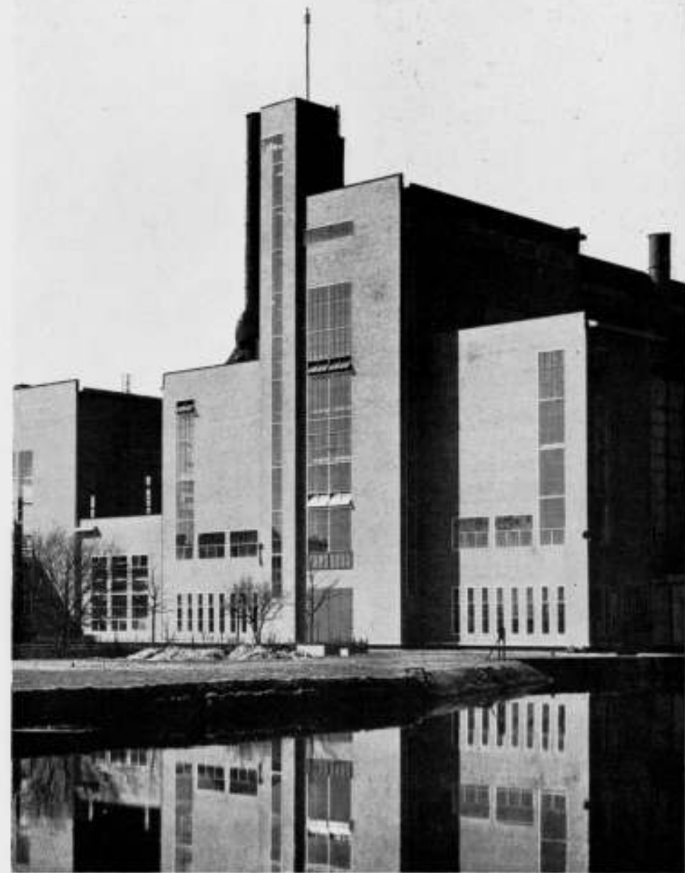
MACHINE-POMPEN-KETEL HUIS. OOSTHOEK OVER WINSCHOTERDIEP. ARCHITECT IR. A. H. VAN ROOD B.N.A.
