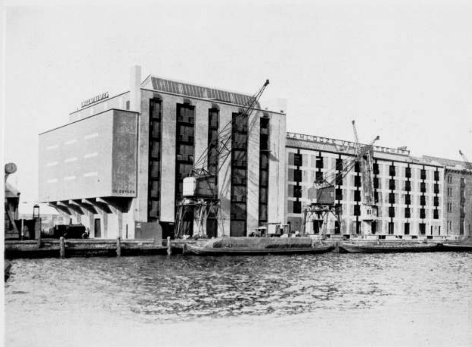
NOORDGEVEL VAN HET PAKHUIS DE ZWYGER AAN DE HANDELSKADE, A'DAM ARCH. IR. K. BAKKER EN IR. J. DE BIE LEUVELING TJEENK
