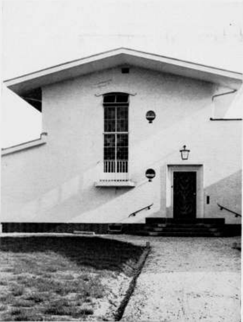
DIRECTEURSWONING. NIEUWTEHUIS DER PRINS HENDRIK-STICHTING TE EGMOND AAN ZEE. ARCH. CORN. ELFFERS B.N.A.
