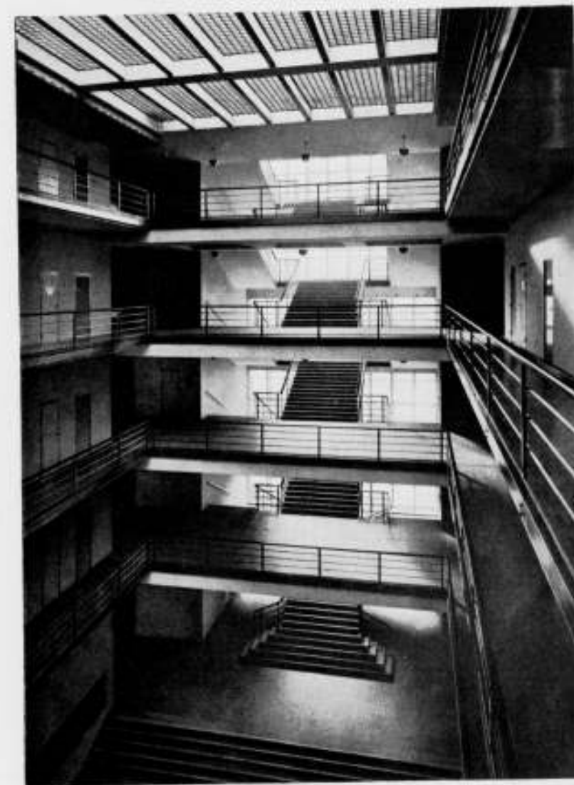
TRAPHAL GEBOUW VOOR HET ELECTRICITEITSBEDRIJF 171
