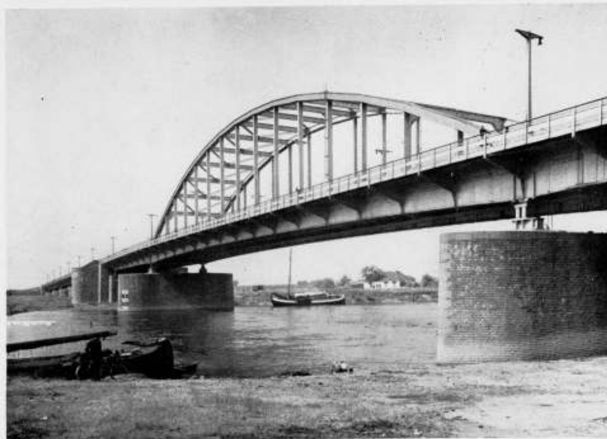
VERKEERSBRUG OVER DEN RIJN TE ARNHEM
