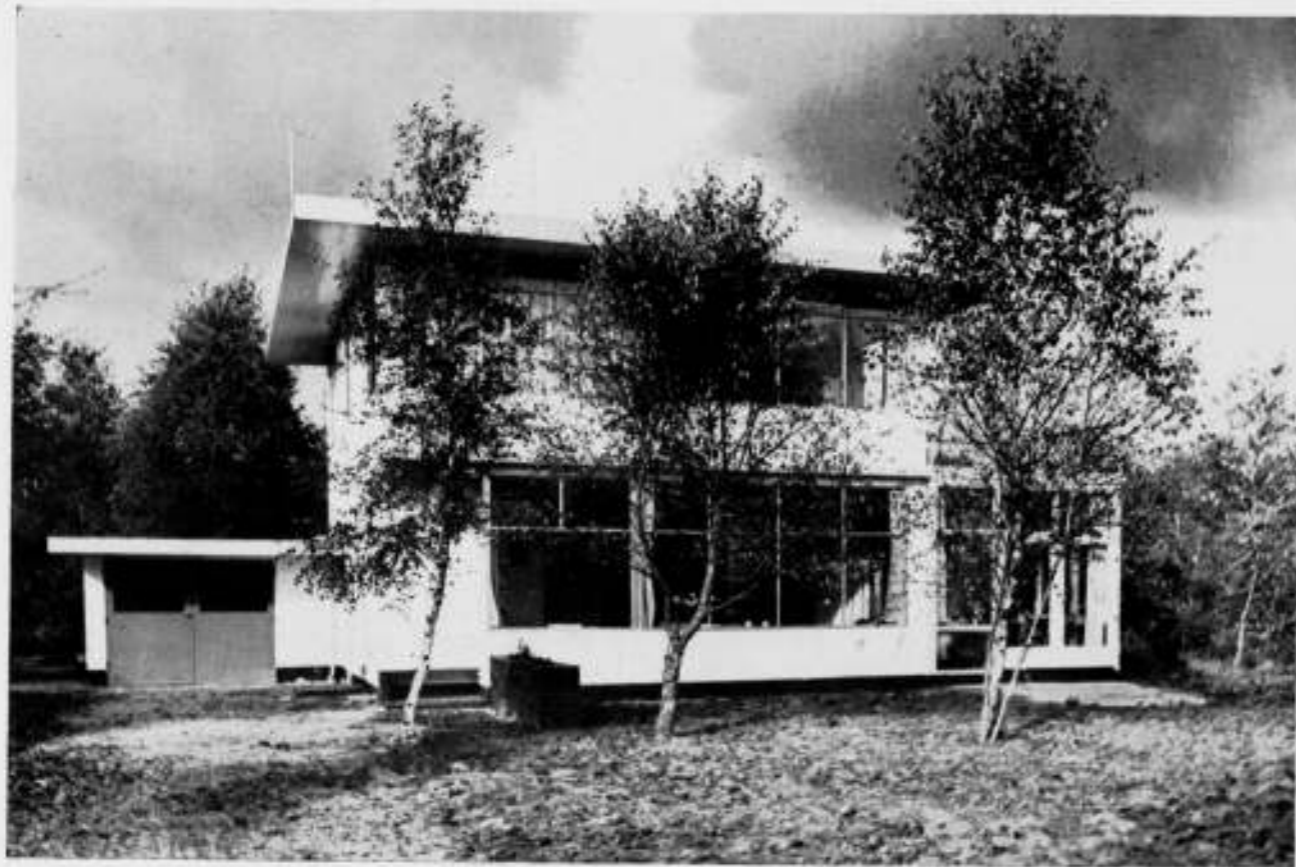
WOONHUIS TE DEN DOLDER
