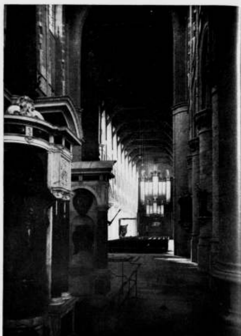
NIEUWE KERK TE DELFT NA DE RESTAURATIE.
