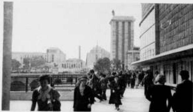
GEZICHT OP HET NIEUWE TROCADERO VANAF DE PONT D'IENA RECHTS HET PAVILJOEN VAN DUITSLAND
