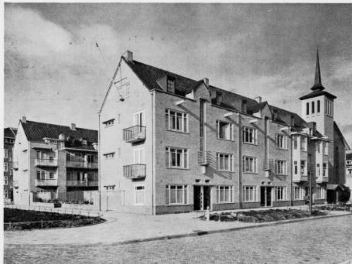
TEHUIS VOOR OUDEN VAN DAGEN E.D. TE AMSTERDAM-ZUID. ARCHITECT TH. J. LAMMERS B.N.A.
