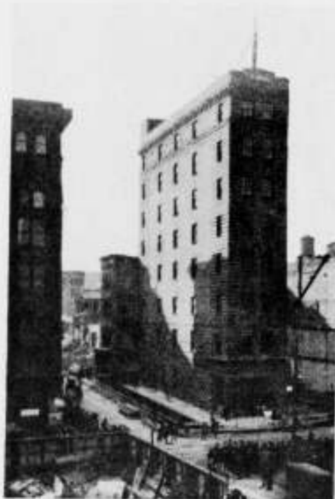
BANKGEBOUW VAN 8 VERDIEPINGEN TIJDENS HET VERROLLEN
