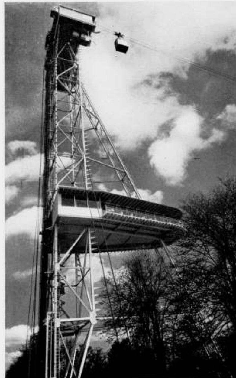
TOREN KABELBAAN LINKER OEVER
