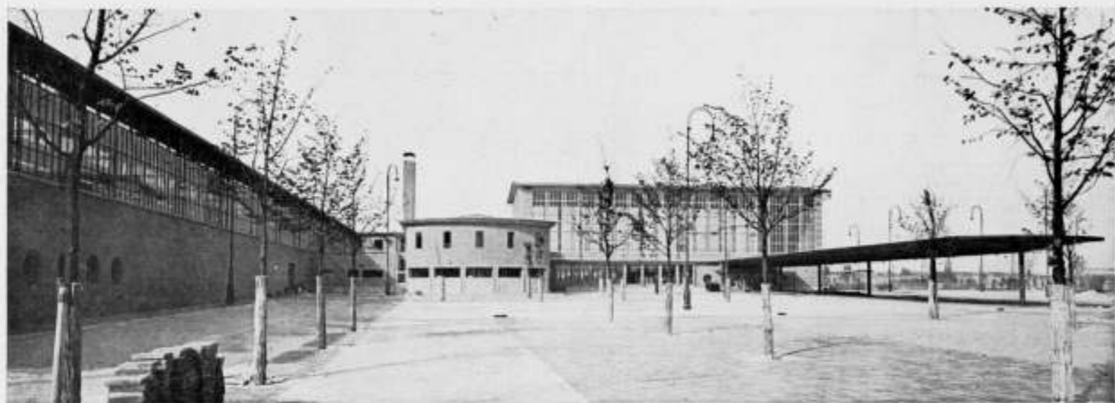
AMSTELSTATION TE AMSTERDAM. HOOFDGEBOUW.
