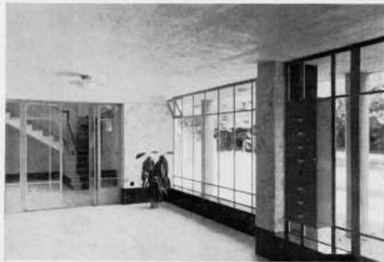
HAL EN INTERIEUR VAN HET FLATGEBOUW AAN DEN BADHUISWEG TE 'S-GRAVENHAGE
