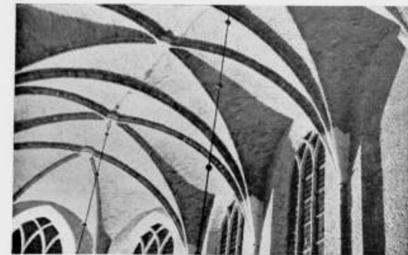
GEWELVEN IN DE NEDERL. HERVORMDE KERK TE GINNEKEN NA RESTAURATIE
