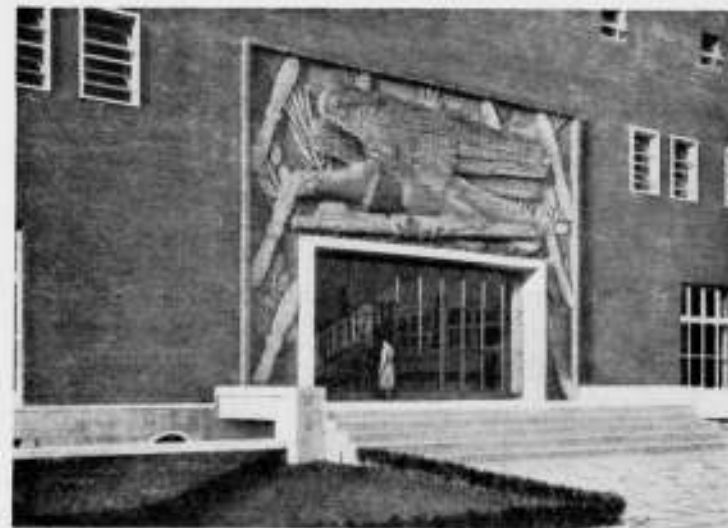
INGANG SCHOOL VOOR VLEIGENIERS TE FLORENCE (L'ARCHITETTURA, NO. 9.)
