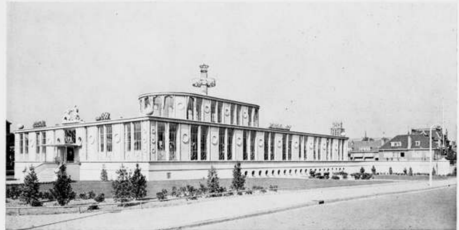
HET NIEUWE GEBOUW DER „HOLLAND VAN 1859" TE DORDRECHT. ARCHITECT IR. S. VAN RAVESTEYN B.N.A.
