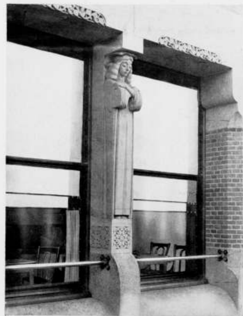
PIJLERFIGUUR. GEBOUW DE „UTRECHT" TE UTRECHT DR. J. MENDES DA COSTA. FECIT
