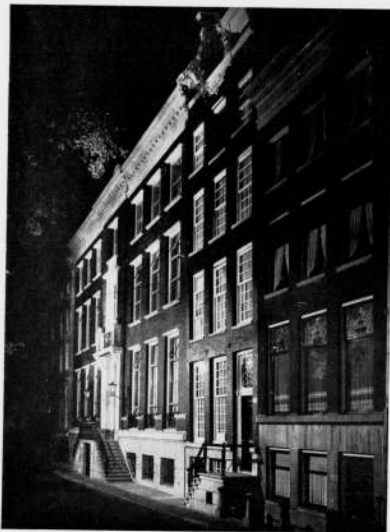
VOORGEVEL BIJ AVONDVERLICHTING KANTOORGEBOUW VAN „DE JAVASCHE BANK" BIJBANK TE AMSTERDAM. ARCHITECTEN POSTHUMUS MEYJES EN VAN DER LINDEN.
