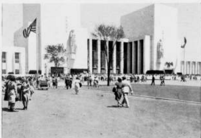
HET „FEDERAL BUILDING“ AAN HET EINDVAN HET COURT OF PEACE
