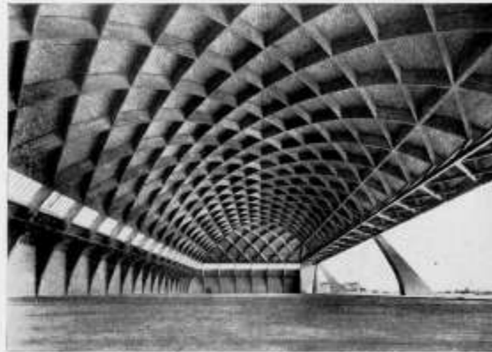
HANGAR VAN GEWAPEND BETON BIJ ROME, ARCH. PIER LUIGI NERVI.
