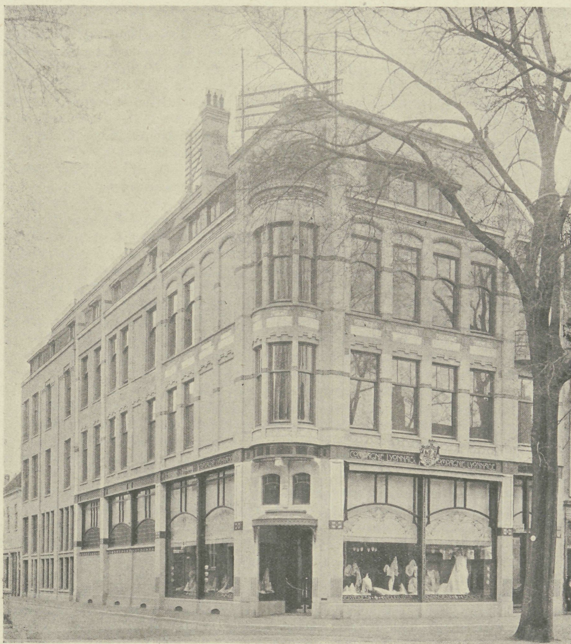
'S GRAVENHAGE, GEBOUW DER „COMPAGNIE LYONNAISE”.
