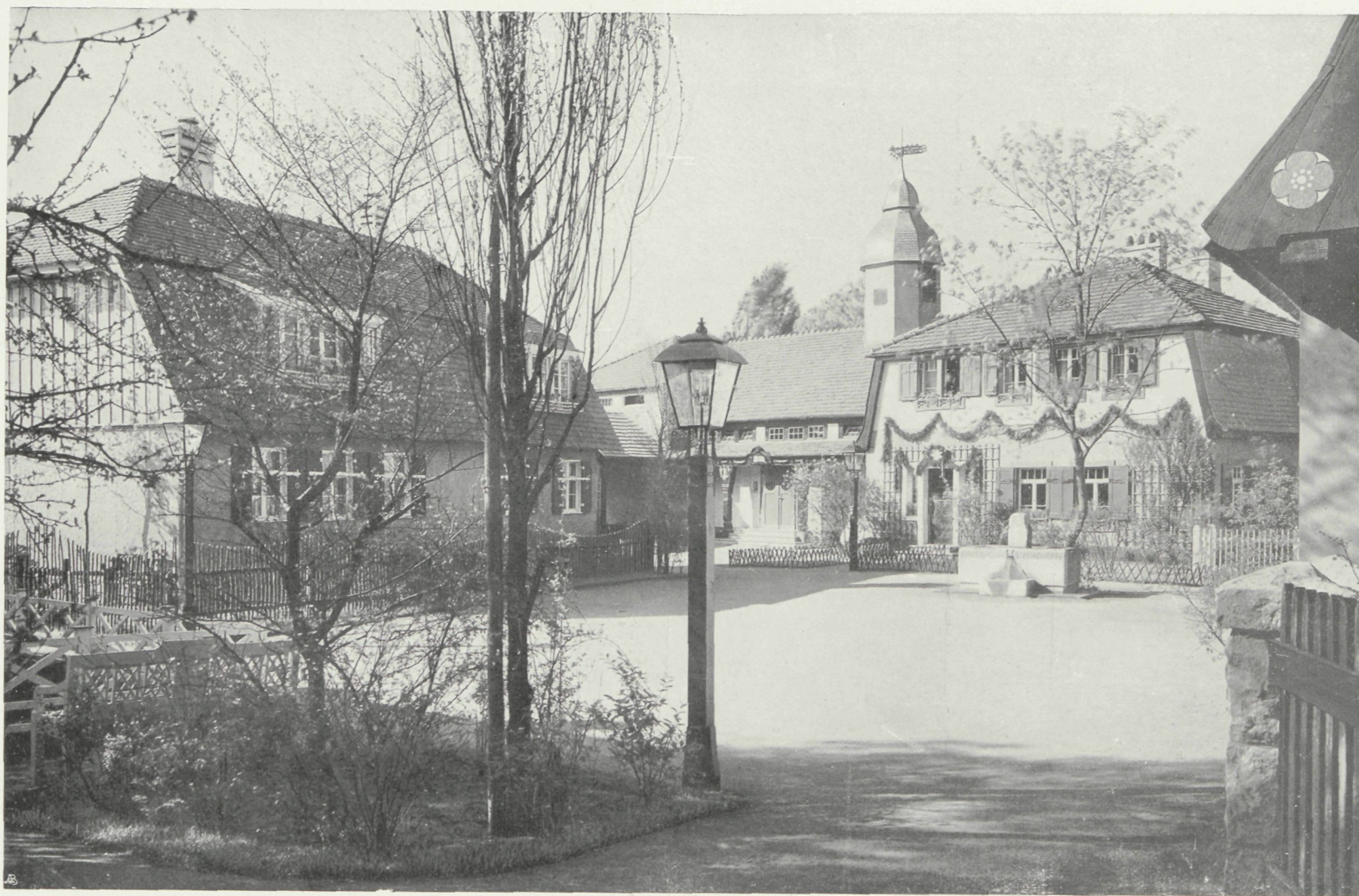
HET DORSPLEIN DER TENTOONSTELLING. RECHTS: SCHOOL EN ONDERWIJZERSWONING DER GEMEENTE NEU-EIBAU IN DE OBERLAUSITZ, ARCH. ERNST KÜHN (DRESDEN); LINKS: ARBEIDERSWONING, ARCH. RICHARD BAUER (LEIPZIG)
