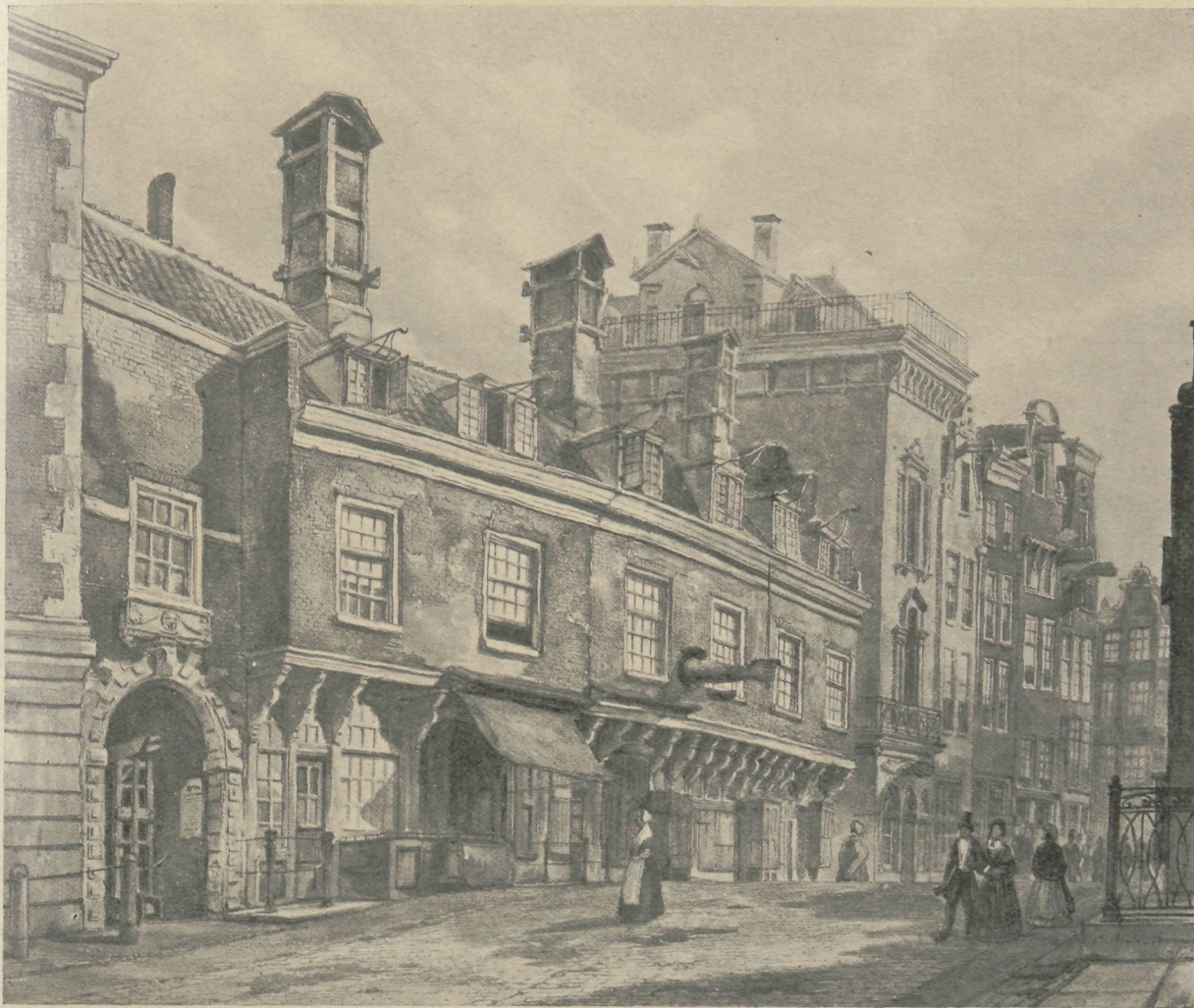
HUIZEN OP DEN VIJGENDAM GEDEELTELIJK AFGEBROKEN IN 1847
