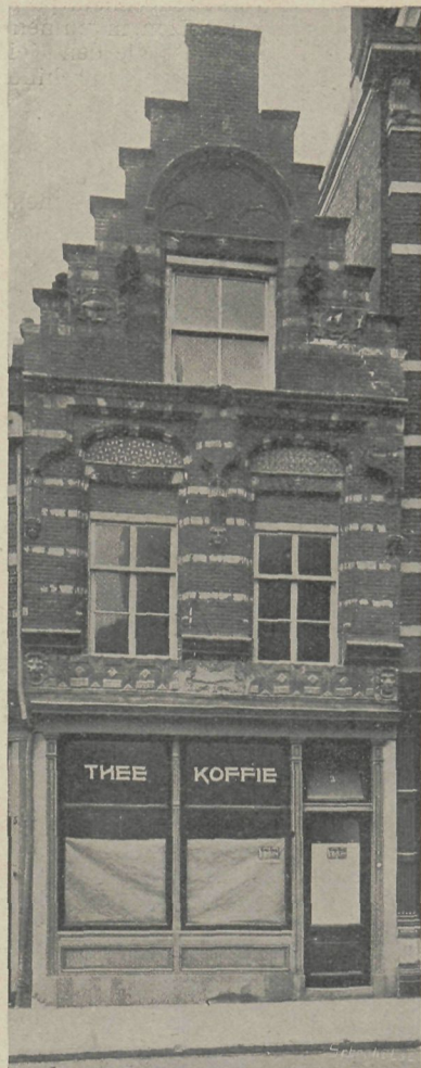
TOESTAND VOOR DE RESTAURATIE
