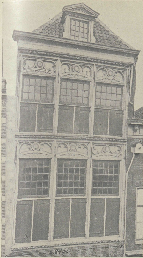
VOOR DE RESTAURATIE
