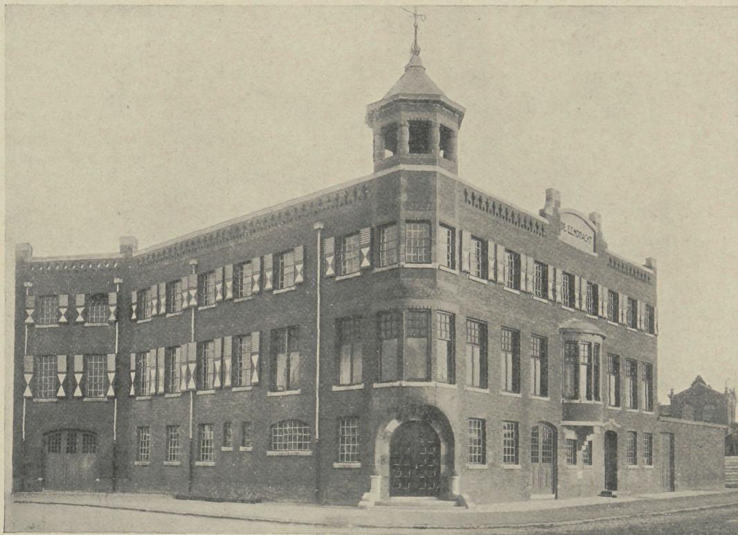
GRONINGEN. MAGAZIJN EN KANTOORGEBOUW EENDRACHTSWEG HOEK WILLEM BARENDT SZSTRAAT. (BEKROOND IN DEN GEVELWEDSTRIJD). ARCH. P. M. A. HUURMAN
