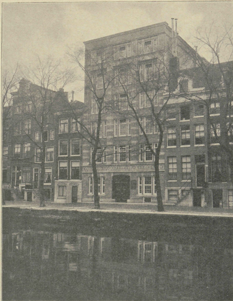
AMSTERDAM. KANTOOR EN MAGAZIJN DER FIRMA RATH & DOODEHEEFVER. PRINSENGRACHT 734-36. ARCH. A. JACOT
